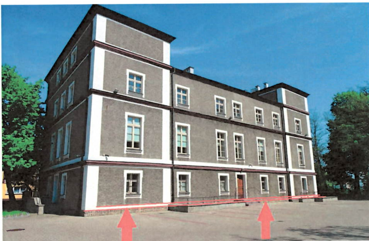
Fot.2 – Oznaczenie lokalizacji wykonania odświeżenia opaski z tynku na wys. ok. 20 cm (białe pasy). Na szerokości gdzie nie ma istniejącej opaski – nie uzupełniać, wykonać odświeżenie. Zastosować tynki nawiązując do istniejącego tj. cementowo – wapiennego lub wapiennego. (widok elewacji południowej)
