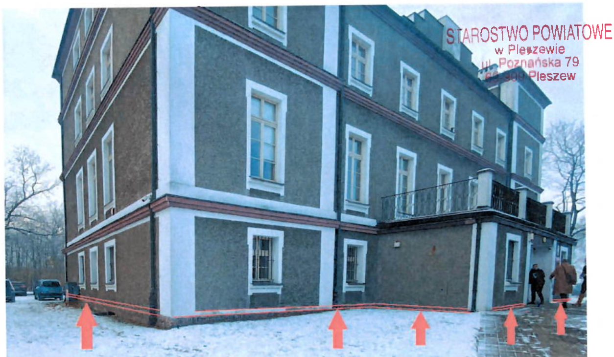
Fot.5 – Oznaczenie lokalizacji wykonania odświeżenia opaski z tynku na wys. ok. 20 cm (białe pasy). Na szerokości gdzie nie ma istniejącej opaski – nie uzupełniać, wykonać odświeżenie. Zastosować tynki nawiązując do istniejącego tj. cementowo – wapiennego lub wapiennego. (widok elewacji północnej oraz wschodniej).
