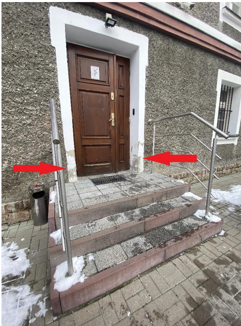
Fot.6 – Oznaczenie lokalizacji wykonania odświeżenia opaski z tynku (obramowanie drzwi - białe pasy). Zastosować tynki nawiązując do istniejącego tj. cementowo – wapiennego lub wapiennego. Zastosowanie odbojników.
