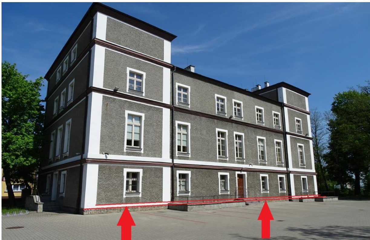
Fot.2 – Oznaczenie lokalizacji wykonania odświeżenia opaski z tynku na wys. ok. 20 cm (białe pasy). Na szerokości gdzie nie ma istniejącej opaski – nie uzupełniać, wykonać odświeżenie. Zastosować tynki nawiązując do istniejącego tj. cementowo – wapiennego lub wapiennego.(widok elewacji południowej)
