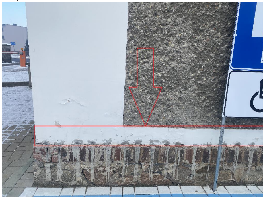
Fot.1 – Oznaczenie lokalizacji wykonania odświeżenia opaski z tynku na wys. ok. 20 cm (widok elewacji południowej), widoczne uszkodzenia w elewacji.
