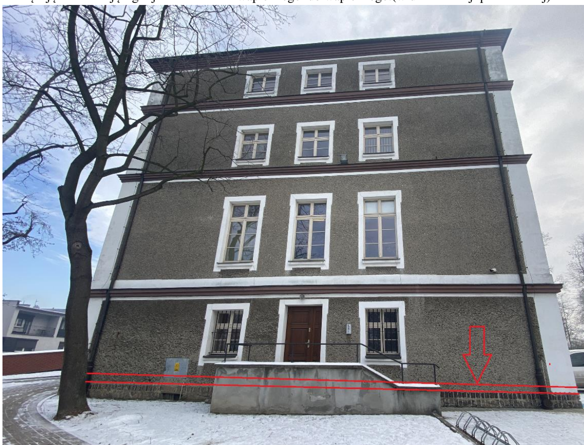
Fot.3 – Oznaczenie lokalizacji wykonania odświeżenia fragmentu tynku (widok elewacji zachodniej). Zastosować tynki nawiązując do istniejącego tj. cementowo – wapiennego lub wapiennego.
