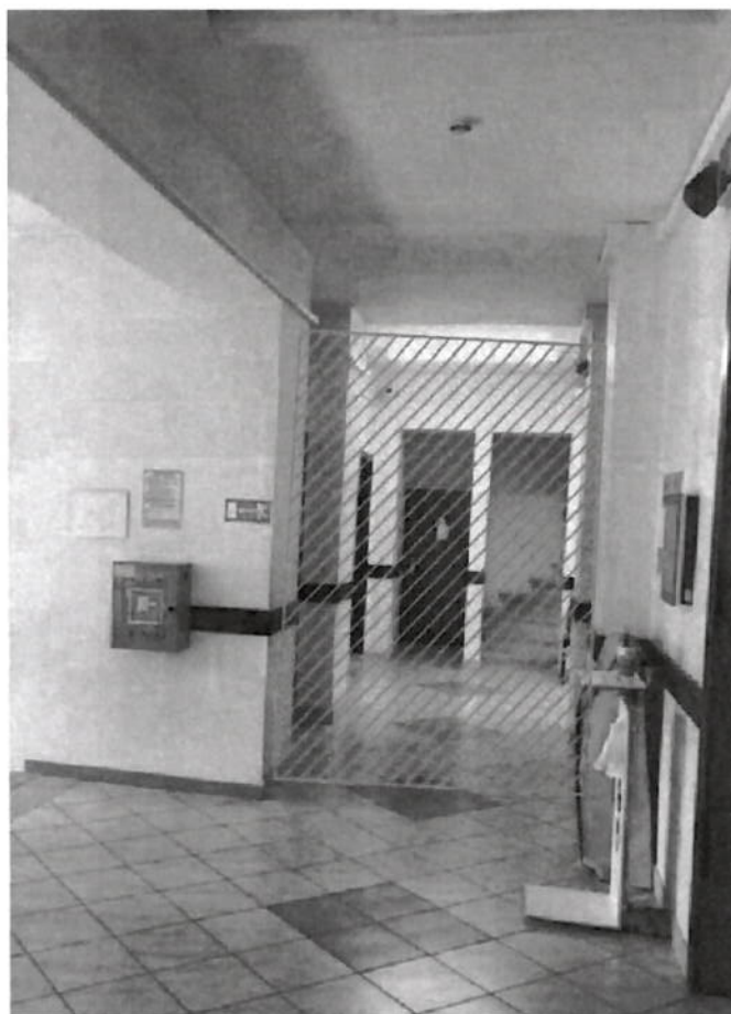
Fot.1. Proponowana lokalizacja drzwi przeciwpożarowych w klasie EI 60 odporności ogniowej do klatki schodowej K1
