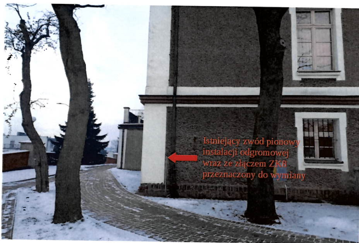
Fot.8. Widok istniejącego zwodu pionowego instalacji odgromowej wraz ze złączem kontrolno-pomiarowym ZK8 na elewacji zachodniej budynku sądu przeznaczony do wymiany
