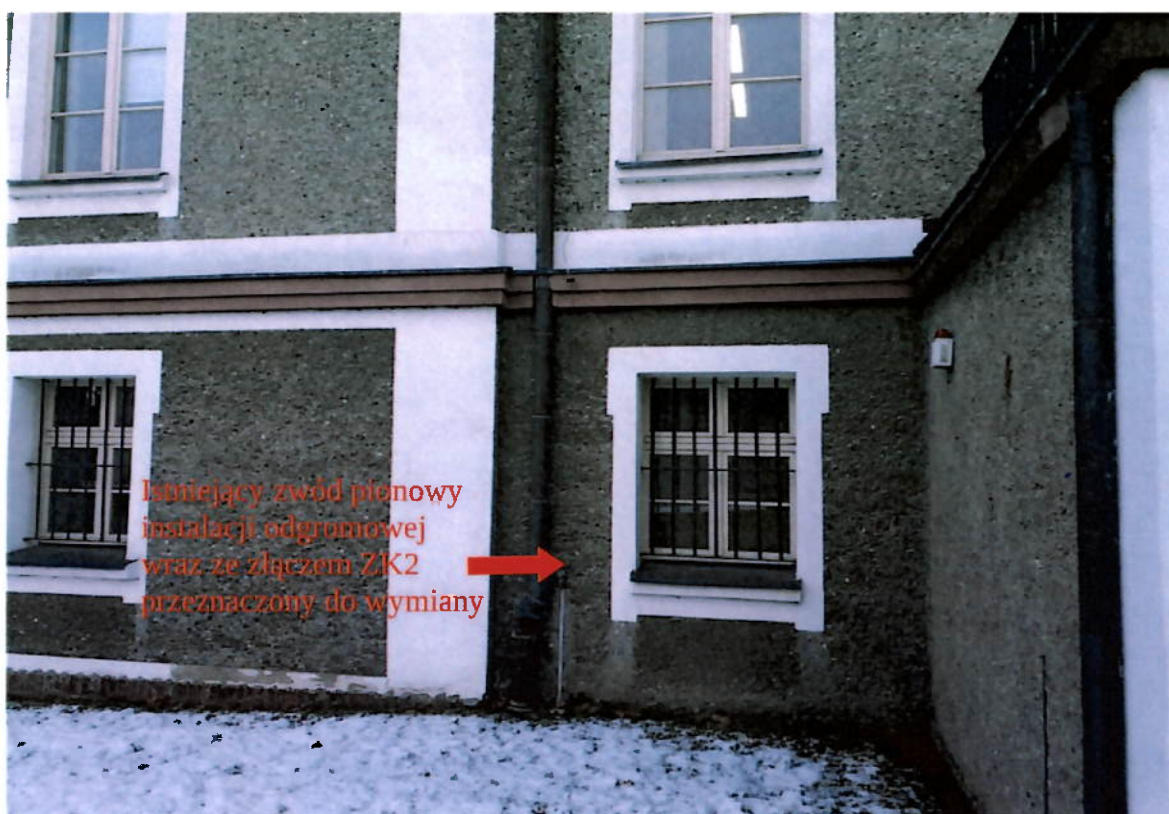
Fot.2. Widok istniejącego zwodu pionowego instalacji odgromowej wraz ze złączem kontrolno-pomiarowym ZK2 na elewacji północnej budynku sądu przeznaczony do wymiany
