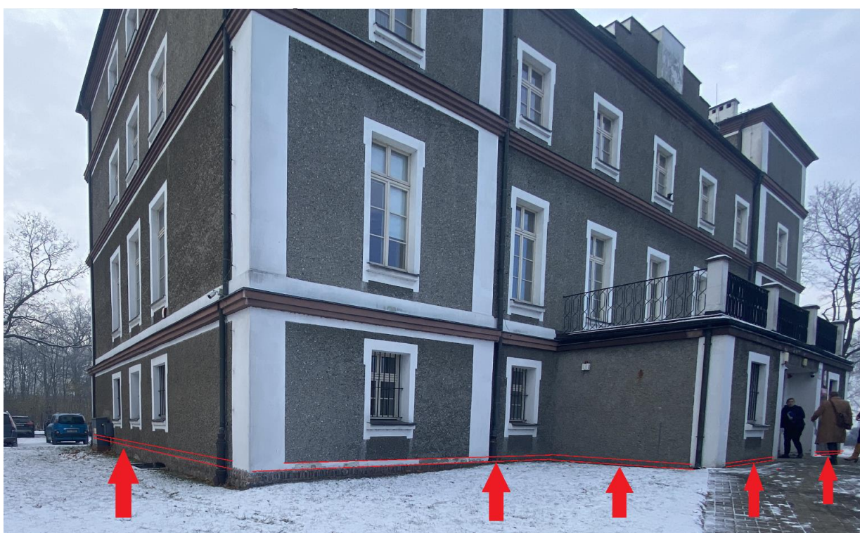
Fot.5 – Oznaczenie lokalizacji wykonania odświeżenia opaski z tynku na wys. ok. 20 cm (białe pasy). Na szerokości gdzie nie ma istniejącej opaski – nie uzupełniać, wykonać odświeżenie. Zastosować tynki nawiązując do istniejącego tj. cementowo – wapiennego lub wapiennego. (widok elewacji północnej oraz wschodniej).
