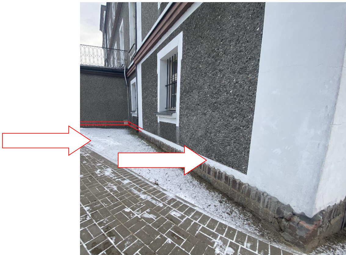
Fot.4 – Oznaczenie lokalizacji wykonania odświeżenia opaski z tynku na wys. ok. 20 cm (białe pasy). Na szerokości gdzie nie ma istniejącej opaski – nie uzupełniać, wykonać odświeżenie. Zastosować tynki nawiązując do istniejącego tj. cementowo – wapiennego lub wapiennego.
