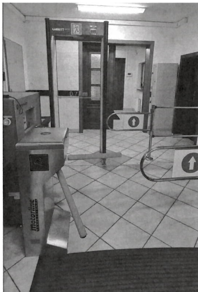
Fot.3. Zawężenia szerokości drogi ewakuacyjnej przez bramki kontrolne
