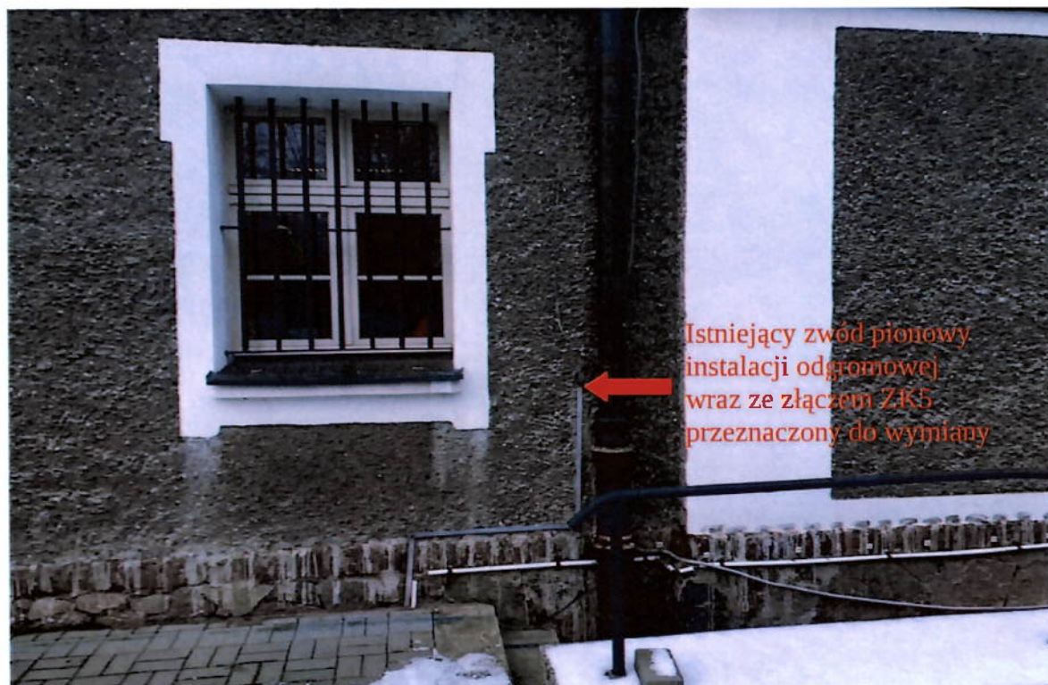
Fot.5. Widok istniejącego zwodu pionowego instalacji odgromowej wraz ze złączem kontrolno-pomiarowym ZK5 na elewacji południowej budynku sądu przeznaczony do wymiany
