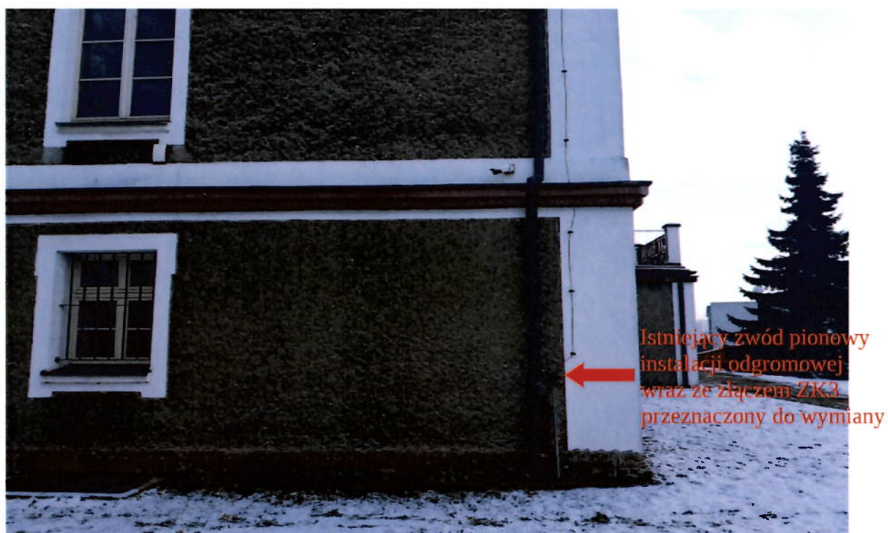
Fot.3. Widok istniejącego zwodu pionowego instalacji odgromowej wraz ze złączem kontrolno-pomiarowym ZK3 na elewacji wschodniej budynku sądu przeznaczony do wymiany
