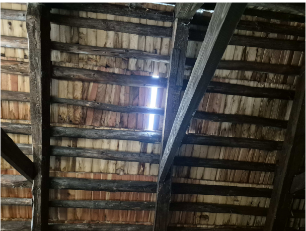
Uszkodzon pokrycie z gontów zdjęcie Nr. 2
