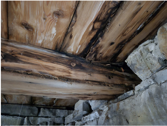
Uszkodzona belka stropowa zdjęcie Nr. 1
