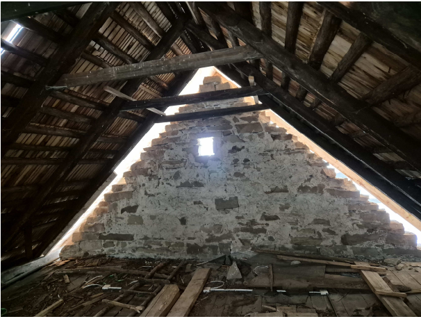
Brak podmurowania ściany szczytowej z kamienia pod konstrukcją dachu - zdjęcie Nr. 1
