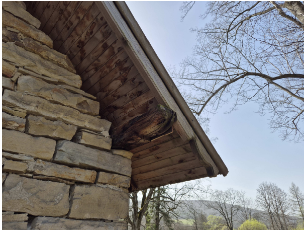
Uszkodzona końcówka murlaty zdjęcie Nr. 5
