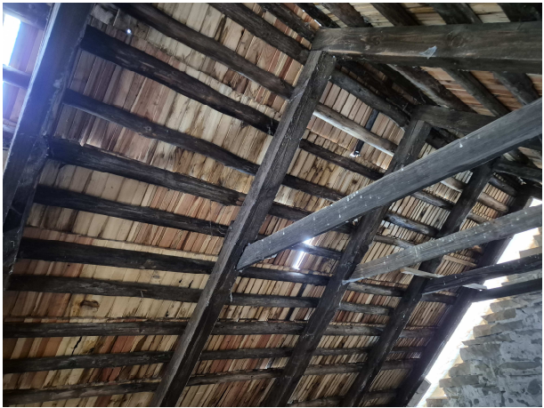
Uszkodzon pokrycie z gontów zdjęcie Nr. 4
