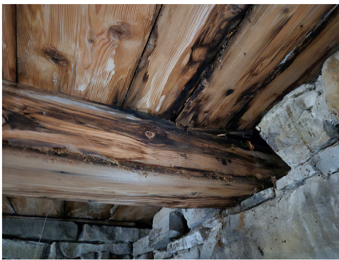
Widok uszkodzonej belki stropowej
