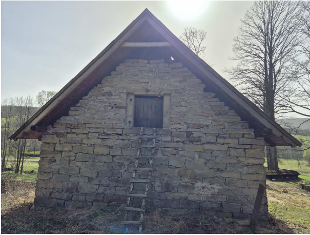
Brak podmurowania ściany szczytowej z kamienia pod konstrukcją dachu - zdjęcie Nr. 3
