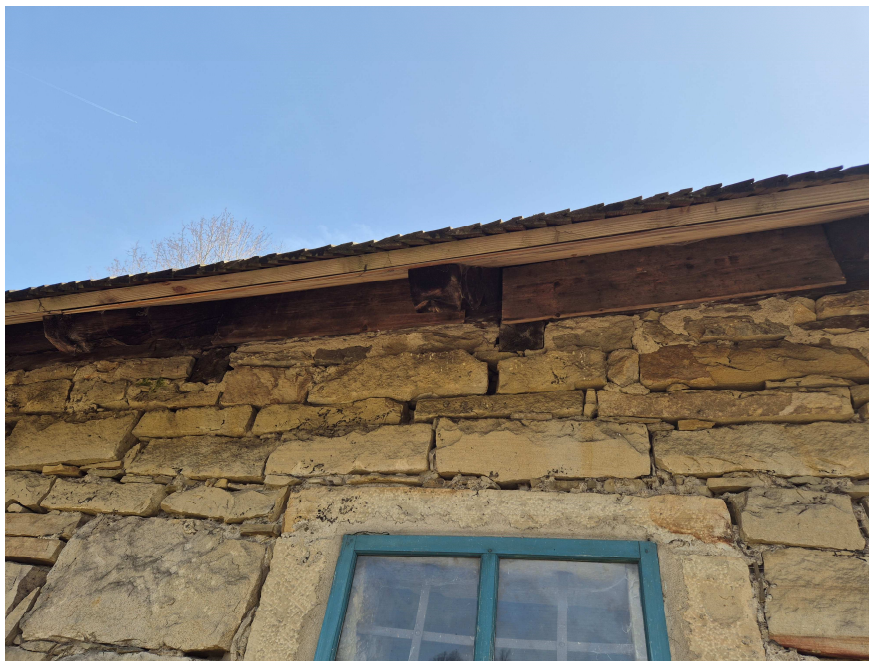
Widok oparcia belek stropowych
