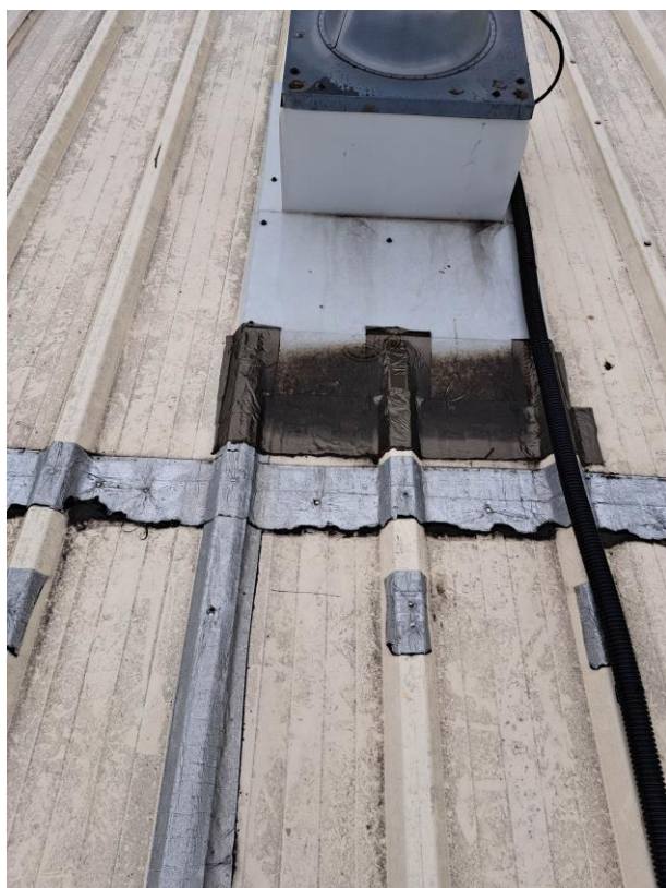
Mocowanie i uszczelnienie podstaw wentylatorów dachowych
