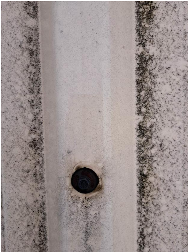
Widoczne mocowanie płyt warstwowych
