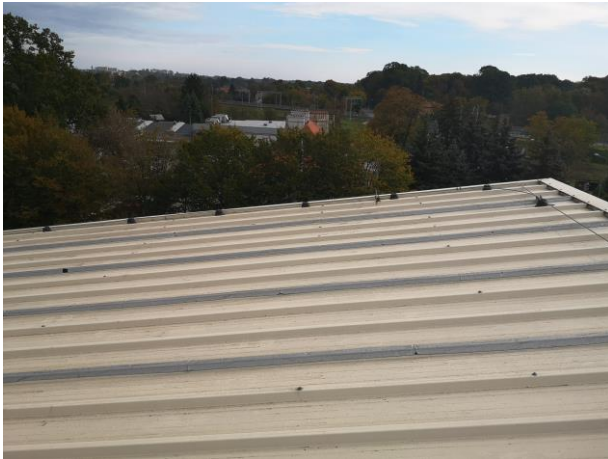
Widok na poszycie dachowe istniejąca płyta warstwowa dachowa SP2C 140/100
