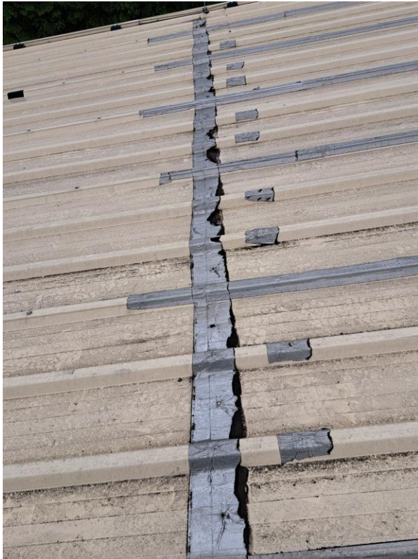
Zamki istniejącej płyty warstwowej w rozstawie – co ok. 30 cm
