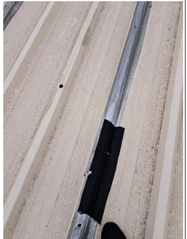
Należy wziąć pod uwagę rozstaw profili przy doborze nowego poszycia dachowego
