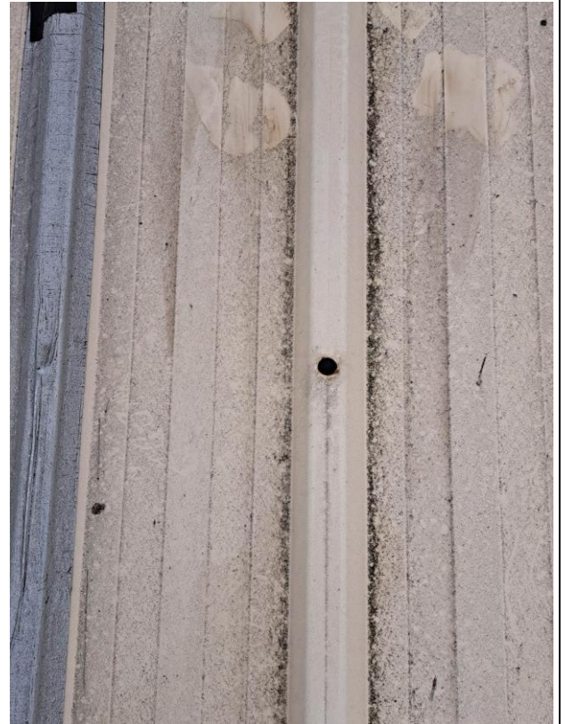
Istniejąca płyta warstwowa dachowa SP2C 140/100 z bliska
