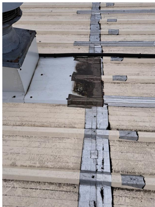
Mocowanie i uszczelnienie podstaw wentylatorów dachowych – styki płyt „uszczelnione” taśmą dekarstką
