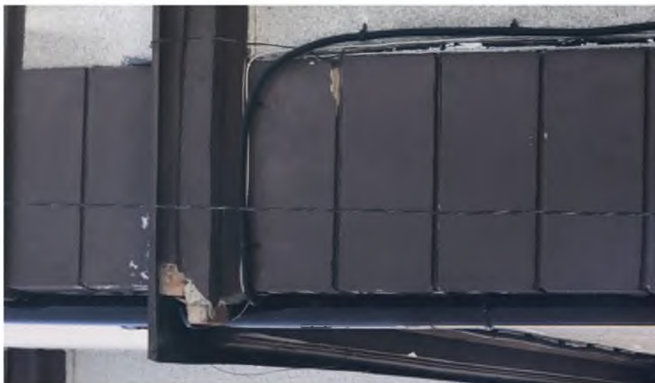
Fot. nr 10 – Budynek Prokuratury Rejonowej w Strzelinie. Widoczne zniszczenia boniowania i gzymsów. Stan obecny. Zdjęcie wykonała M. Podgórska-Makal
