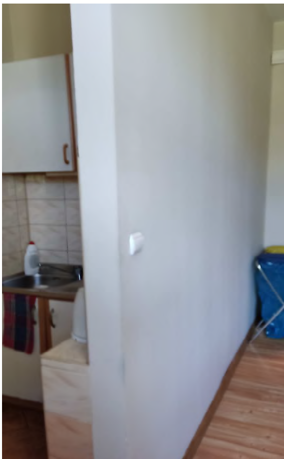
Fot. nr. 6 Ściana w suchej zabudowie Fot. nr. 7 Ściana z cegły pełnej
