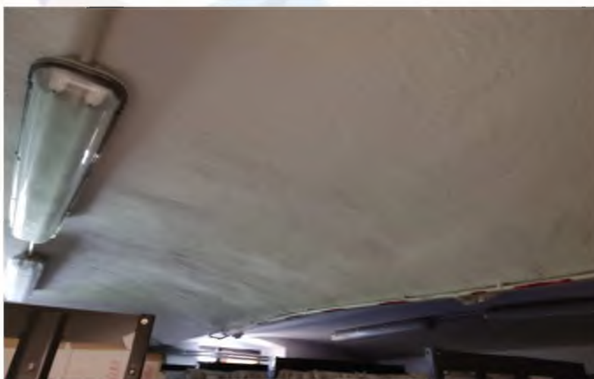
Fot. nr.3 Strop łukowy Kleina
