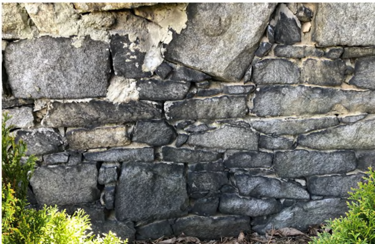
Fot. nr 5– Budynek Prokuratury Rejonowej w Strzelinie – mur ogrodzeniowy. Widoczne naprawy mocną zaprawą cementową. Zdjęcie wykonała M. Podgórska-Makal
