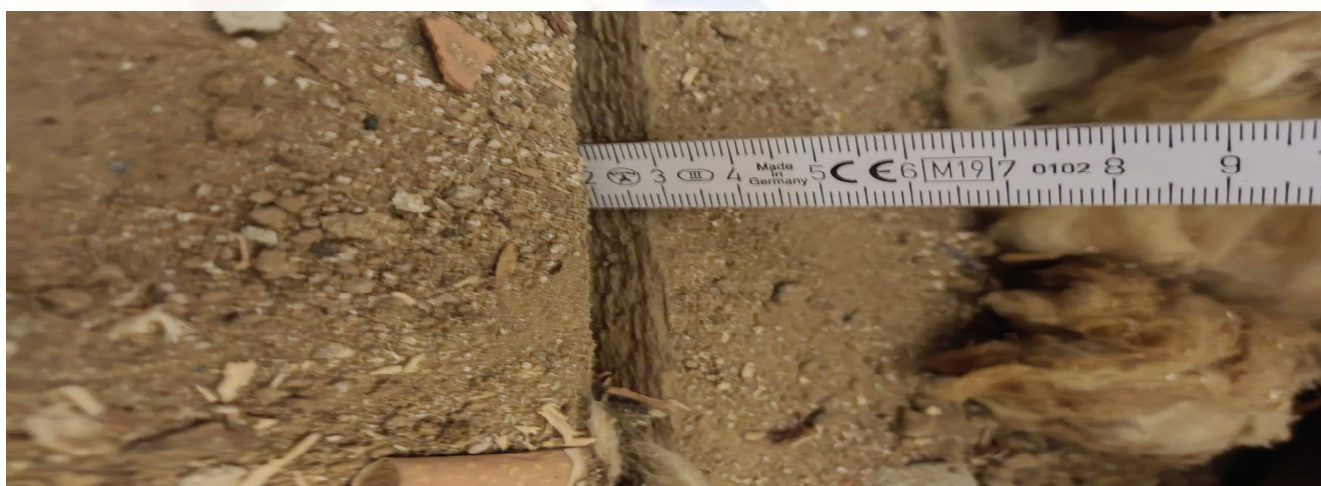
Fot. nr. 10 Poszycie stropu z deski drewnianej
