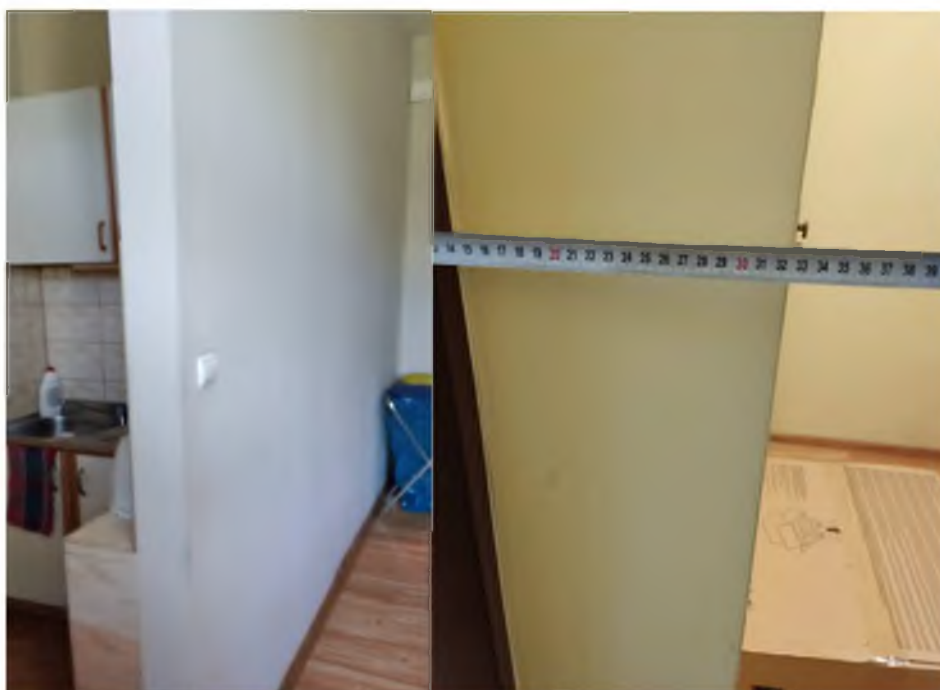
Fot. nr. 6 Ściana w suchej zabudowie Fot. nr. 7 Ściana z cegły pełnej
