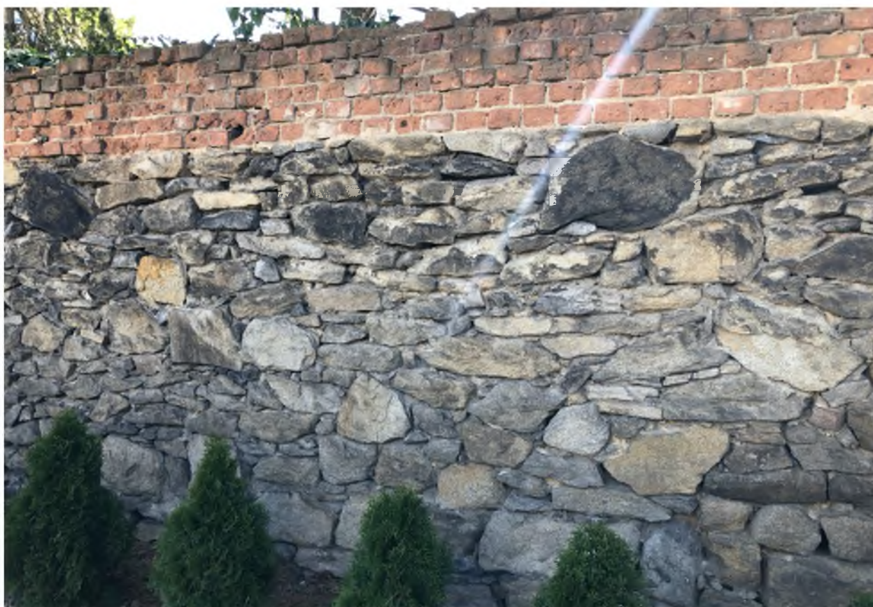
Fot. nr 1 – Budynek Prokuratury Rejonowej w Strzelinie – mur ogrodzeniowy. Widoczne zniszczenie korony muru. Stan obecny. Zdjęcie wykonana M. Podgórska-Makal
