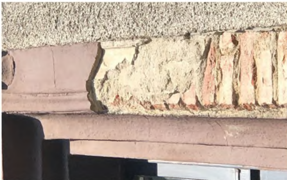
Fot. nr 9 – Budynek Prokuratury Rejonowej w Strzelinie — zniszczenia obramienia okna na elewacji południowej. Stan obecny. Zdjęcie wykonała M. Podgórska-Makal
