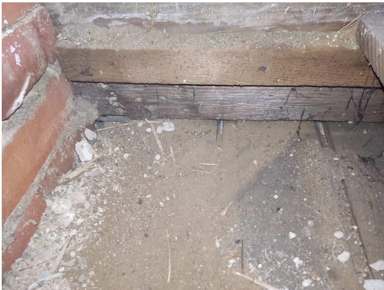
Fot.nr. 12 Belki nośne i poszycie spodnie stropu drewnianego
