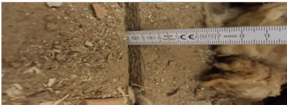
Fot. nr. 10 Poszycie stropu z deski drewnianej
