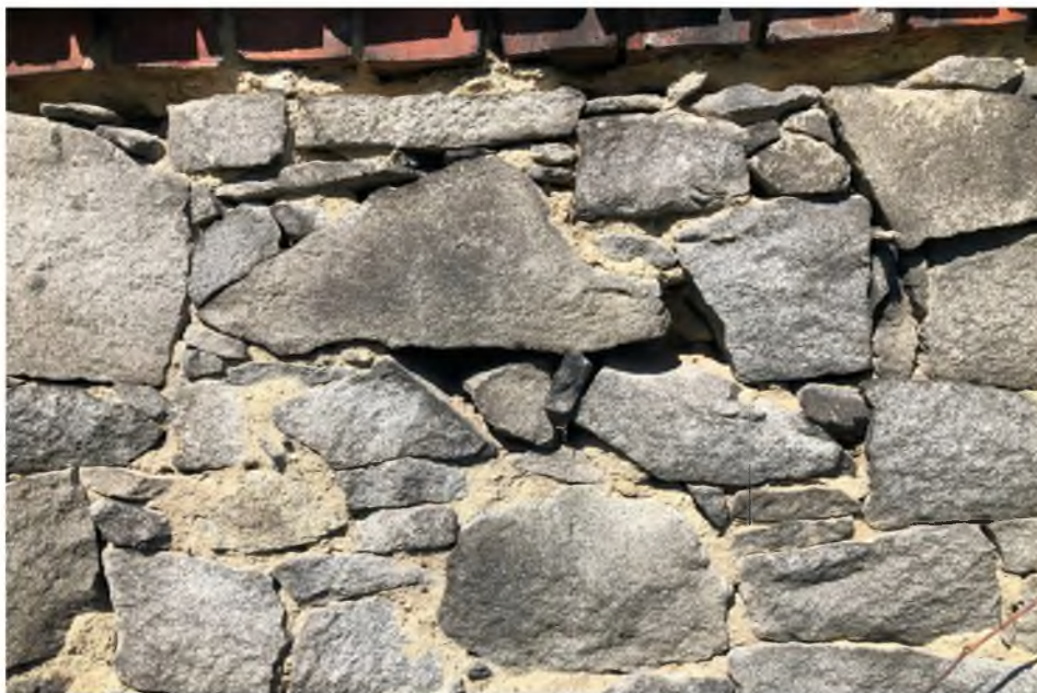
Fot. nr 11 – Budynek Prokuratury Rejonowej w Strzelinie. - mur ogrodzeniowy. Widoczne kawerny po zniszczonej zaprawie spajającej mur. Zdjęcie wykonana M. Podgórska-Makal
