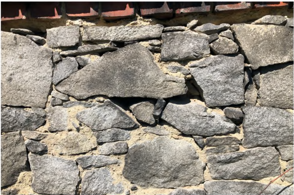
Fot. nr 11 – Budynek Prokuratury Rejonowej w Strzelinie. - mur ogrodzeniowy. Widoczne kawerny po zniszczonej zaprawie spajającej mur. Zdjęcie wykonała M. Podgórska-Makal
