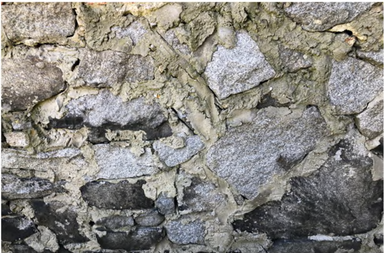
Fot. nr 7 – Budynek Prokuratury Rejonowej w Strzelinie — mur ogrodzeniowy. Widoczne cementowe wtórne fugi. Stan obecny. Zdjęcie wykonała M. Podgórska-Makal
