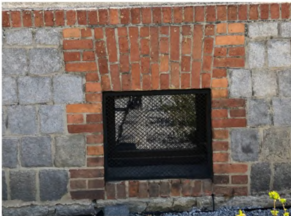
Fot. nr 7 – Budynek Prokuratury Rejonowej w Strzelinie — partia cokołowa. Widoczne zniszczone oryginalne fugi. Stan obecny. Zdjęcie wykonana M. Podgórska-Makal
