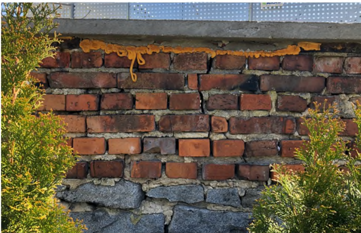
Fot. nr 9 – Budynek Prokuratury Rejonowej w Strzelinie — mur ogrodzeniowy. Widoczne pęknięcia oraz naprawy pianką. Zdjęcie wykonała M. Podgórska-Makal
