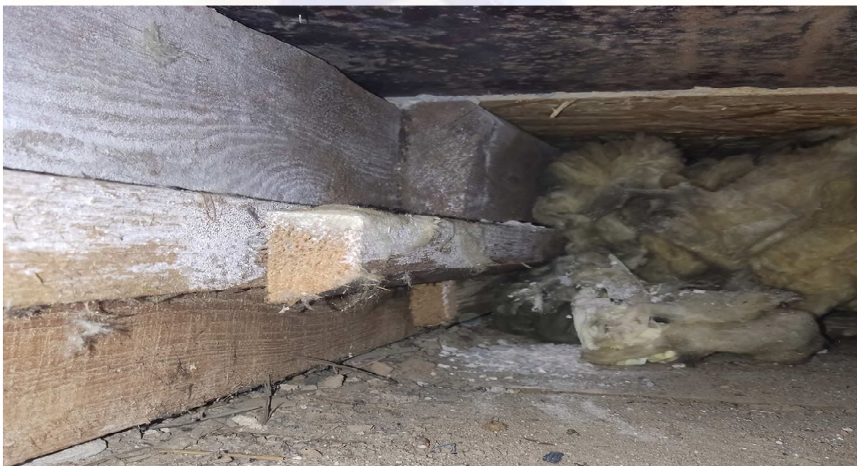
Fot. nr. 8 Belki drewniane stropu międzykondygnacyjnego
