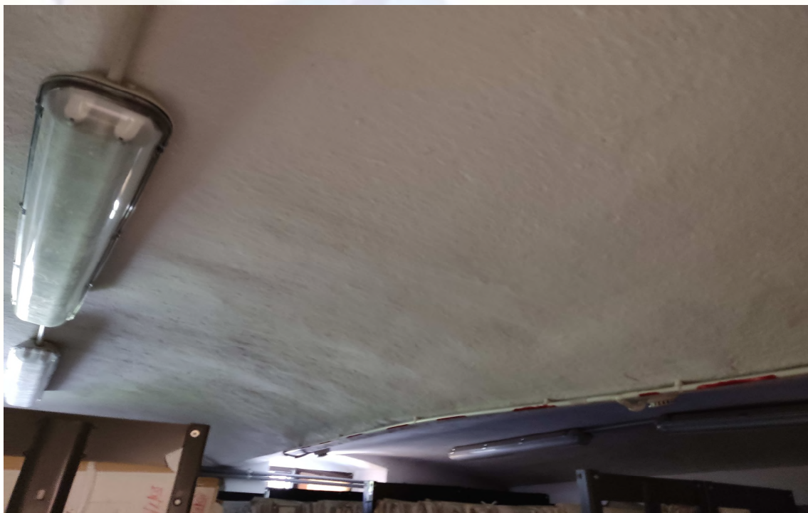
Fot. nr.3 Strop łukowy Kleina
