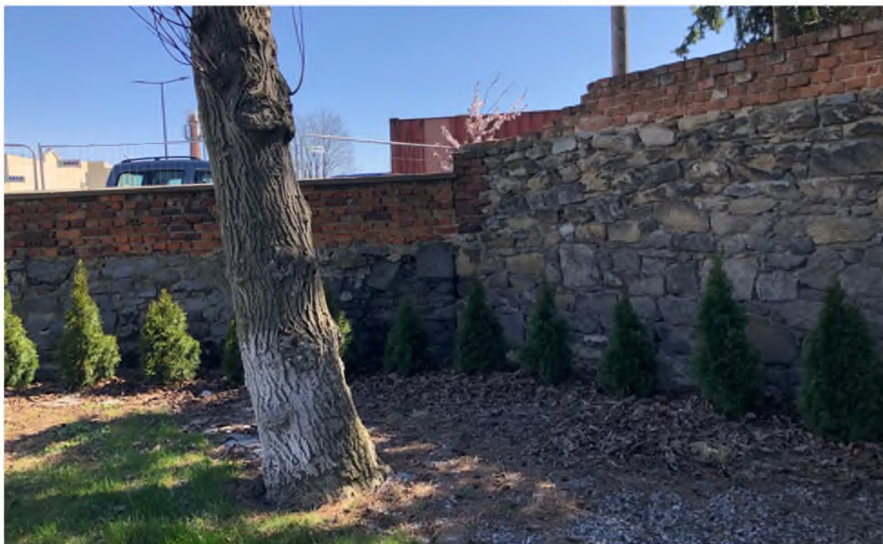
Fot. nr 2 – Budynek Prokuratury Rejonowej w Strzelinie – mur ogrodzeniowy. Widoczne zniszczenie korony muru. Stan obecny. Zdjęcie wykonana M. Podgórska-Makal
