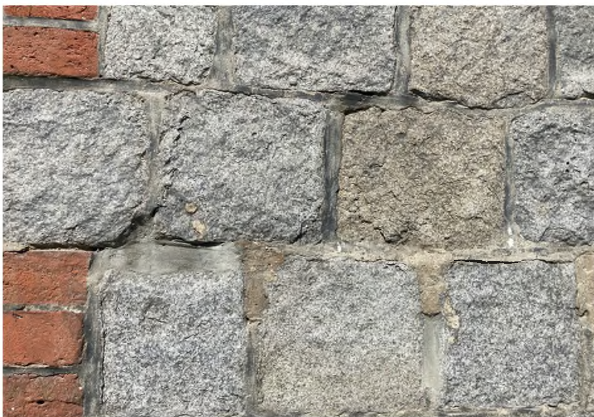
Fot. nr 11 – Partia cokołowa, widoczne złuszczenia płyt granitowych i zniszczona fuga. Zdjęcie wykonała M.Podgórska-Makal
