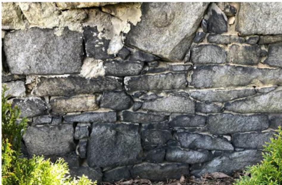
Fot. nr 5– Budynek Prokuratury Rejonowej w Strzelinie – mur ogrodzeniowy. Widoczne naprawy mocną zaprawą cementową. Zdjęcie wykonała M. Podgórska-Makal
