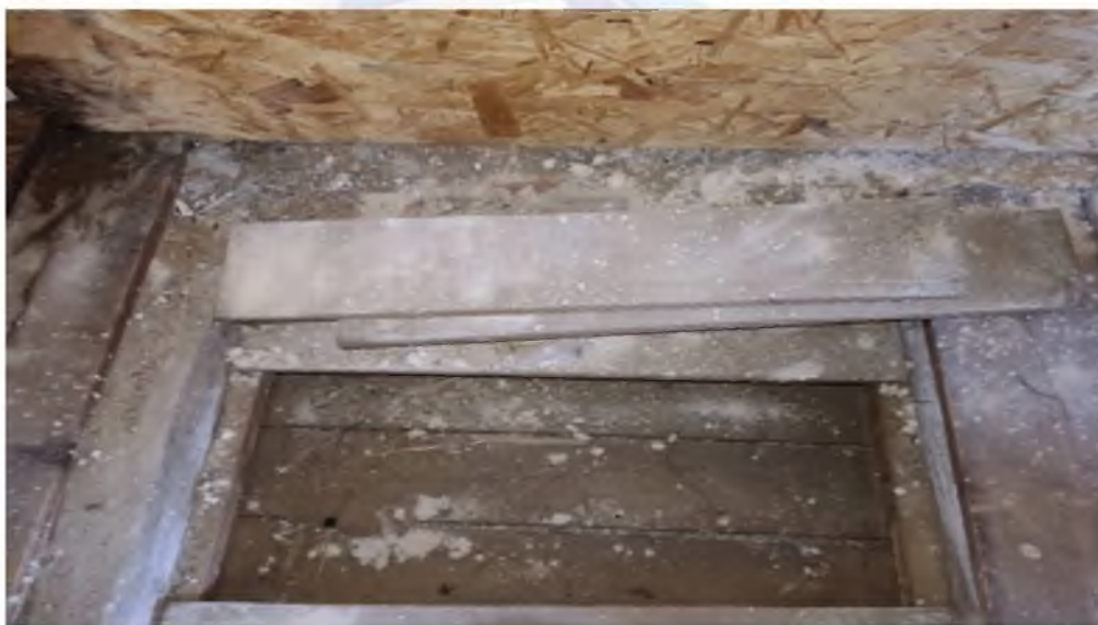
Fot. nr. 13 Podłoga ślepa stropu międzykondygnacyjnego
