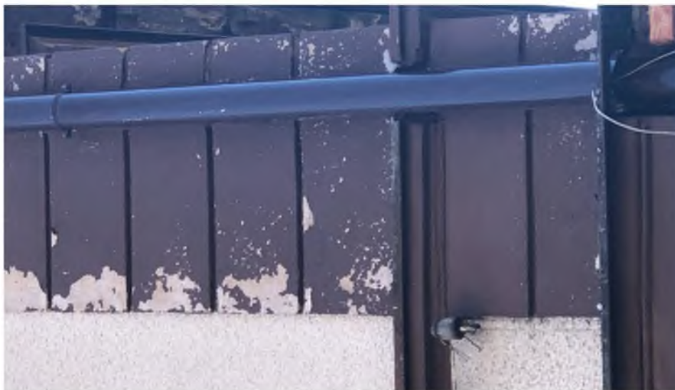
Fot. nr 8 – Budynek Prokuratury Rejonowej w Strzelinie — boniowanie. Widoczna łuszcząca się farba na boniach. Stan obecny. Zdjęcie wykonana M. Podgórska-Makal
