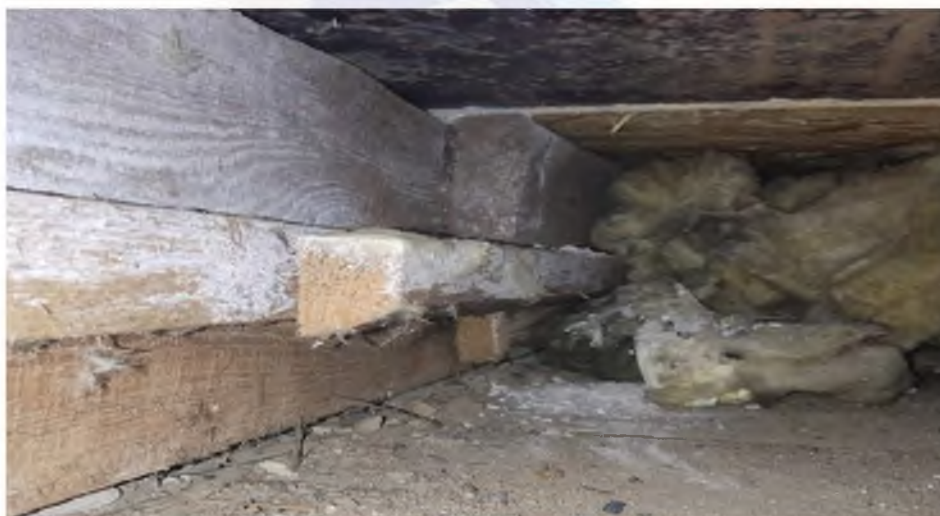
Fot. nr. 8 Belki drewniane stropu międzykondygnacyjnego
