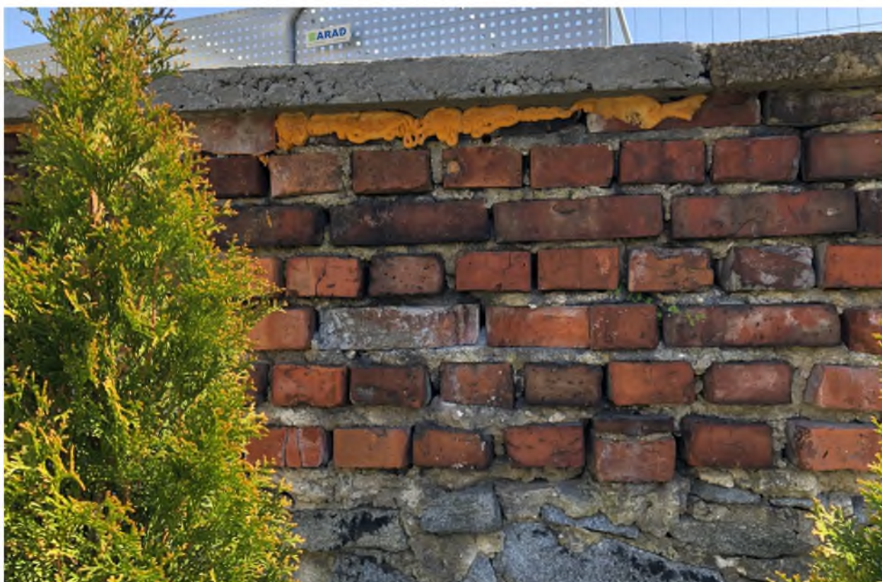
Fot. nr 4– Budynek Prokuratury Rejonowej w Strzelinie – mur ogrodzeniowy. Widoczne zniszczenie korony muru. Stan obecny. Zdjęcie wykonała M. Podgórska-Makal
