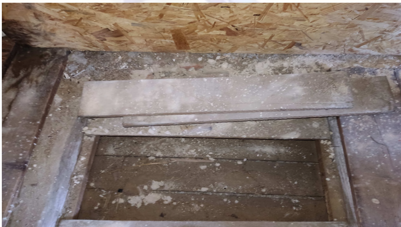
Fot. nr. 13 Podłoga ślepa stropu międzykondygnacyjnego
