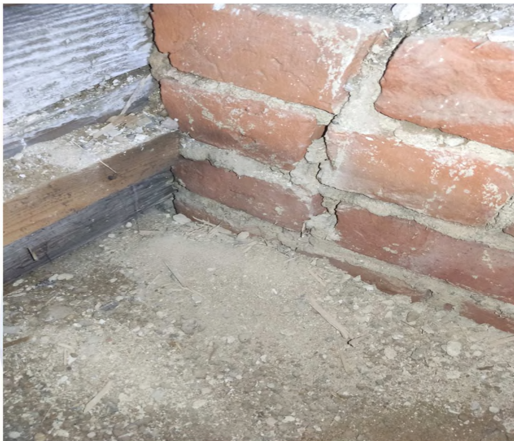
Fot.nr. 4 Ściana konstrukcyjna z cegły pełnej
