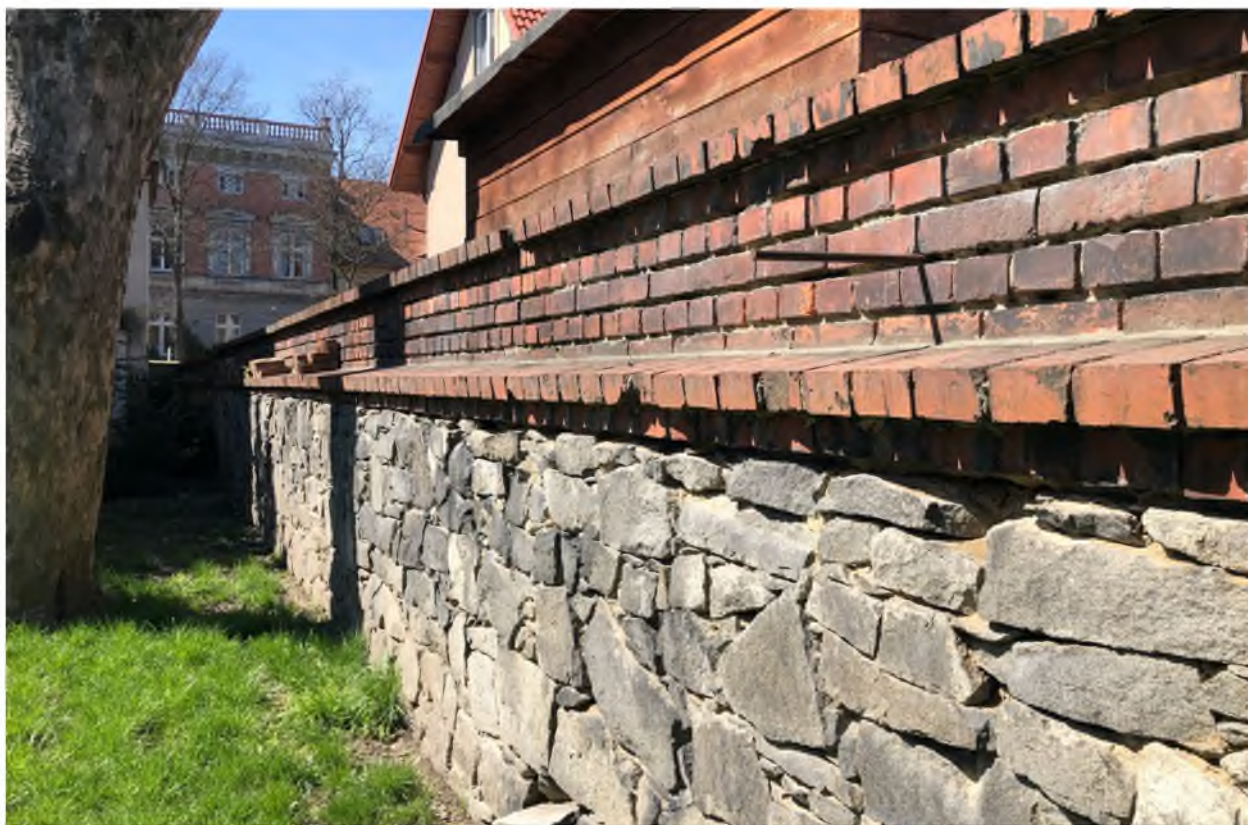
Fot. nr 12 – Budynek Prokuratury Rejonowej w Strzelinie. - mur ogrodzeniowy. Zniszczenia ceglanej korony muru. Zdjęcie wykonała M. Podgórska-Makal
