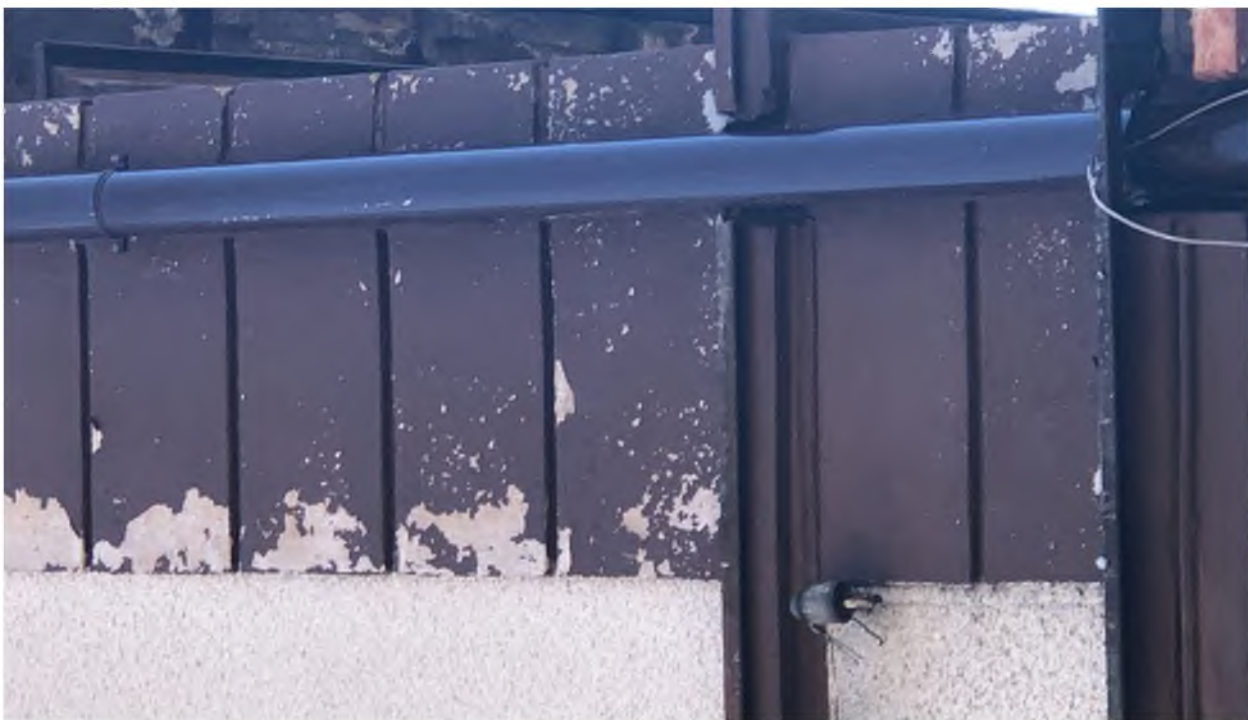
Fot. nr 8 – Budynek Prokuratury Rejonowej w Strzelinie — boniowanie. Widoczna łuszcząca się farba na boniach. Stan obecny. Zdjęcie wykonała M. Podgórska-Makal
