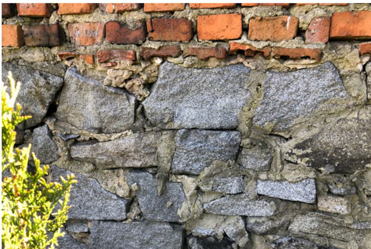
Fot. nr 6 – Budynek Prokuratury Rejonowej w Strzelinie – mur ogrodzeniowy. Widoczne naprawy mocną zaprawą cementową. Zdjęcie wykonała M. Podgórska-Makal
