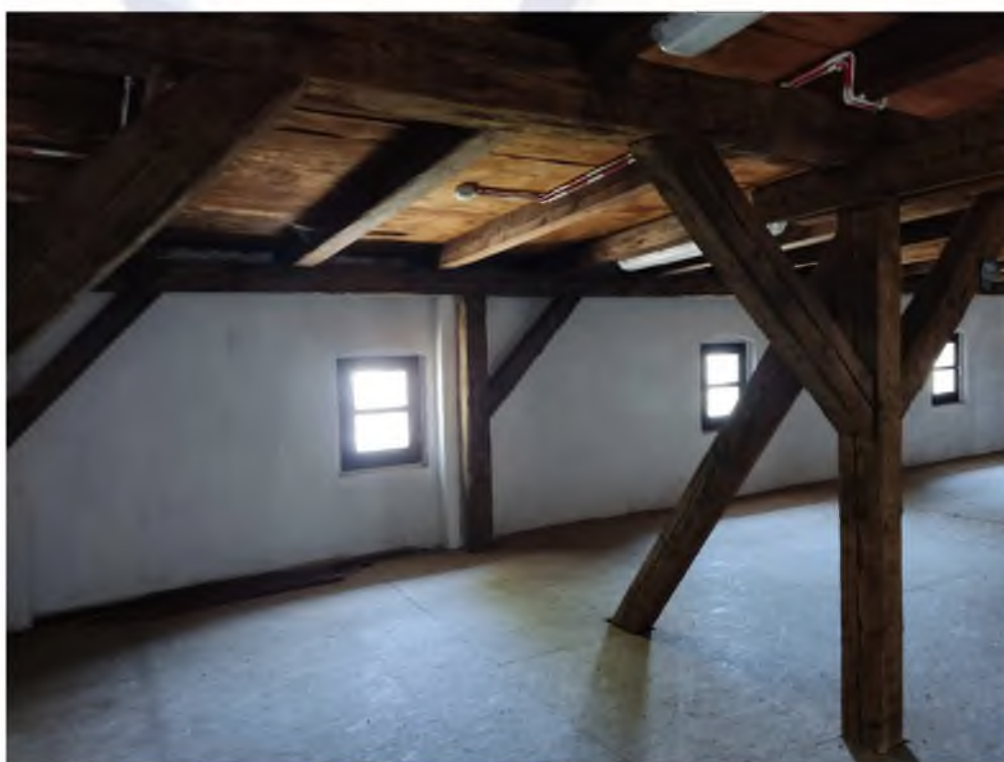
Fot. nr. 15 Układ więźby dachowej
