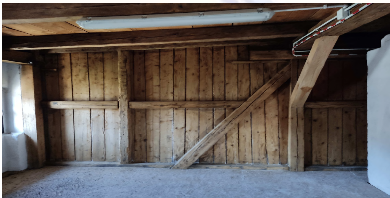
Fot. nr. 5 Ściana drewniana na poddaszu
