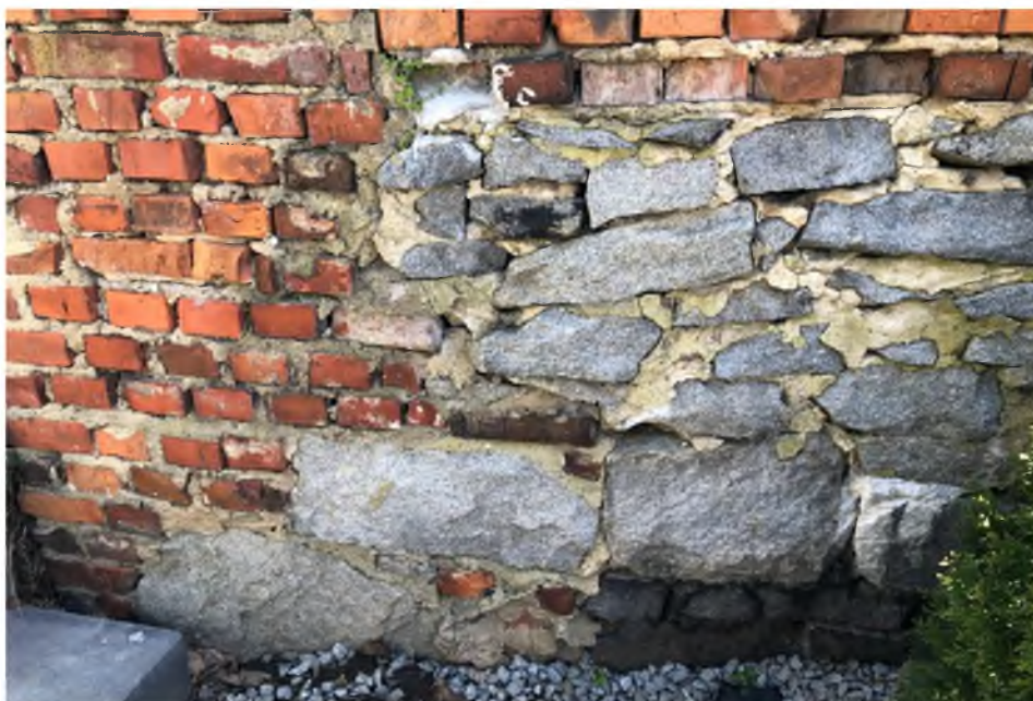
Fot. nr 8 – Budynek Prokuratury Rejonowej w Strzelinie — mur ogrodzeniowy. Widoczne naprawy mocną zaprawą cementową. Zdjęcie wykonała M. Podgórska-Makal
