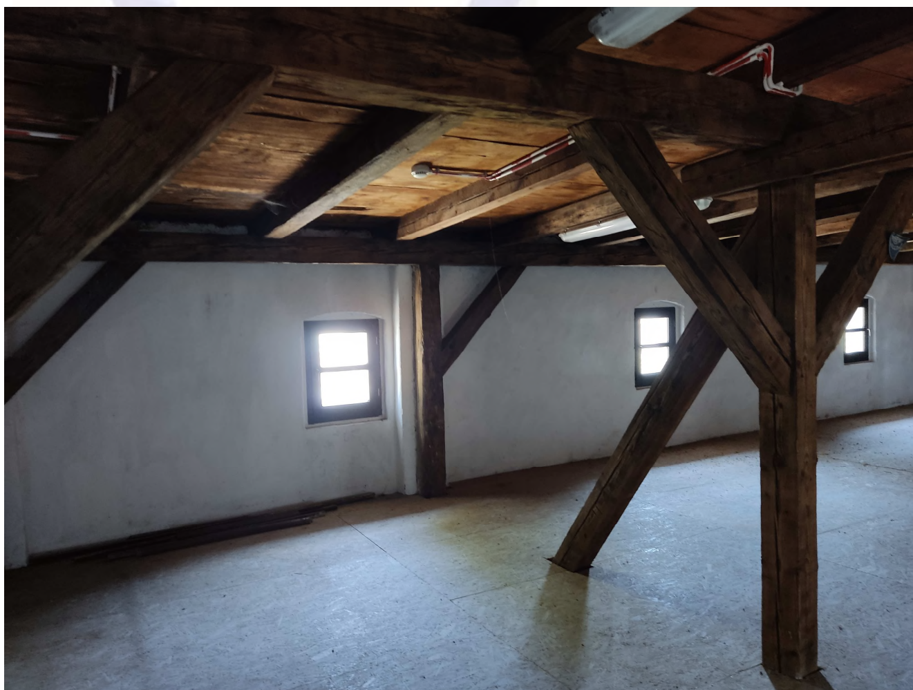
Fot. nr. 15 Układ więźby dachowej
