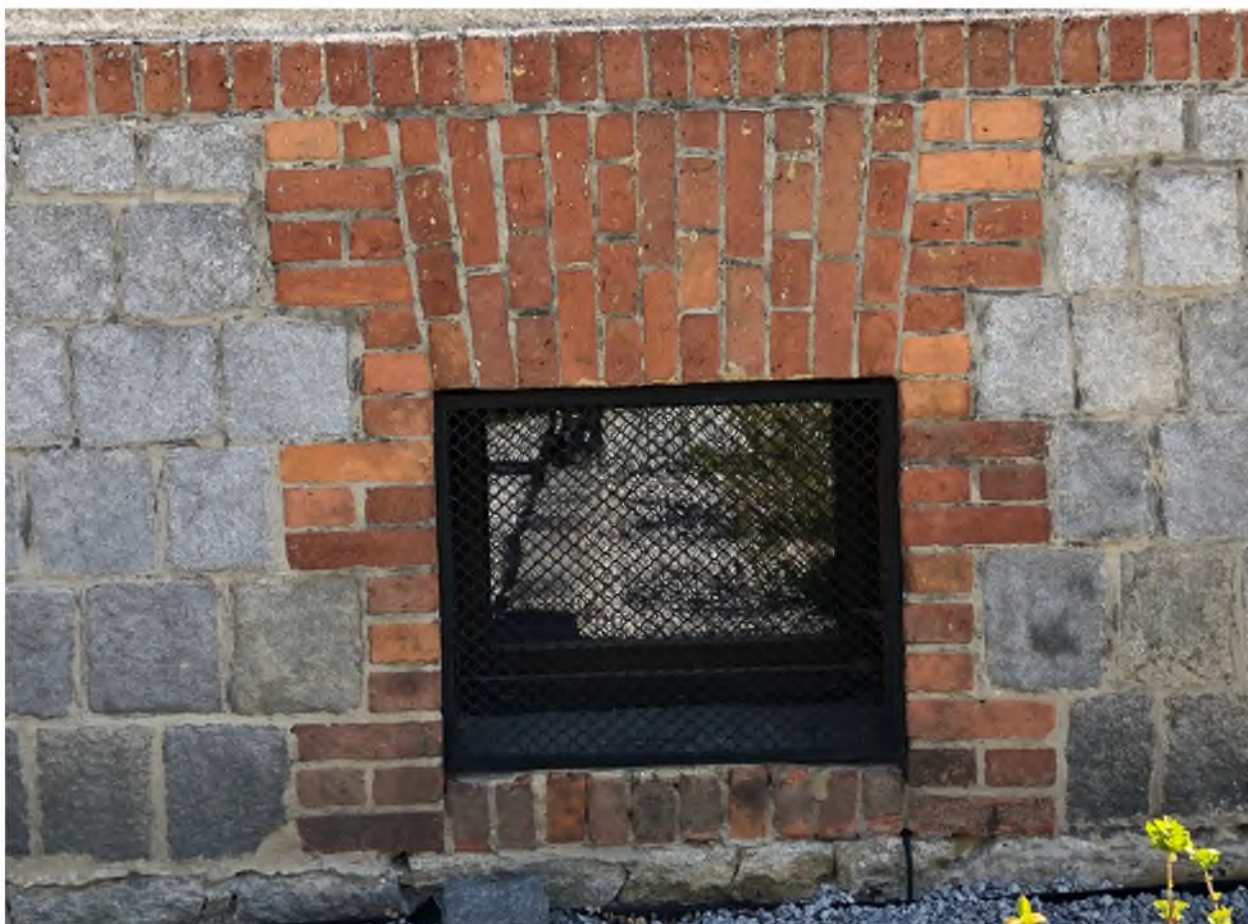
Fot. nr 7 – Budynek Prokuratury Rejonowej w Strzelinie — partia cokołowa. Widoczne zniszczone oryginalne fugi. Stan obecny. Zdjęcie wykonała M. Podgórska-Makal
