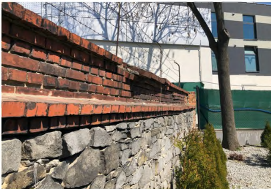
Fot. nr 11 – Budynek Prokuratury Rejonowej w Strzelinie. - mur ogrodzeniowy. Zniszczenia ceglanej korony muru. Zdjęcie wykonała M. Podgórska-Makal
