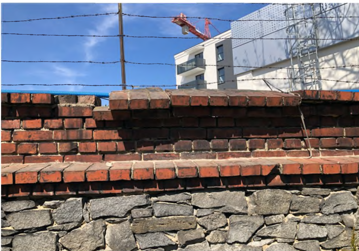
Fot. nr 10 – Budynek Prokuratury Rejonowej w Strzelinie - mur ogrodzeniowy. Zniszczenia ceglanej korony muru. Zdjęcie wykonała M. Podgórska-Makal
