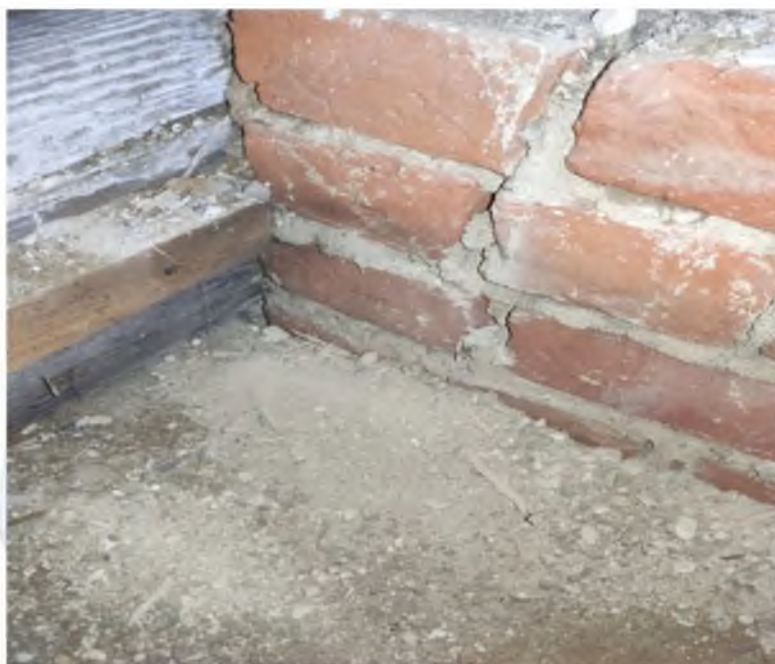
Fot.nr. 4 Ściana konstrukcyjna z cegły pełnej
