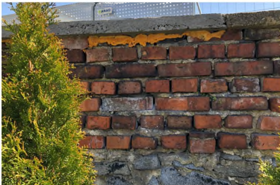
Fot. nr 4– Budynek Prokuratury Rejonowej w Strzelinie – mur ogrodzeniowy. Widoczne zniszczenie korony muru. Stan obecny. Zdjęcie wykonana M. Podgórska-Makal
