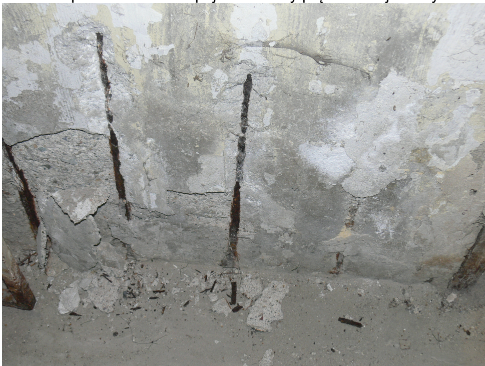
Fot. 4. Sciana żelbetowa – widoczne odspojenia otuliny prętów zbrojeniowych oraz korozja stali zbrojeniowej.
