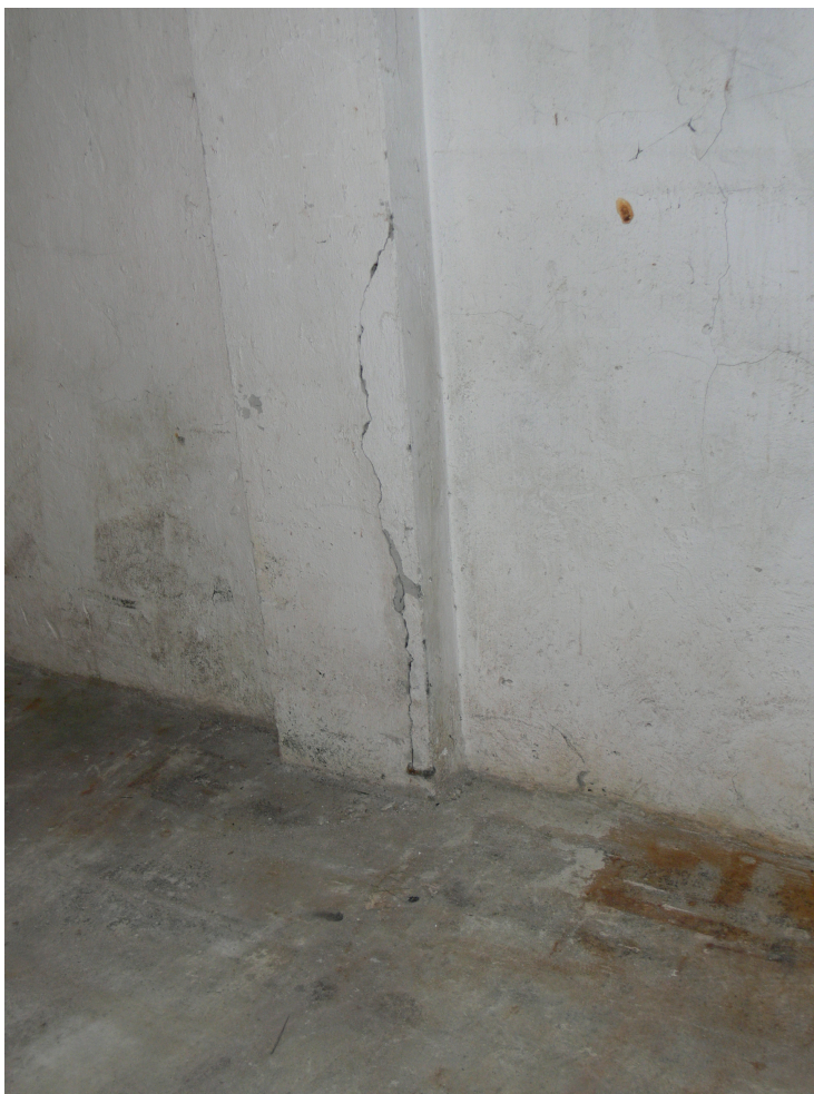
Fot 3. Słup – widoczne odspojenie otuliny prętów zbrojeniowych.
