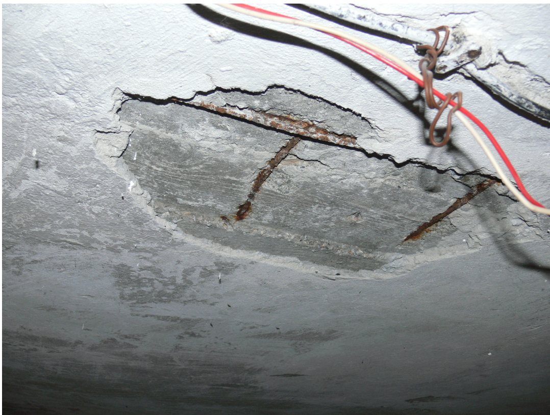
Fot. 1 Strop żelbetowy – widoczna korozja stali zbrojeniowej oraz pęknięcie stropu.
