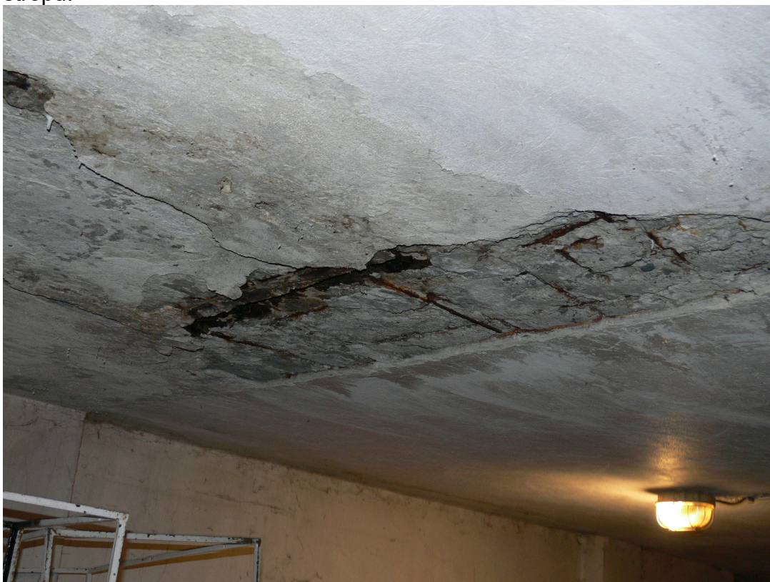
Fot 2. Strop żelbetowy – widoczne ubytki betonu i korozja stali zbrojeniowej
