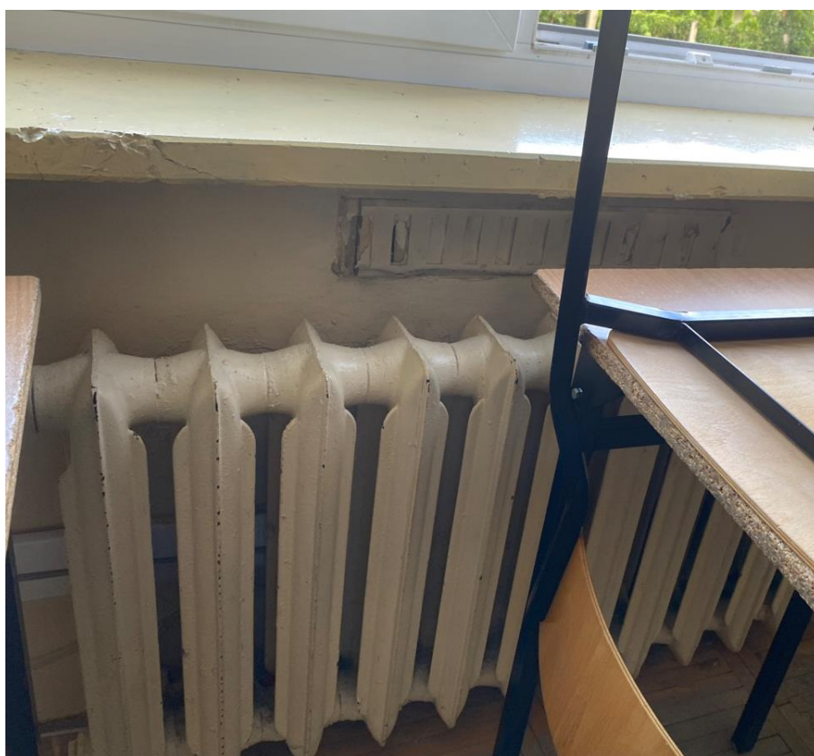
Fot. nr 6. Parapety, nawiewniki podokienne i grzejniki podlegające wymianie.
