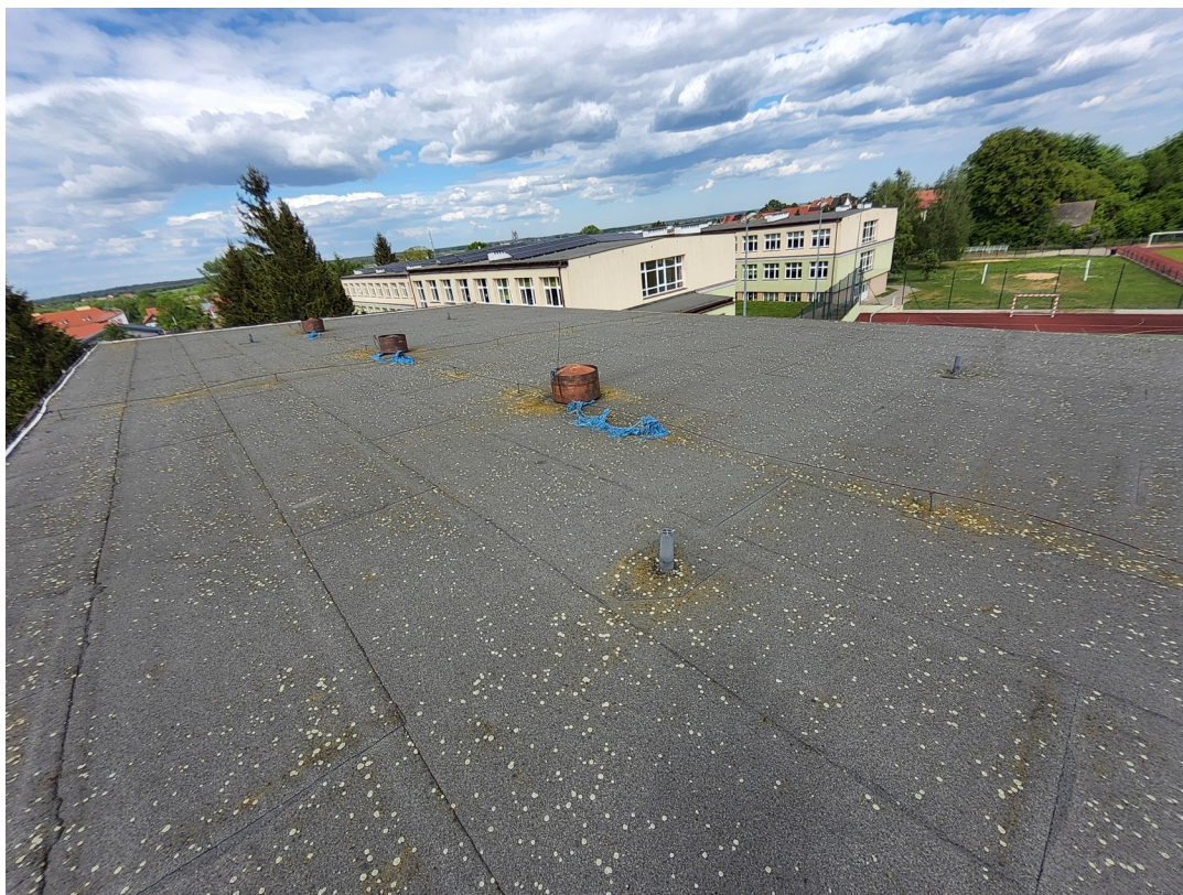
Foto 7. Widok na wentylator dachowy „bębnowy” oraz fragment instalacji odgromowej
