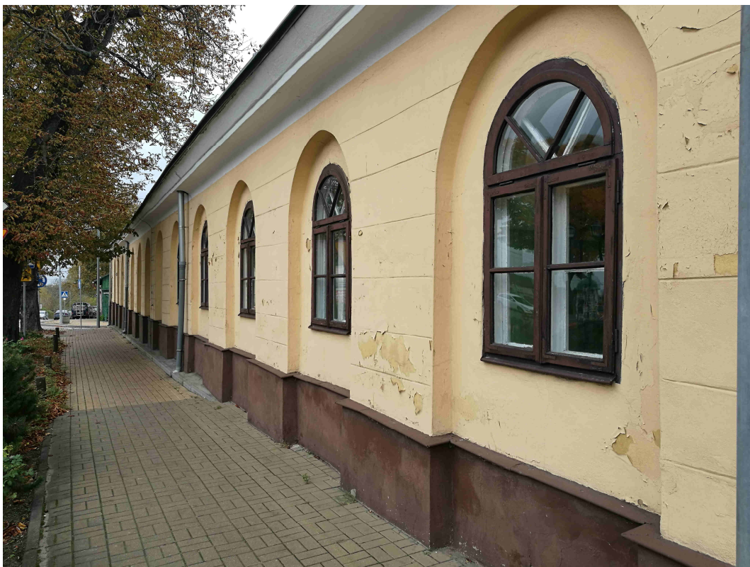
Fot. nr 3 XIX wieczny budynek PSP nr 3 im. ks. Piotra Skargi w Grójcu. Widok stanu istniejącego stolarki okiennej i drzwiowej skrzydło zachodnie , elewacja zachodnia.
