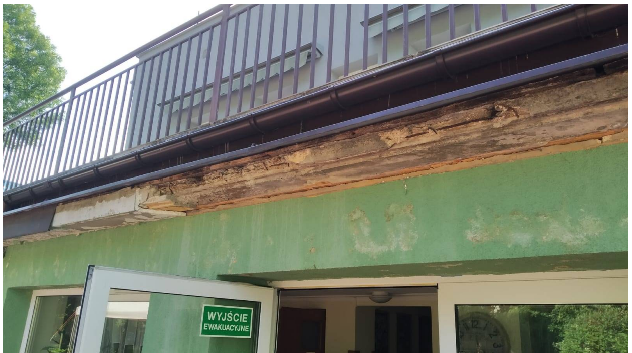
Zdjęcie 5. Uszkodzony gzyms.
