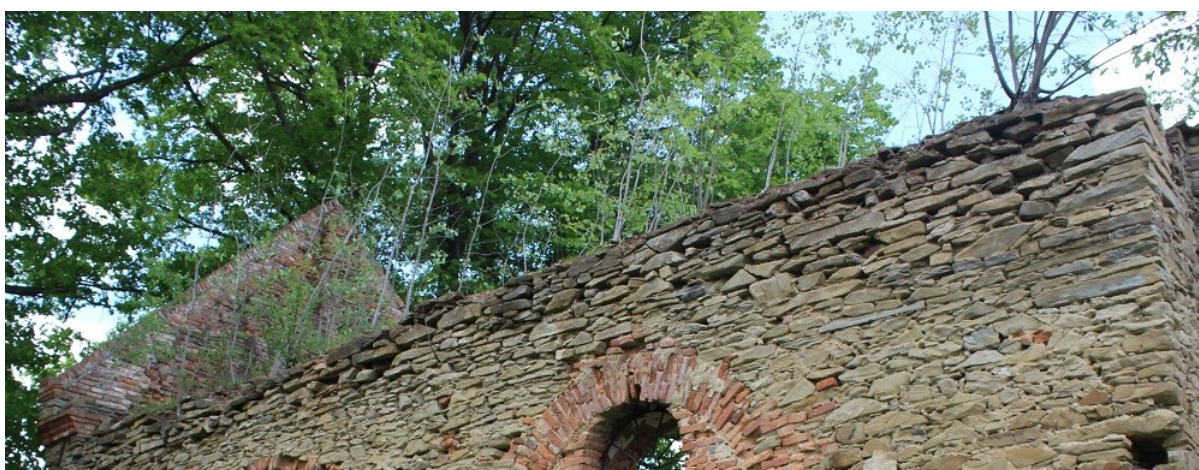
Widok górnej część muru południowego ze zniszczonymi spoinami oraz roślinnością
