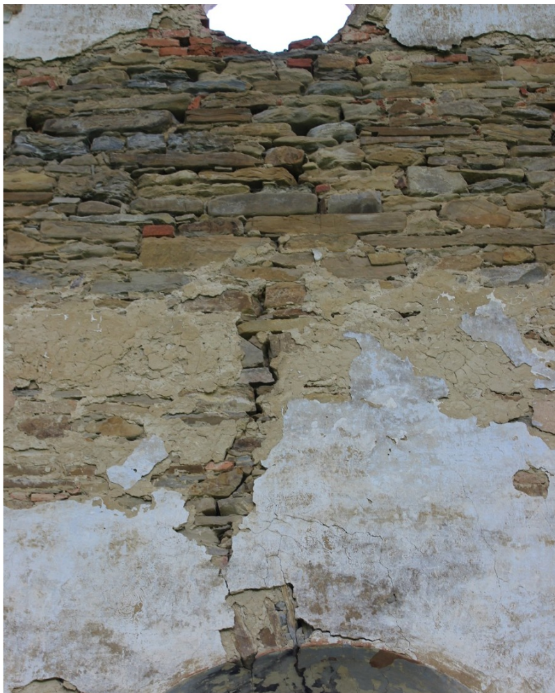
Pęknięcie ściany nad wejściem od strony zachodniej
