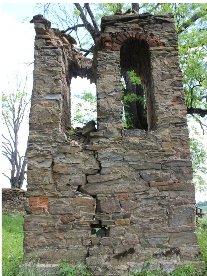
Popękana i uszkodzona dzwonnica parawanowa
