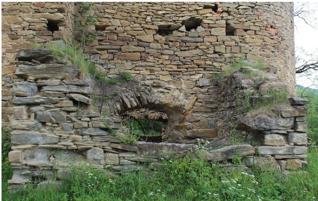
Widok zakrystii od strony południowej: zniszczony mur z wylomem i ubytkami w ścianie, na koronie muru liczne porosty traw.
