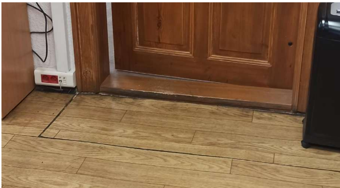
Fot. 8. I piętro. Zużyta okładzina w pomieszczeniu sekretariatu, próg przy wejściu do pomieszczenia biurowego wójta.
