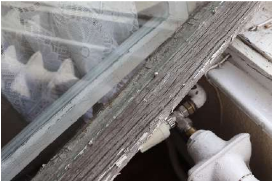
Fot. 18. Okno od strony południowej w pom. 1.3 - widoczne zniszczenia
