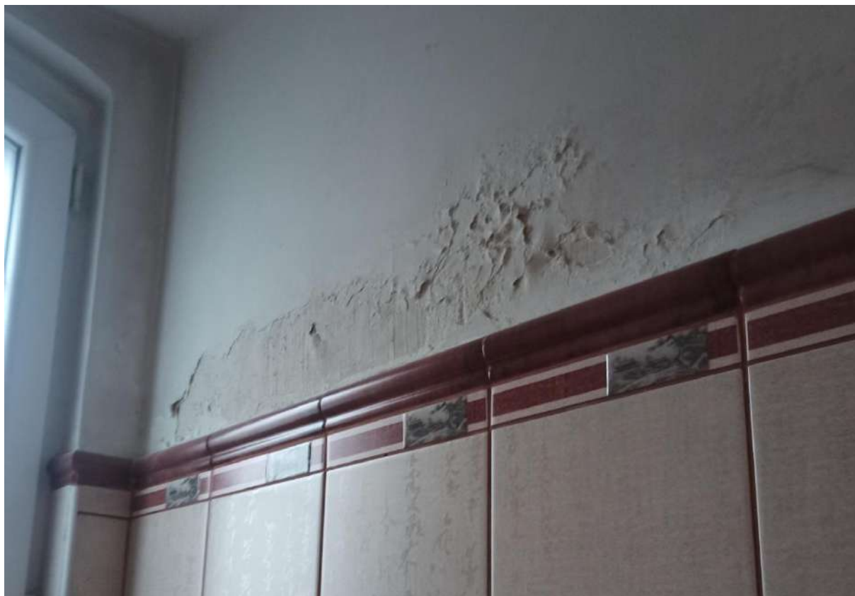
Fot. 10. Widoczne ślady złuszczeń w pomieszczeniu wc na parterze.
