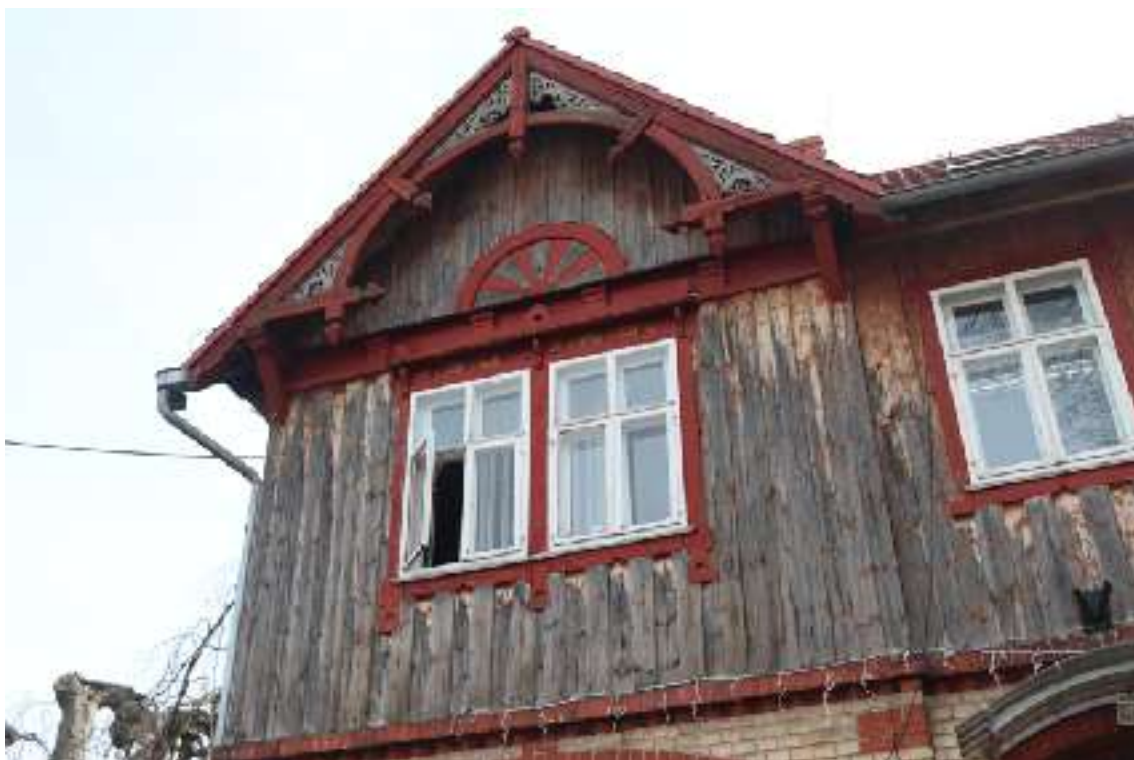
Fot. 5. Widok na elewację frontową budynku Urzędu Gminy w Bytnicy - deskowanie drugiej kondygnacji
