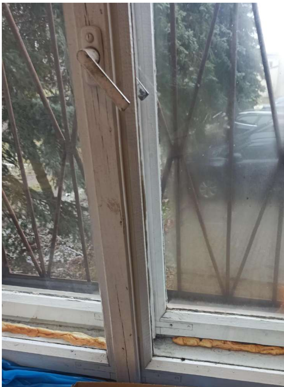
Fot. 15. Okno na parterze strona południowa. Widoczne pęknięcia podłużne ramy.
