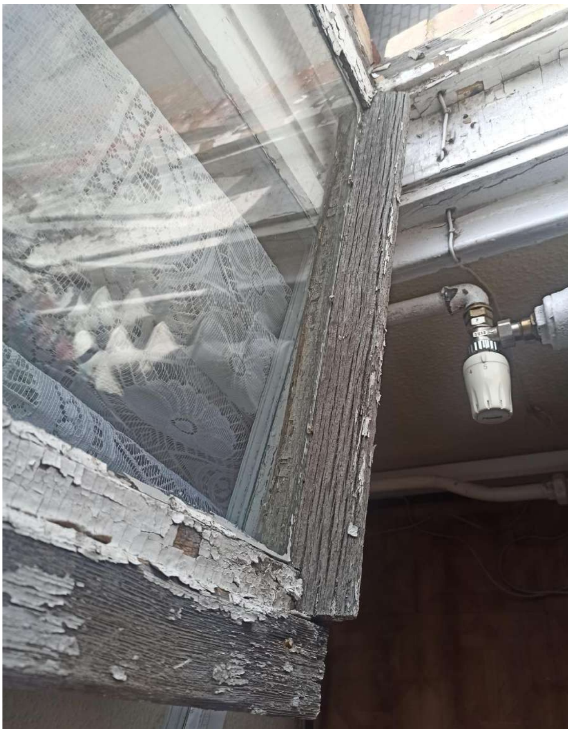
Fot. 20. Okno na parterze, strona południowa. Widoczne pozostałości farby, rozwarstwione, zniszczone drewno. Brak kitowania szyby.
