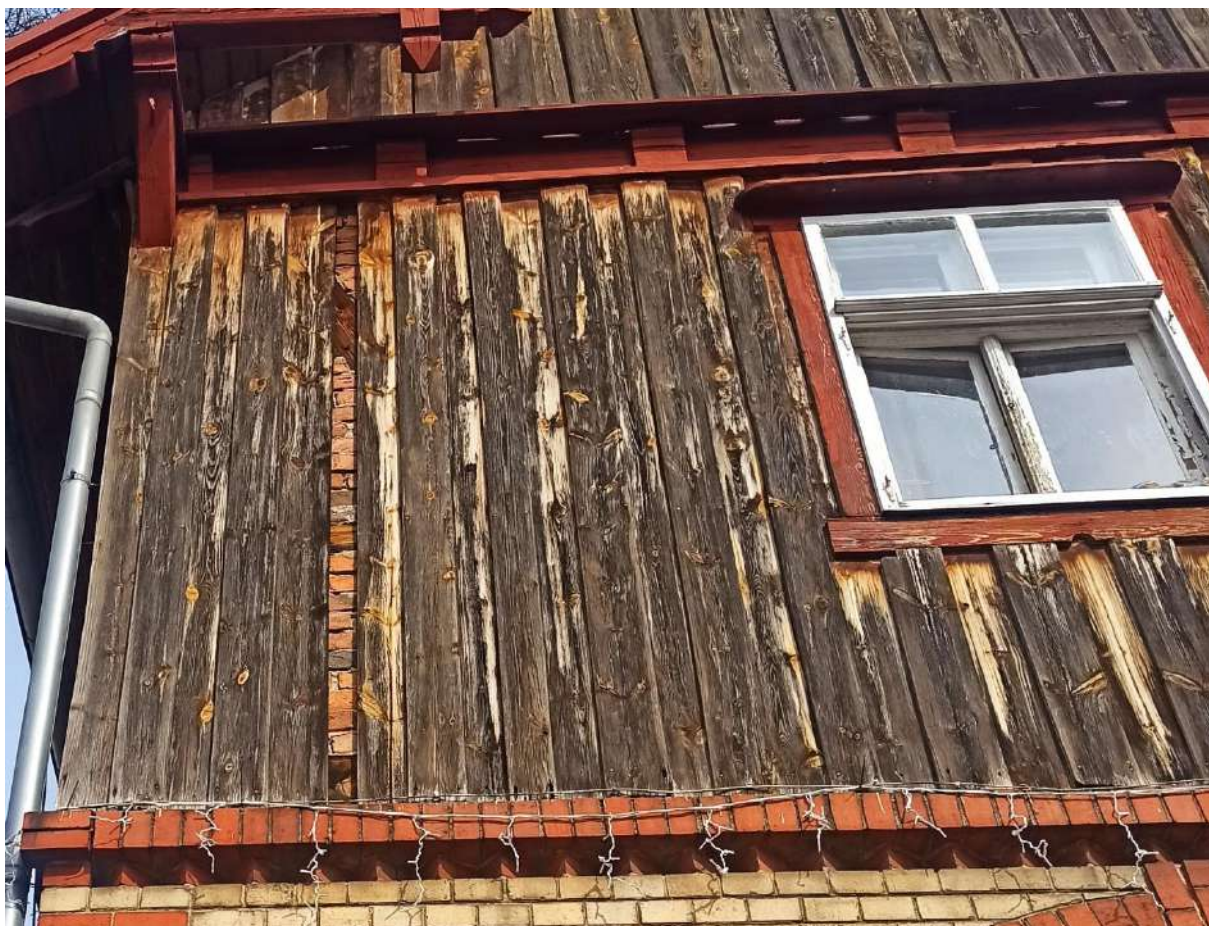
Fot. 5. Elewacja południowa. Widoczny brak deskowania.
