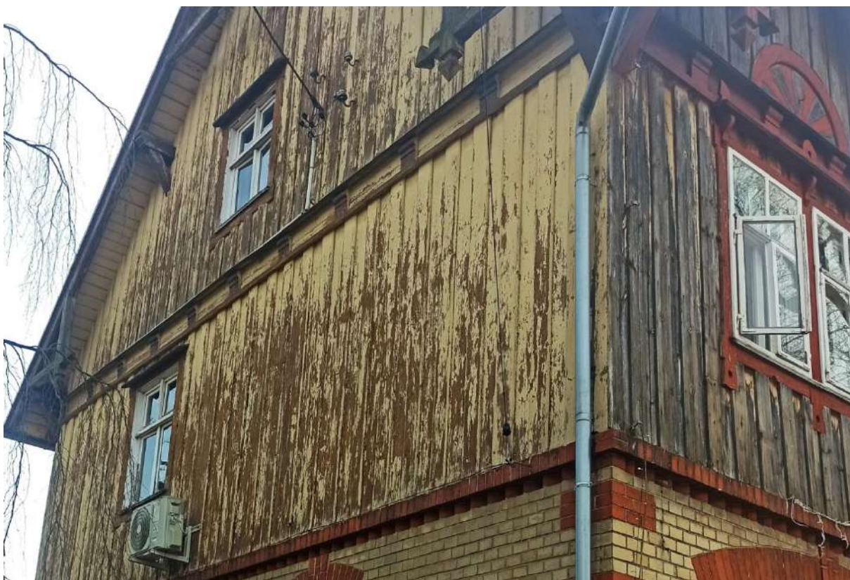
Fot. 6. Elewacja północna i zachodnia. Stan zachowania okładziny z desek.
