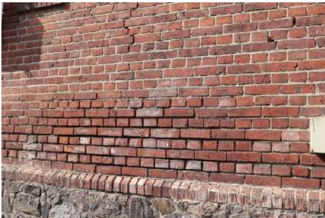
Fot. 8. Widok na elewację wschodnią budynku Urzędu Gminy w Bytnicy - widoczne braki spoin
