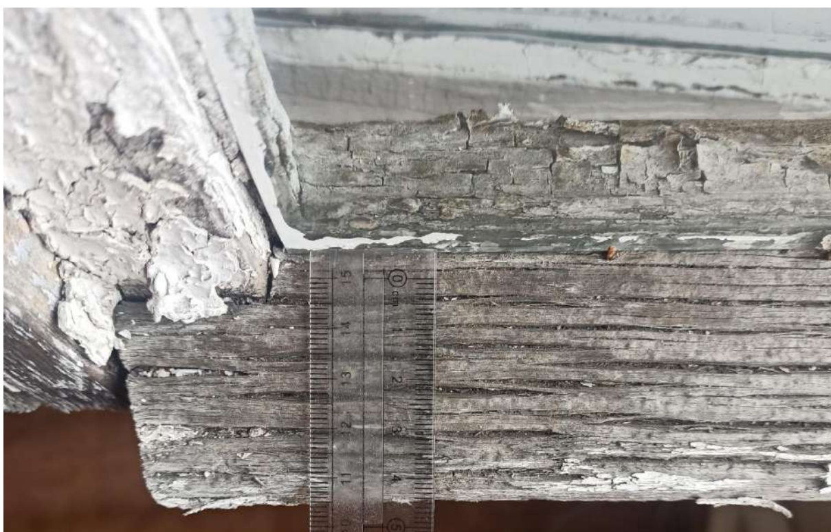
Fot. 19. Okno na parterze, strona południowa. Widoczny brak farby, rozwarstwione, zniszczone drewno.
