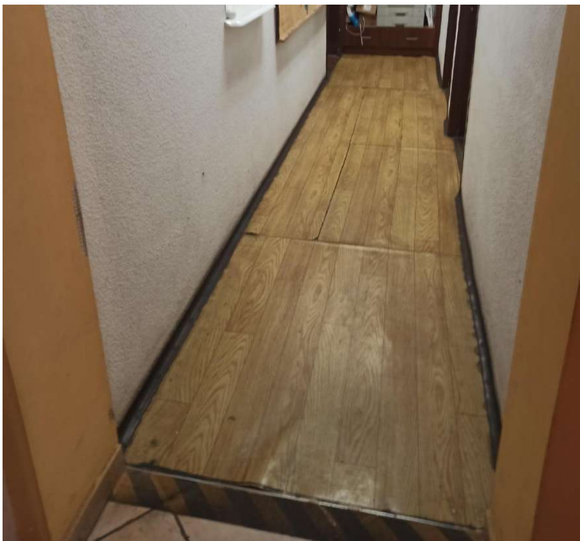
Fot. 9. Zużyta wykładzina w pomieszczeniu korytarza na parterze, stopień słabo oznakowany.
