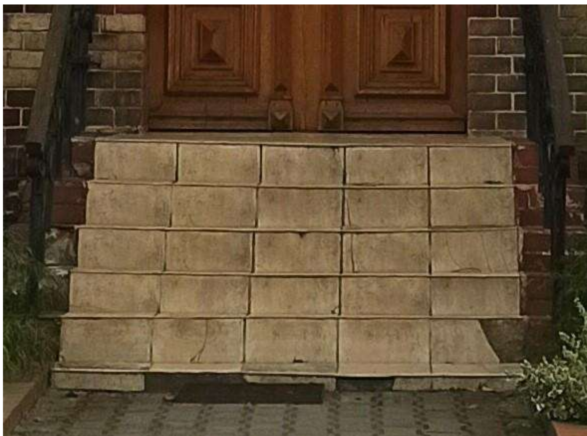
Fot. 22. Schody zewnętrzne główne. Widoczne ubytki okładziny.
