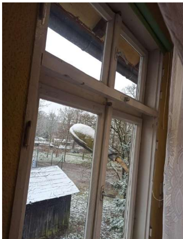
Fot. 16. Okno na piętrze strona wschodnia. Brak ram wewnętrznych okna, widoczne uszkodzenia mechaniczne.
