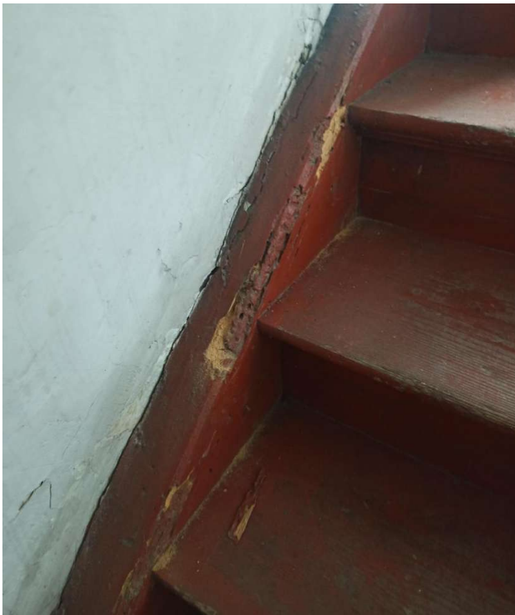
Fot. 14. Belka polickowa pomiędzy piętrem a poddaszem. Spróchniałe, odpadające części belki.
