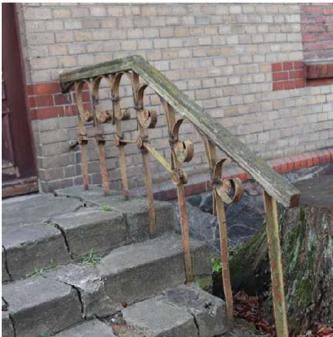
Fot. 30. Widok na barierkę schodów od strony północnej oraz na zdegradowane schody
