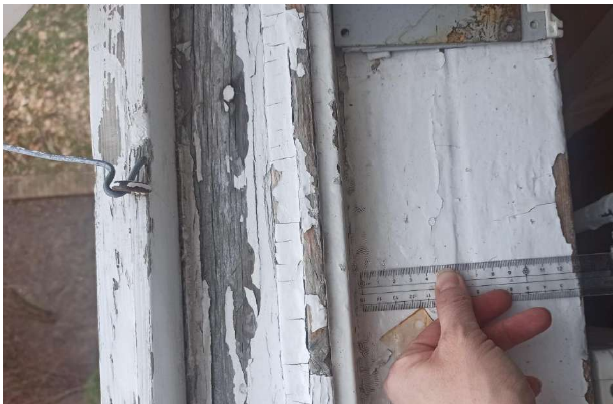
Fot. 18. Okno na piętrze, strona zachodnia. Widoczna odchodząca farba, rozwarstwione, zniszczone drewno.
