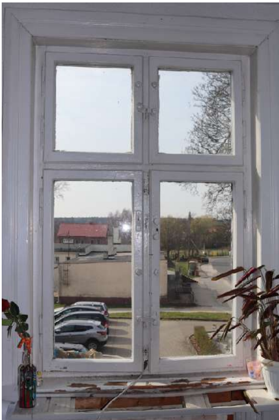
Fot. 21. Okno historyczne - zachowana tylko wewnętrzna część skrzynki, pom. 2.5 (biuro)
