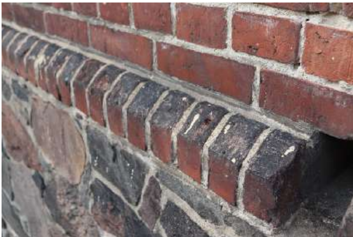
Fot. 9. Widok na elewację wschodnią budynku Urzędu Gminy w Bytnicy - widoczne zabrudzenia i uszkodzenia cegieł
