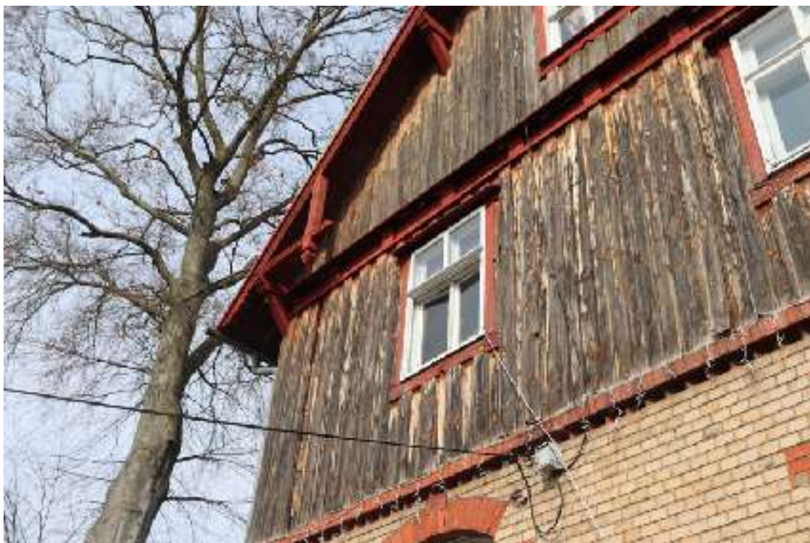
Fot. 7. Widok na elewację południową budynku Urzędu Gminy w Bytnicy - deskowanie
