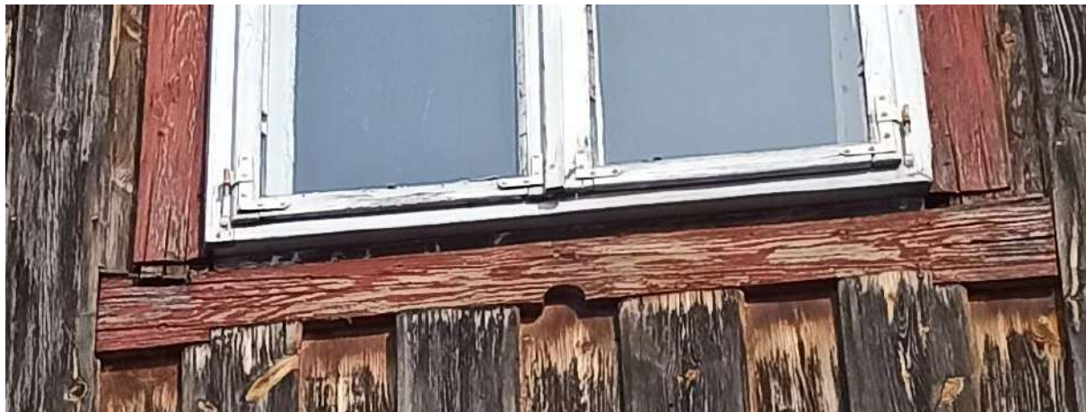
Fot. 3. Elewacja południowa – widoczne spękania wzdłużne.
