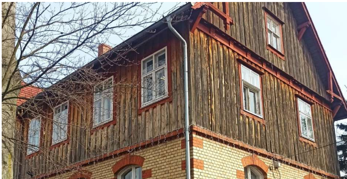
Fot. 4. Elewacja zachodnia i południowa. Stan zachowania okładziny z desek.
