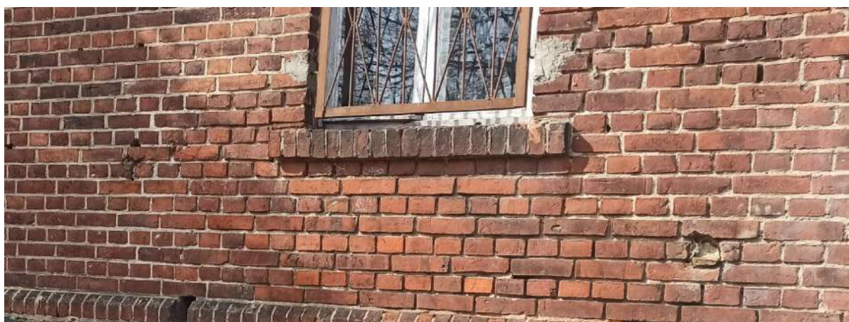
Fot. 1. Elewacja wschodnia – widoczne ubytki zaprawy, pojedyncze ubytki cegieł.
