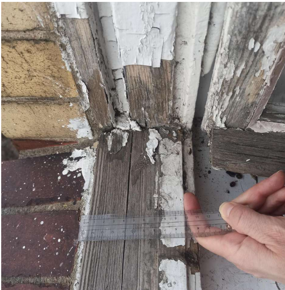
Fot. 21. Okno na parterze, strona zachodnia. Widoczne pozostałości farby, uszkodzone, rozwarstwione, zniszczone drewno.
