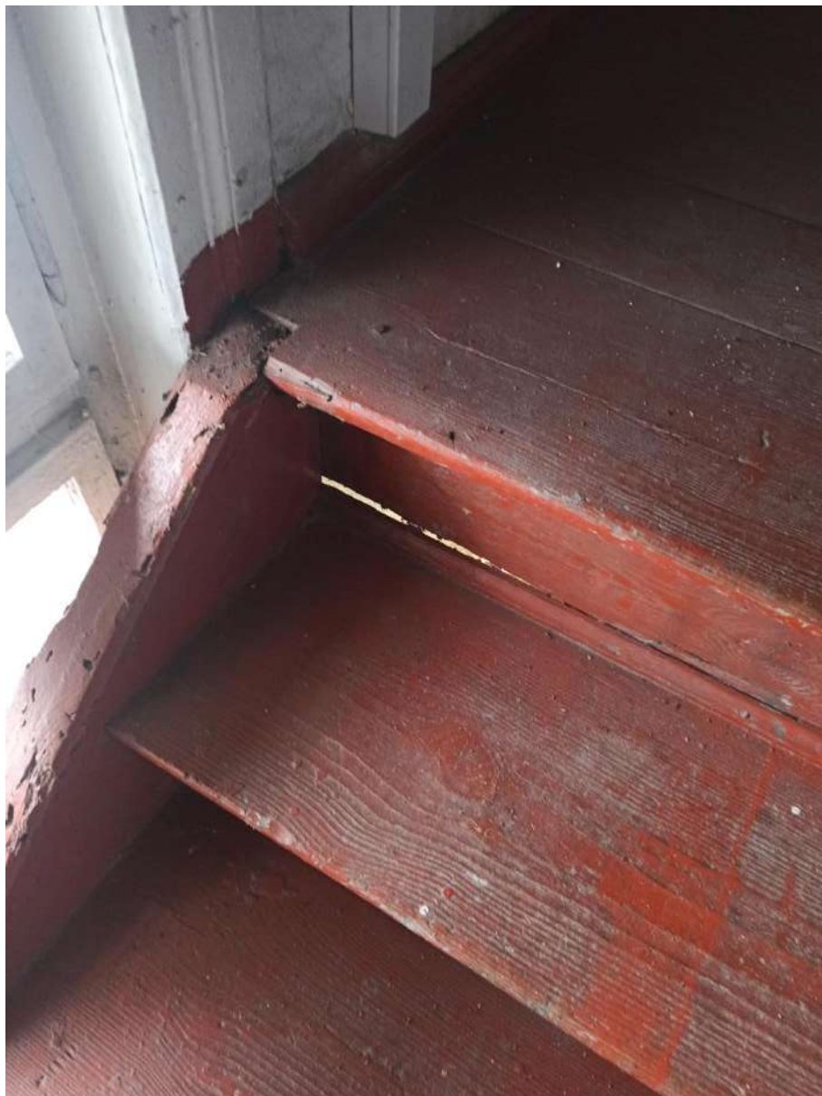
Fot. 11. Widoczna szczelina w miejscu oparcia biegu schodowego między piętrem a poddaszem, część policzkowa zainfekowana kornikiem.
