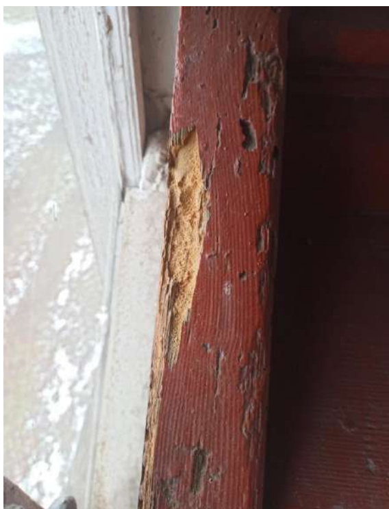
Fot. 13. Fot. 12. Schody pomiędzy piętrem a poddaszem. Spróchniała belka policzkowa.
