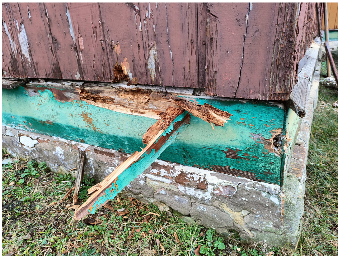
Skorodowane belki podwalinowe oraz okładziny elewacji
