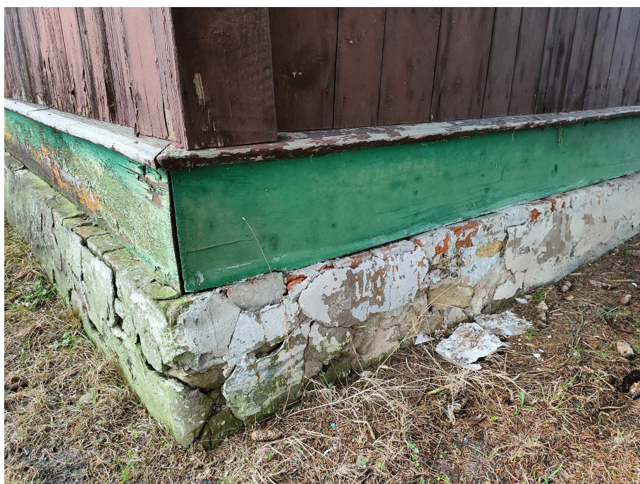
Skorodowany cokół budynku
