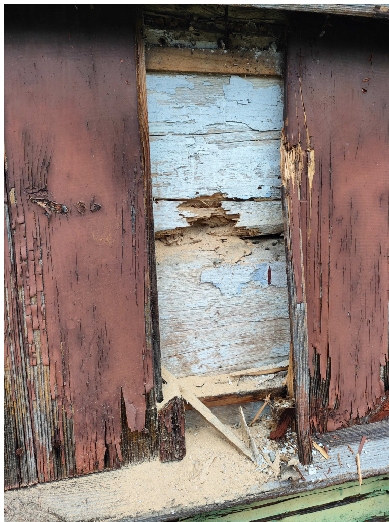
Skorodowane belki podokienne ścian oraz okładziny elewacji
