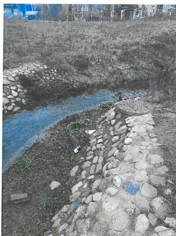
Rysunek 4: Rów otwarty łączący wylot Kanalizacji deszczowej z przepustem w nasypie kolejowym w ul. Kolejowej
