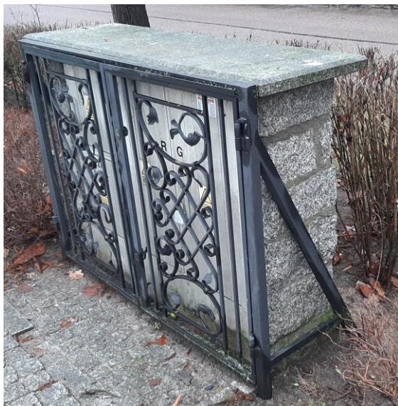
Rysunek 1 Widok istniejącego złącza kablowego i RG a) od przodu, b) od tyłu
