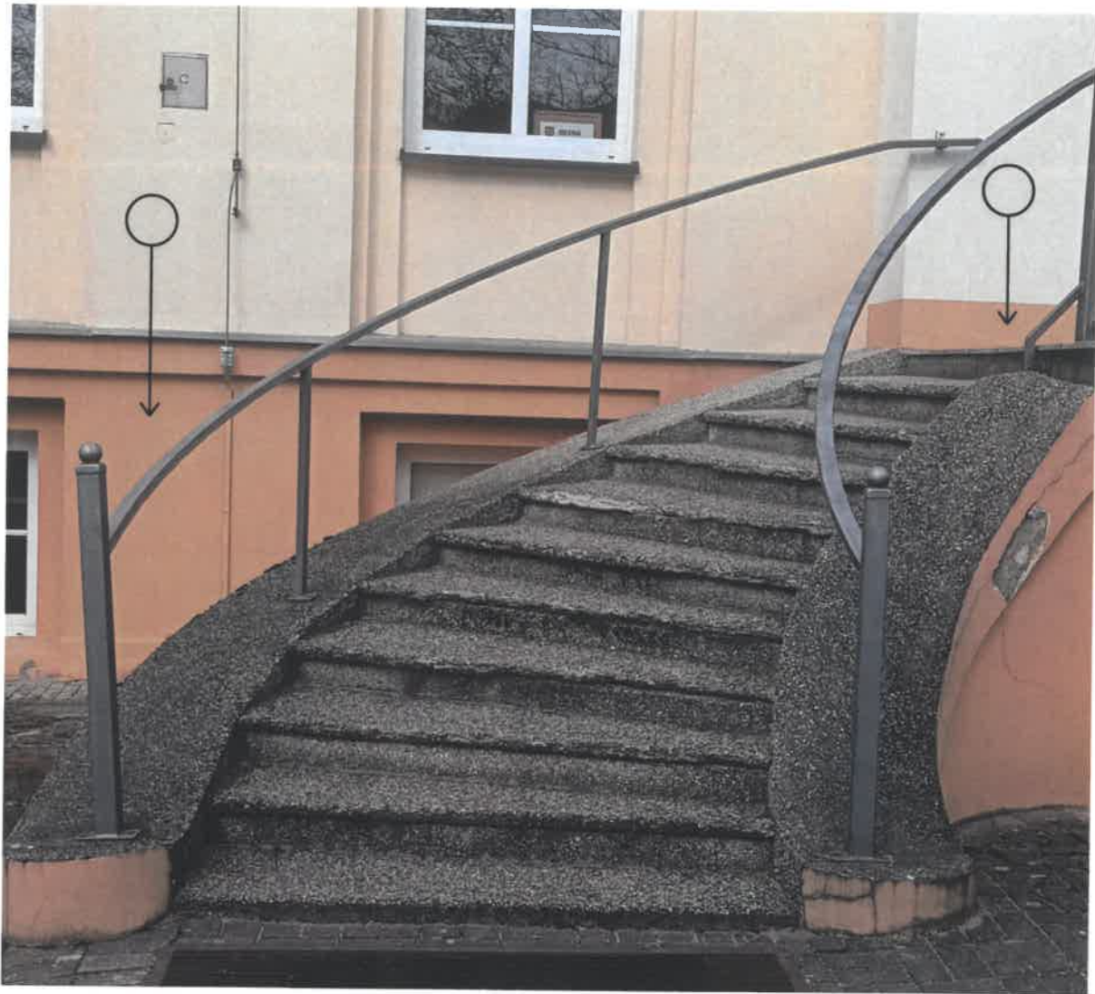
Projektuje się remont schodów zewnętrznych (głównego wejścia) polegający na zerwaniu nawierzchni i obłożeniu schodów jasnoszarymi płytami granitowymi.
