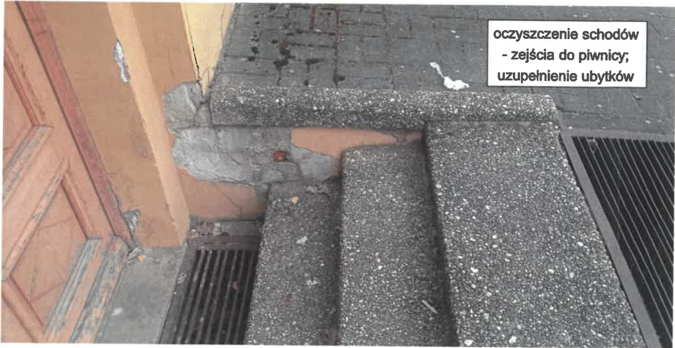
Projektuje się remont schodów zewnętrznych (głównego wejścia) polegający na zerwaniu nawierzchni i obłożeniu schodów jasnoszarymi płytami granitowymi.
