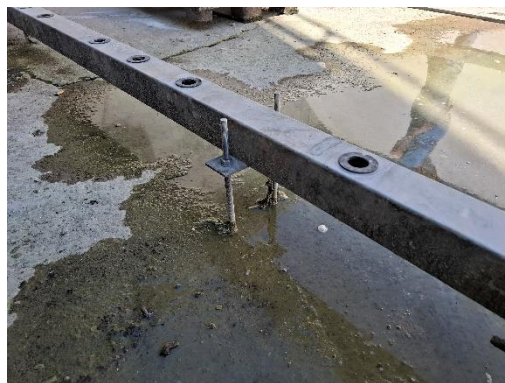
Zdjęcie nr 8 – widok rusztu napowietrzania
