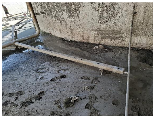
Zdjęcie nr 6 – widok rusztu napowietrzania
