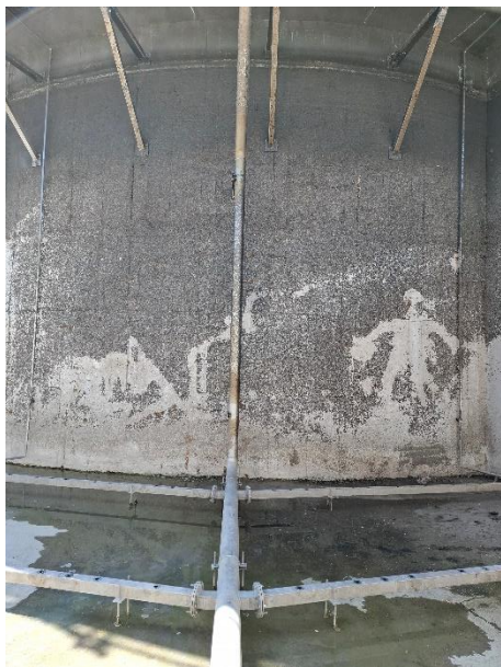
Zdjęcie nr 9 – widok rusztu napowietrzania
