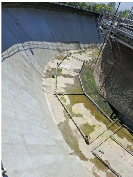
Zdjęcie nr 3 – widok rusztu napowietrzania
