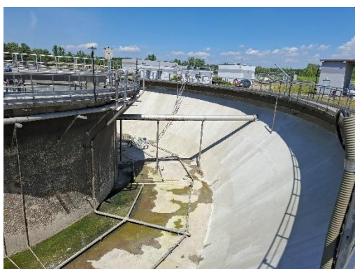
Zdjęcie nr 1 – widok rusztu napowietrzania
