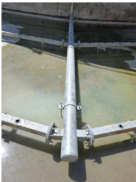
Zdjęcie nr 5 – widok rusztu napowietrzania
