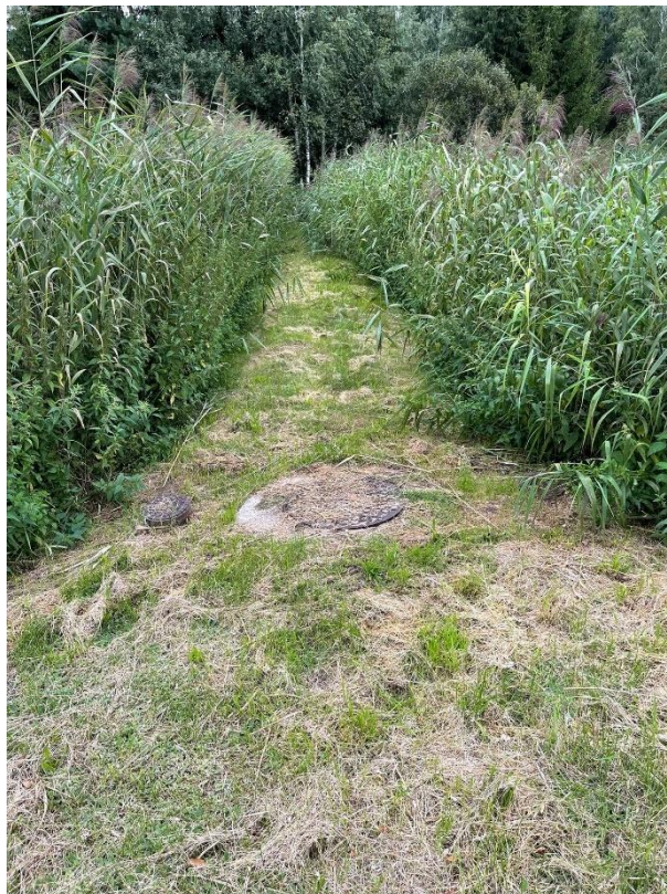
Rysunek 9. Zdjęcie studni rozdzielczej i poletek trzcinowych na oczyszczalni ścieków w Lelkowie.
