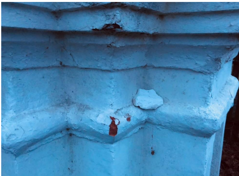
Fot. 9. Półwałek pierwszej kondygnacji, widoczne ubytki, złuszczenia warstw wtórnych, osłabienie warstwy oryginalnej powodujące dezintegrację warstw nadległych.
