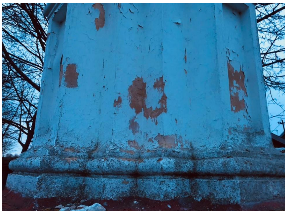
Fot. 6. Podstawa drugiej kondygnacji, widoczna korozja biologiczna w partii profilowanego cokołu i ponad daszkiem ceramicznym oraz rozległe złuszczenia wtórnych warstw powodujące degradację warstw spodnich
