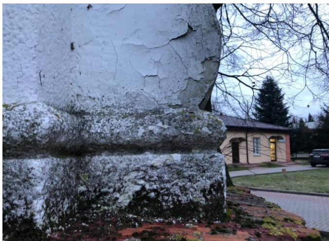
Fot. 11. Podstawa drugiej kondygnacji, ponad daszkiem, widoczna korozja biologiczna oraz spękania i odspojenia warstw wierzchnich.
