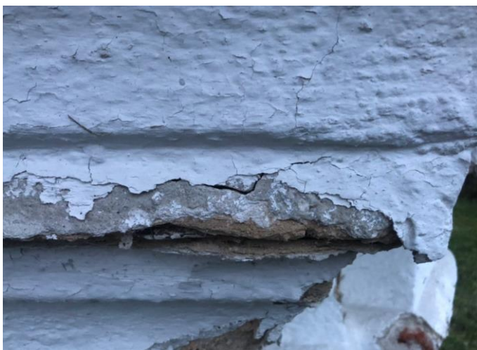
Fot. 8. Gzyms, widoczne rozwarstwienie oryginalnej zaprawy, wtórna zaprawa cementowa oraz spękania i wtórna warstwa farby.
