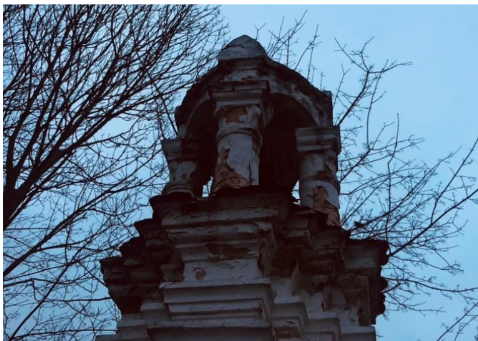
Fot. 10. Trzecia kondygnacja, arkady z rzeźbą w. Jana. Widoczne rozległe ubytki sięgające do lica muru, poważne spękania, krytyczne odpsojenia, zwłaszcza w partii kolumn oraz górnego gzymsu, rozległe złuszczenia spowodowane zastosowaniem tynku cementowego.
