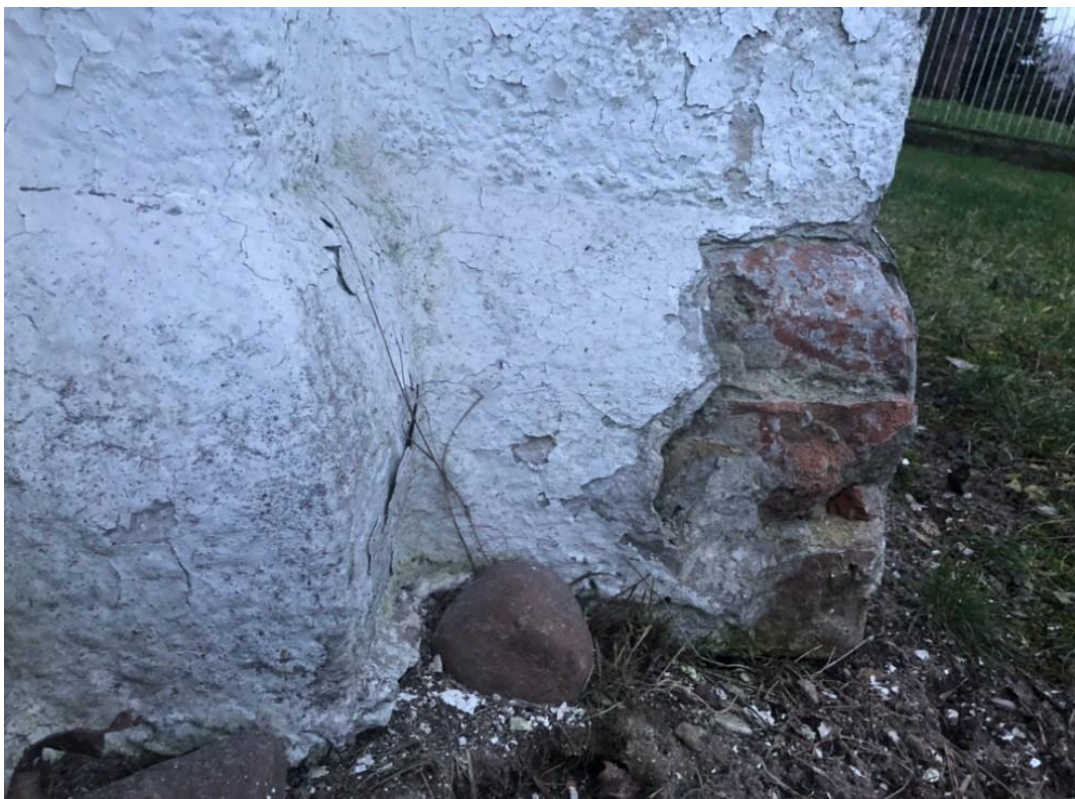
Fot. 15. Uszkodzenia partii przyziemia.
