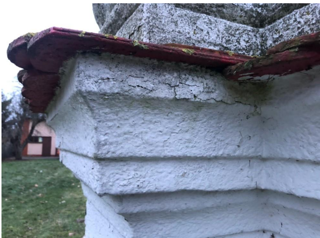
Fot. 7. Gzyms pod zadaszeniem, widoczne spękania i odspojenia warstw wtórnych.
