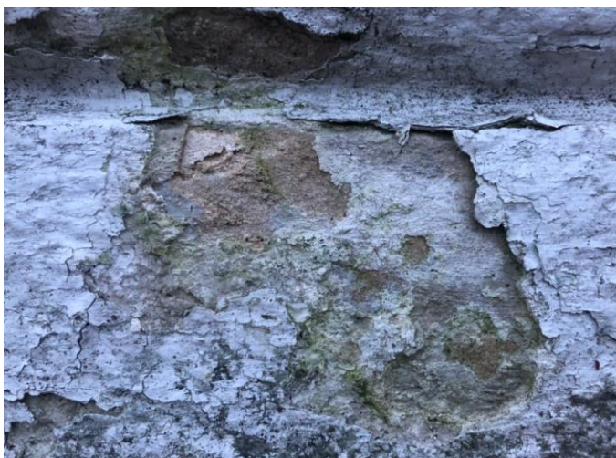
Fot. 12. Stan zachowania warstwy wierzchniej na ścianie kapliczki- widoczne rozległe odspojenia, złuszczenia i korozja biologiczna.
