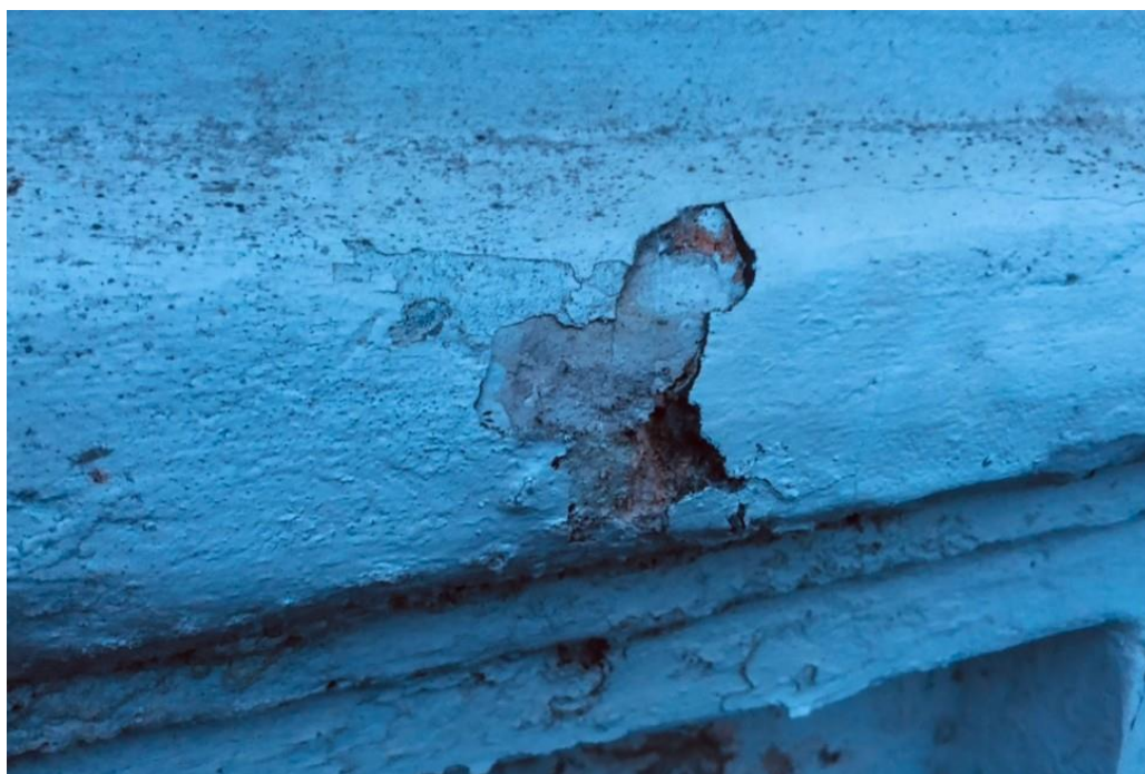
Fot. 15. Profil sztukatorski, widoczne spękanie i odspojenie warstwy. W ubytku widoczna oryginalna cegła z relikdami zaprawy, pokryte korozją biologiczną, spękane i wymyte.
