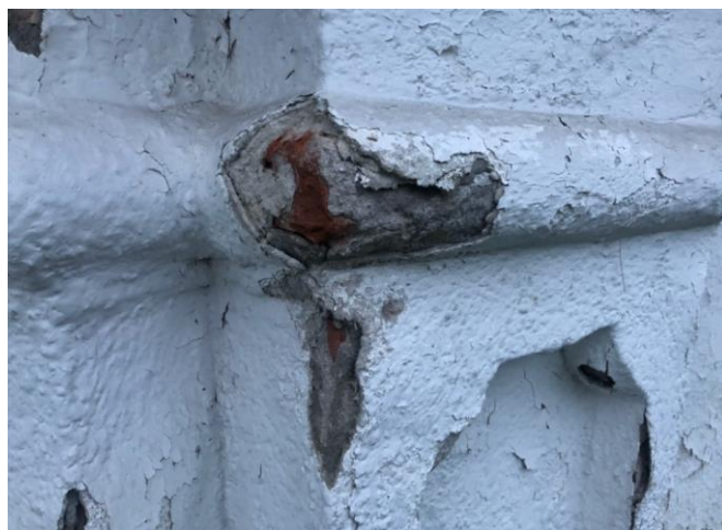
Fot. 10. Narożnik gzymsu, widoczna wtórna warstwa zaprawy cementowej pod wymalowaniem oraz rozległe odspojenia i spękania wierzchniej warstwy.
