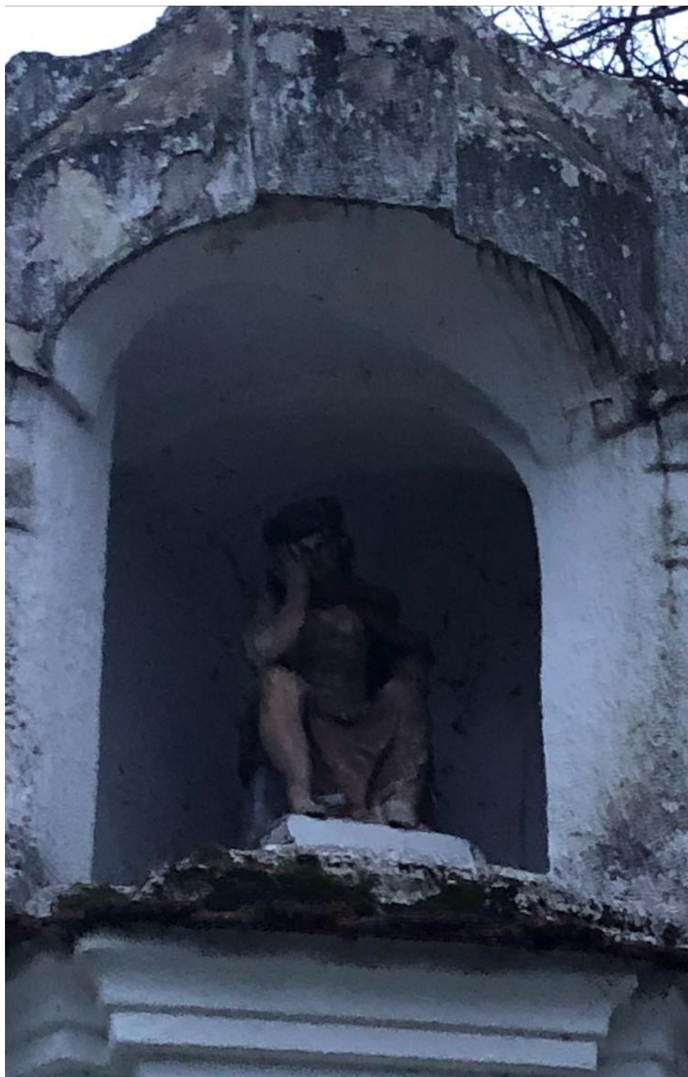
Fot. 3. Nisza z figurą Chrystusa Frasobliwego. Widoczne zabrudzenia powierzchniowe i drobne uszkodzenia figury. Powyżej i poniżej niszy widoczna degradacja wtórnych zapraw oraz dachówki.
