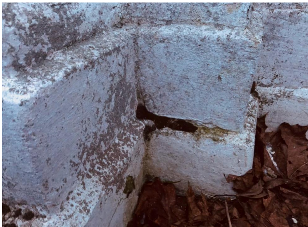
Fot. 7. Podstawa pierwszej kondygnacji, widoczne mchy, glony i porosty oraz wtórne nawarstwienia tynku na powierzchni profili sztukatorskich.
