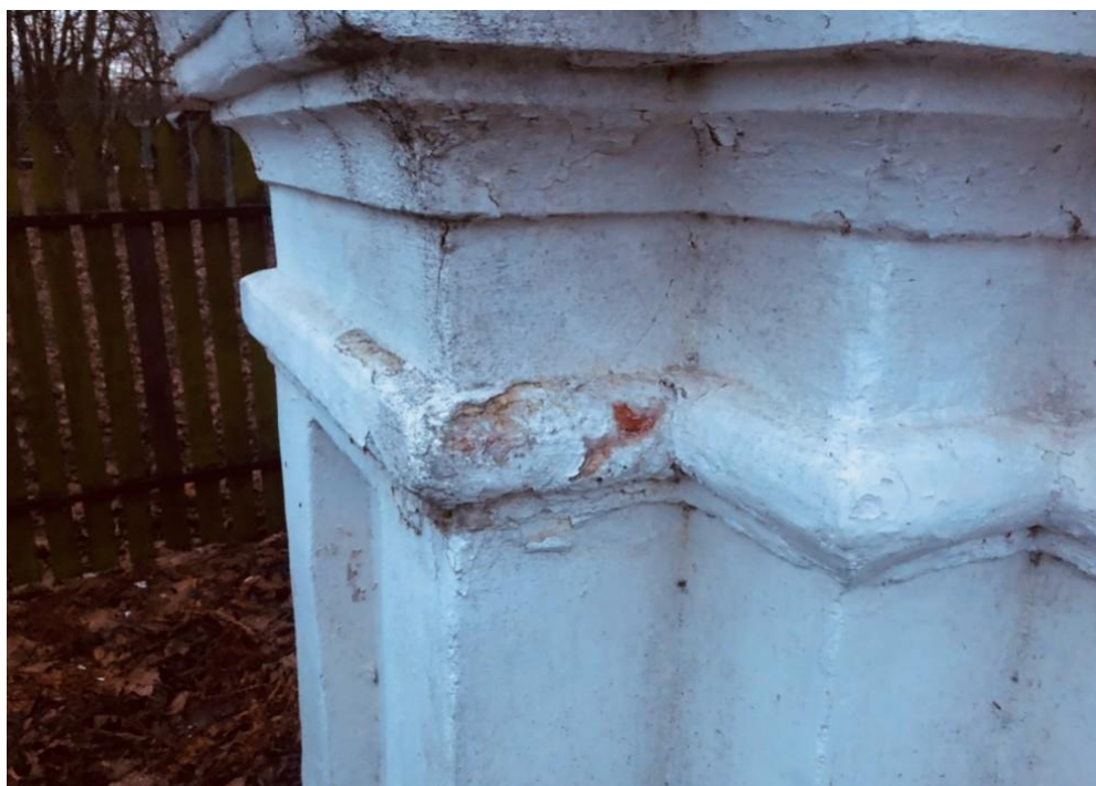
Fot. 8. Półwałek kondygnacji pierwszej, widoczne ubytki wynikające z zastosowania tynku cementowego- w ubytku widoczna rozłożona zaprawa oryginalna oraz łuszcząca się cegła.
