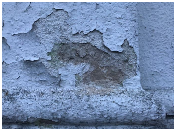
Fot. 13. Stan zachowania powierzchni pilastra- widoczne złuszczenia, rozwarstwienia i korozja biologiczna powierzchni.
