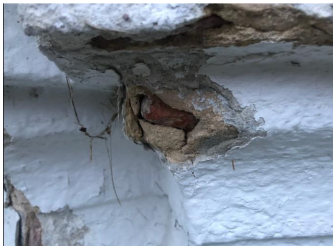
Fot. 9. Gzyms, ubytek, w którym widoczna jest oryginalna zaprawa- spękana, wykruszająca się, rozwarstwiona, o osłabionej adhezji do podłoża.
