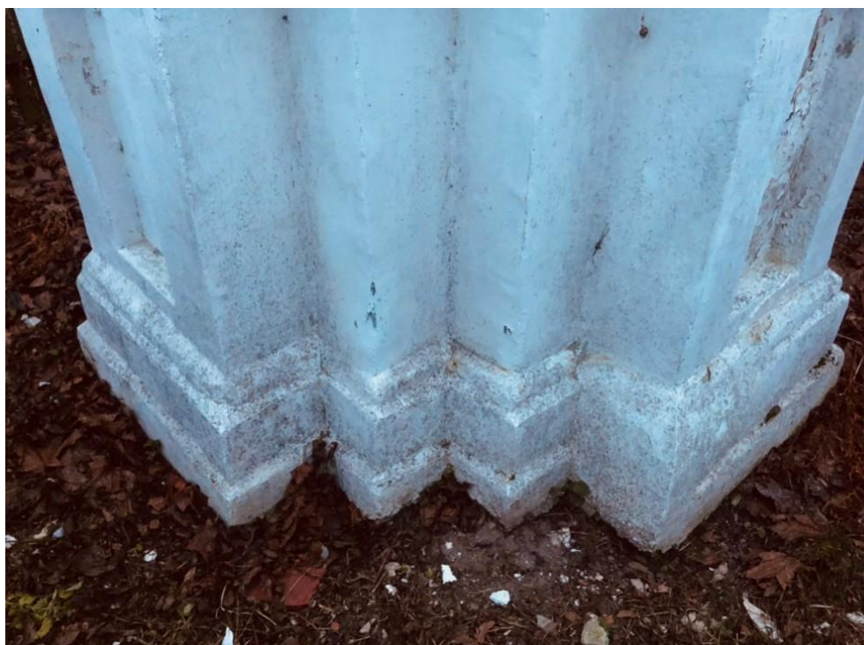
Fot. 5. Część dolna, widoczne nawarstwienia korozji biologicznej- mchów, glonów i porostów oraz odspojenia i deformacje powierzchni tynku.
