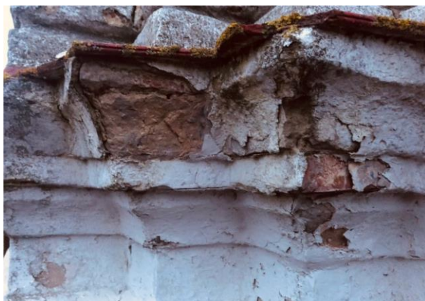
Fot. 12. Gzyms, krytyczne odspojenia, degradacja oryginalnej cegły- złuszczenia i spekania. Odspajanie się warstw wtórnych powodujące destrukcję warstw podległych.
