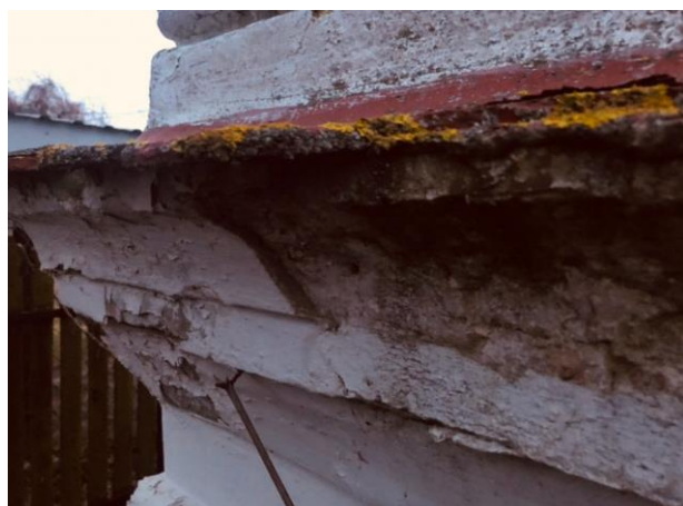
Fot. 11. Gzyms pierwszej kondygnacji, widoczne odspojenie, korozja biologiczna (porosty) i nawarstwienia zaprawy cementowej będące główną przyczyną zniszczeń obiektu.
