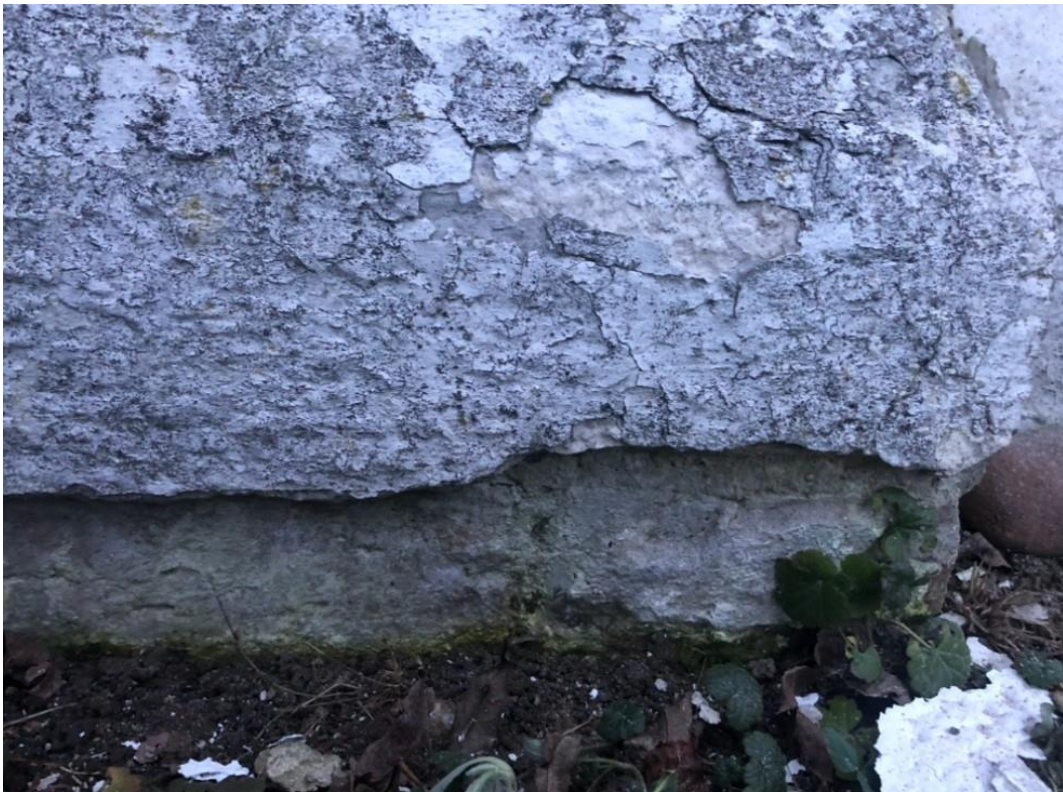
Fot. 14. Przyziemie, widoczne wtórne warstwy cementowe oraz roślinność.
