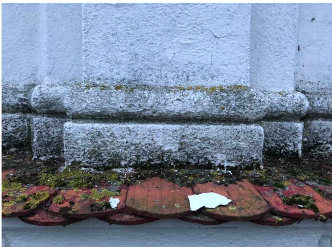
Fot. 6. Podstawa drugiej kondygnacji, styk zadaszenia gzymsu ze ścianą kapliczki, widoczne obfite nawarstwienia mchów i porostów oraz współczesna maszynowa dachówka.
