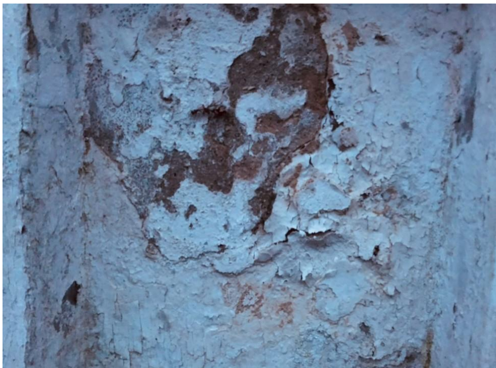
Fot. 14. Powierzchnia tynku, druga kondygnacja kapliczki, widoczne krytyczne spęcherzenia powstałe na skutek kumulowania się wilgoci, złuszczenia i wykwyty.
