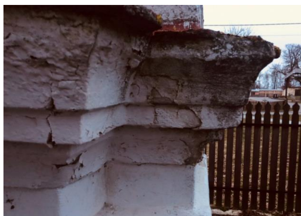
Fot. 13. Degradacja zaprawy na gzymsie, widoczne spękania, odspojenia i korozja biologiczna oraz uszkodzenia ceramicznego zadaszenia.
