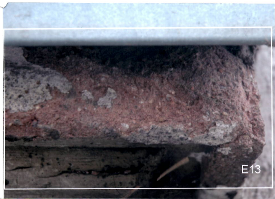
Odkrywka E13. Widoczne tynki barwione w masie na kolor ceglastoczerwony wg NCS-u S 1030-Y80R.
