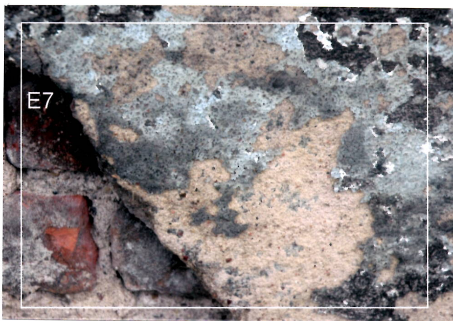
Odkrywka E7. Brak oryginalnych tynków.
