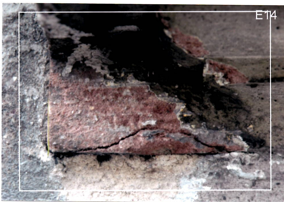
Odkrywka E14. Widoczne tynki barwione w masie na kolor ceglastoczerwony wg NCS-u S 1030-Y80R.
