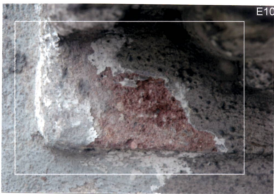
Odkrywka E10. Widoczne tynki barwione w masie na kolor ceglastoczerwony wg NCS-u S 1030-Y80R.
