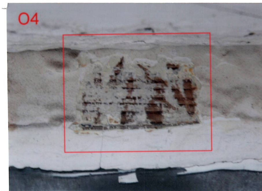
Odkrywka O4. Brak oryginalnych wymalowań.
