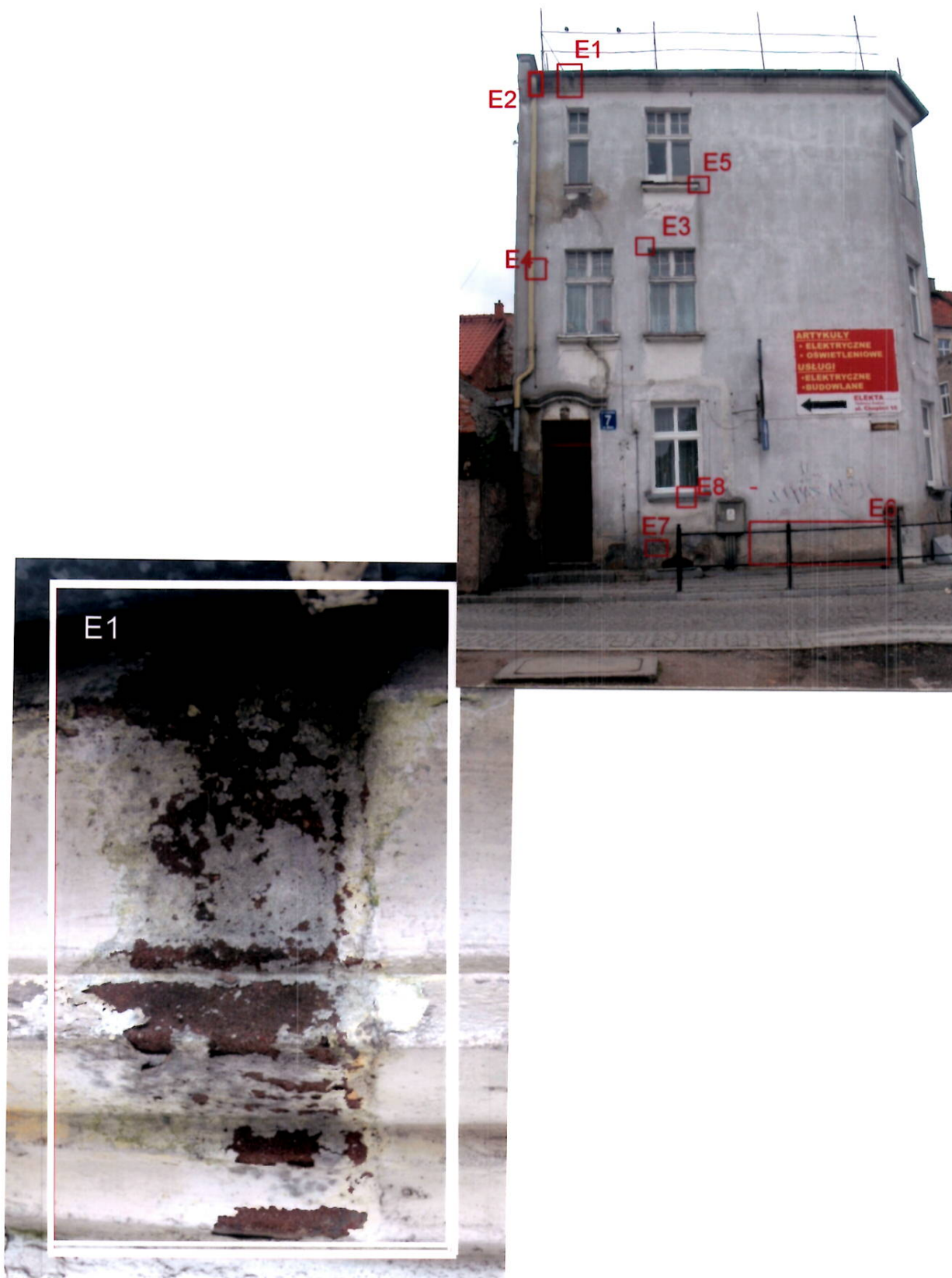
Odkrywka E1. Widoczne tynki barwione w masie na kolor ceglastoczerwony wg NCS-u S 1030-Y80R.
