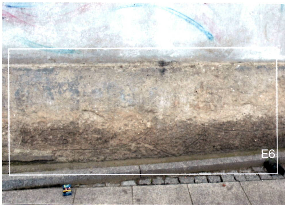
Odkrywka E6. Brak oryginalnych tynków.
