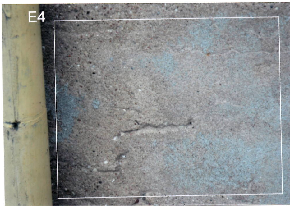
Odkrywka E4. Brak oryginalnych tynków.
