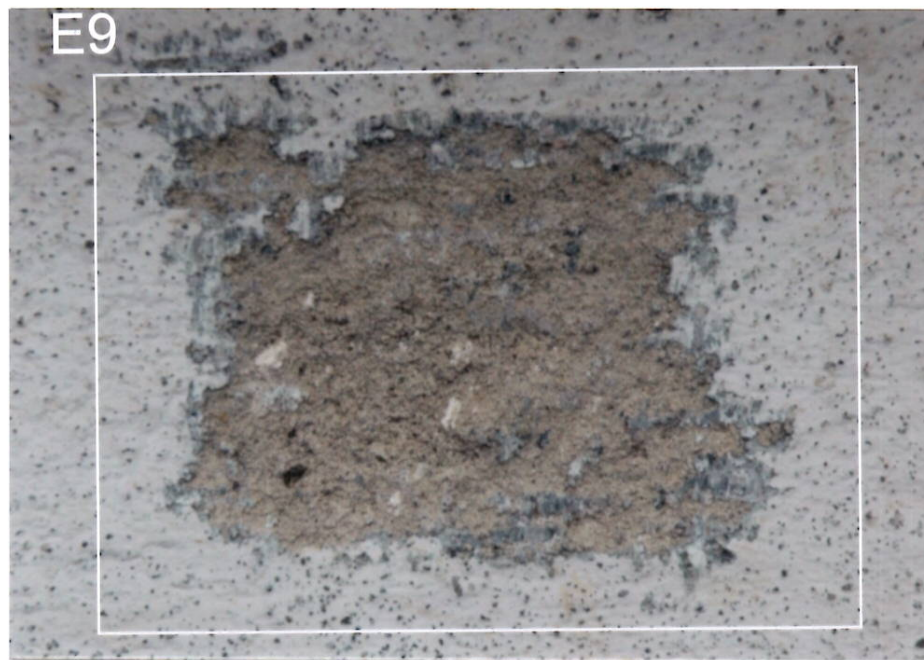
Odkrywka E9. Brak oryginalnych tynków.
