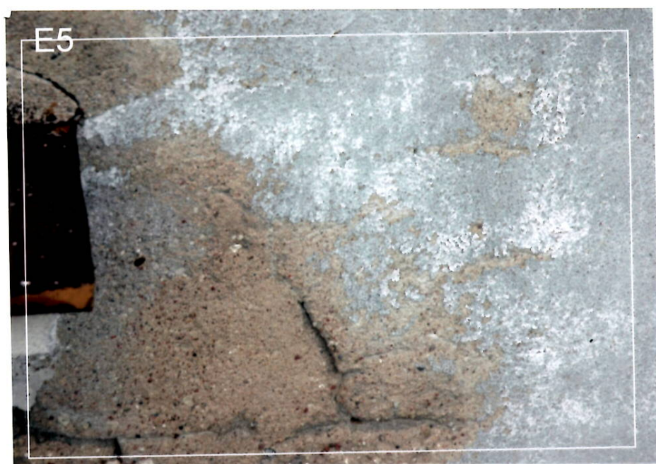
Odkrywka E5. Brak oryginalnych tynków.
