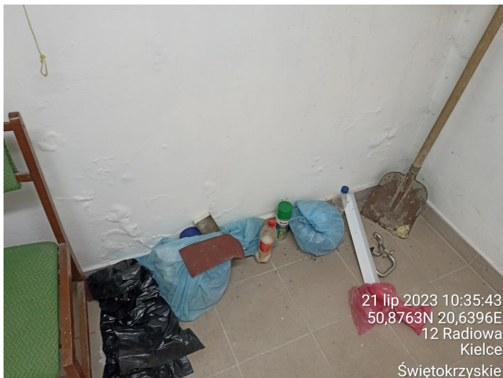
Fot. 15. Oparzenia tynków w pomieszczeniu Warsztat mech. – pomiar nr. 9.
