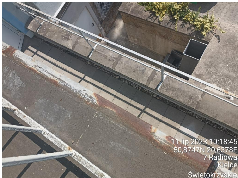
Fot. 38. Pordzewiałe elementy obróbek blacharskich balkonu.
