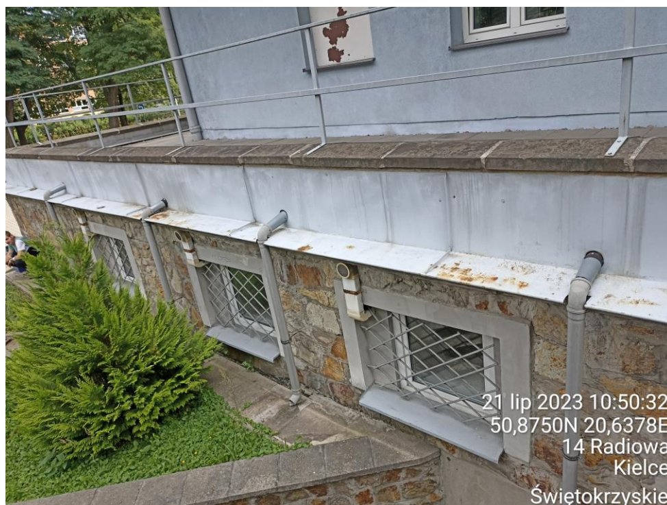
Fot. 30. Pordzewiałe obróbki blacharskie ścian tarasu.
