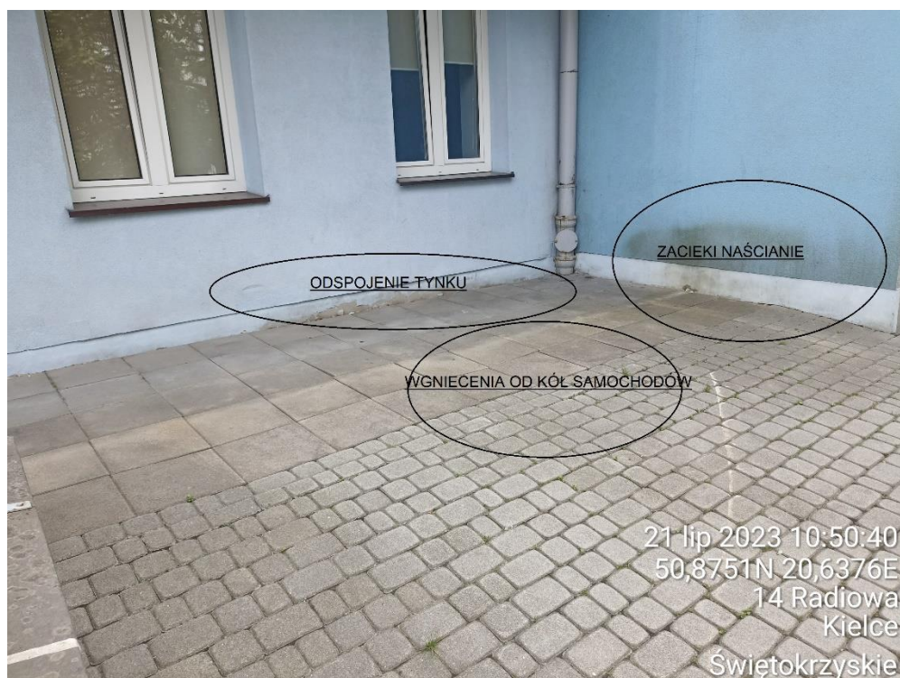
Fot. 33. Usterki tarasu i ścian parteru
