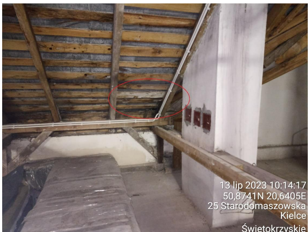
Fot. 43. Widok dachu od wewnątrz w miejscu destrukcji gzymsu (Fot. 42.)
