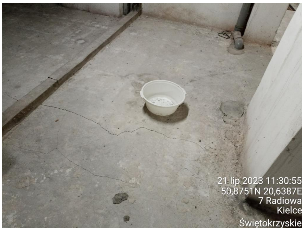
Fot. 45. Miejscowe przecieki z poszycia dachu.
