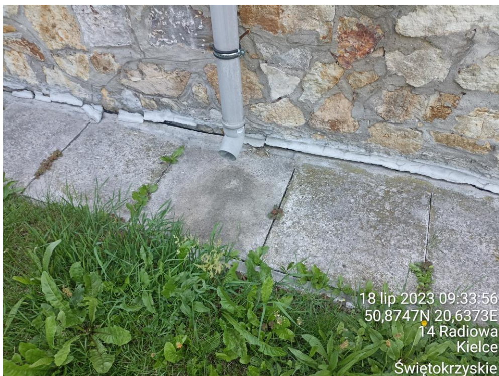
Fot. 29. Stan opaski – widoczne odspojenie od ściany i obniżenie opaski w stosunku do terenu.
