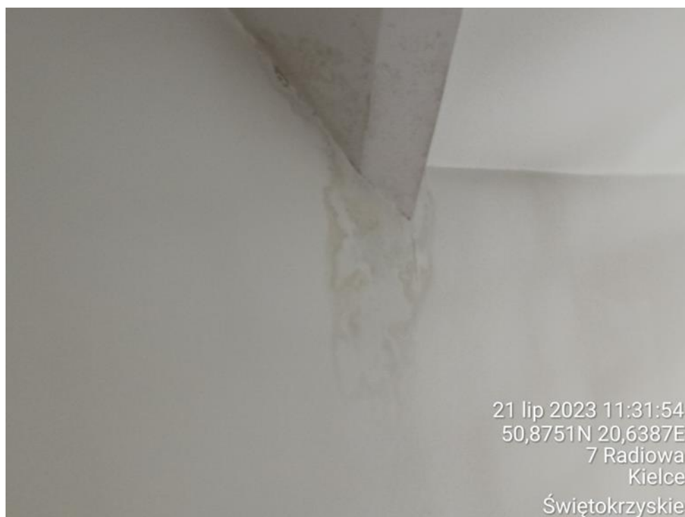
Fot. 41. Zaciek na klatce schodowej z miejscowego przecieku z dachu.
