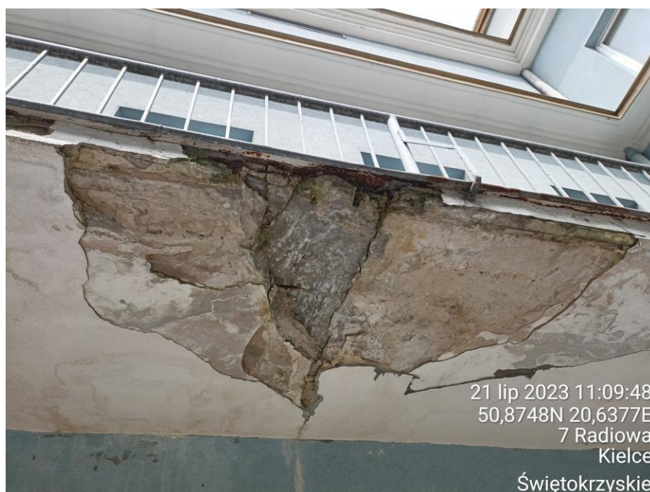
Fot. 6. Widok uszkodzenia płyty balkonu.
