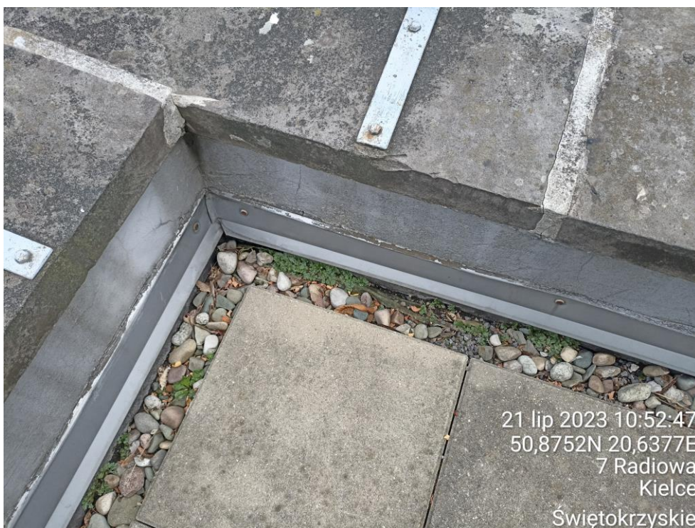
Fot. 32. Niedrożność odwodnienia warstw tarasu spowodowana brakiem systematycznego przeglądu i konserwacji.
