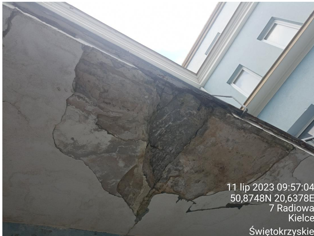
Fot. 34. Destrukcja konstrukcji płyty balkonu spowodowana błędem wykonania obróbki blacharskiej.
