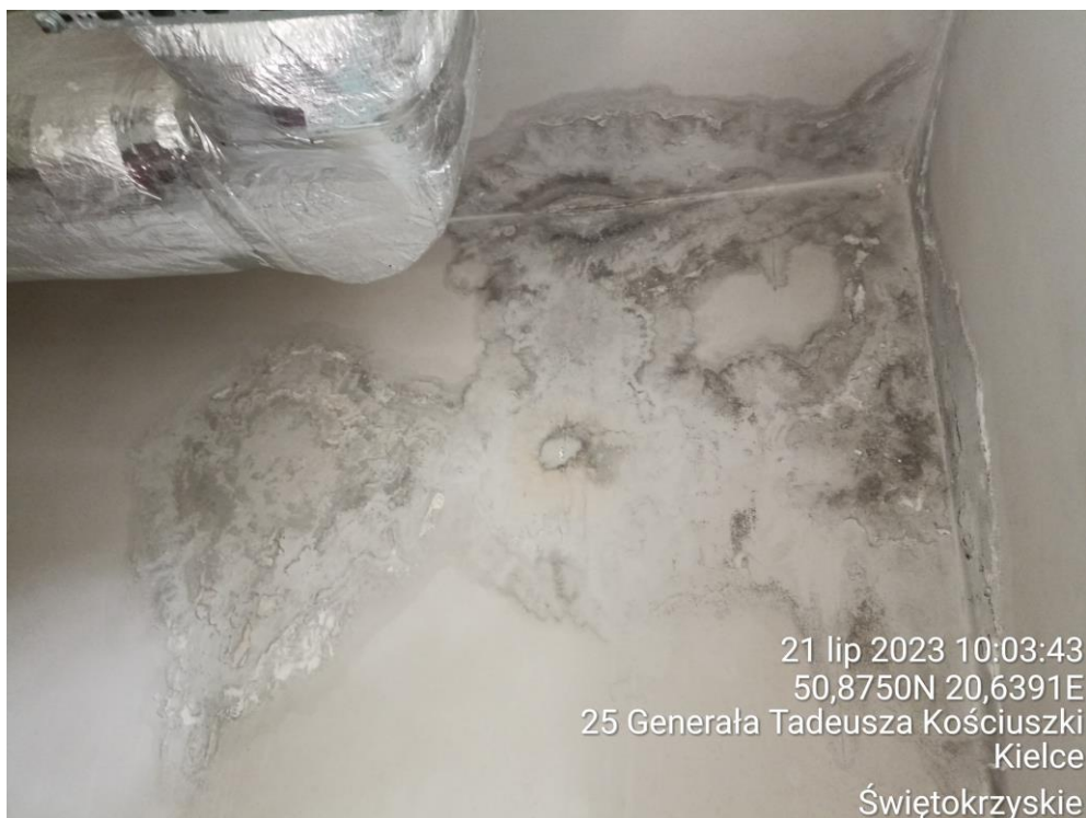
Fot. 11. Widok zacieków w pomieszczeniu Prasowni – pomiar 1; 2; 3.
