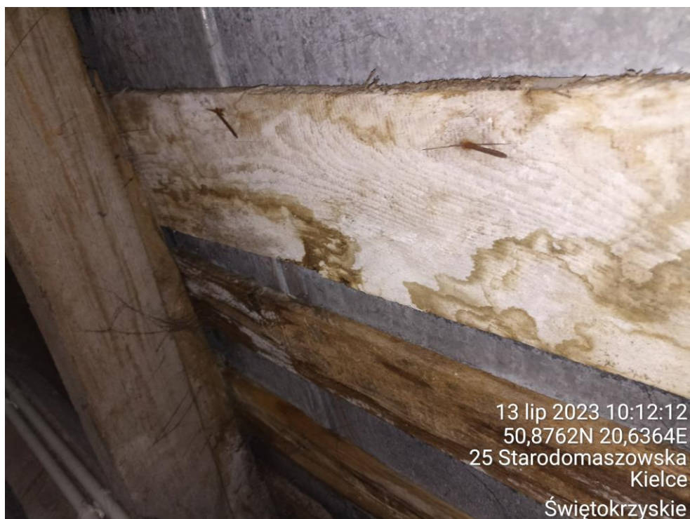
Fot. 44. Szczegół korozji odeskowania poszycia (Fot. 43).
