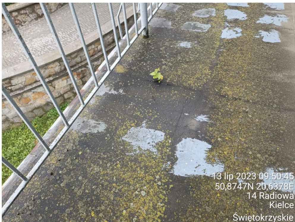
Fot. 39. Mech i rośliny na powierzchni balkonu.
