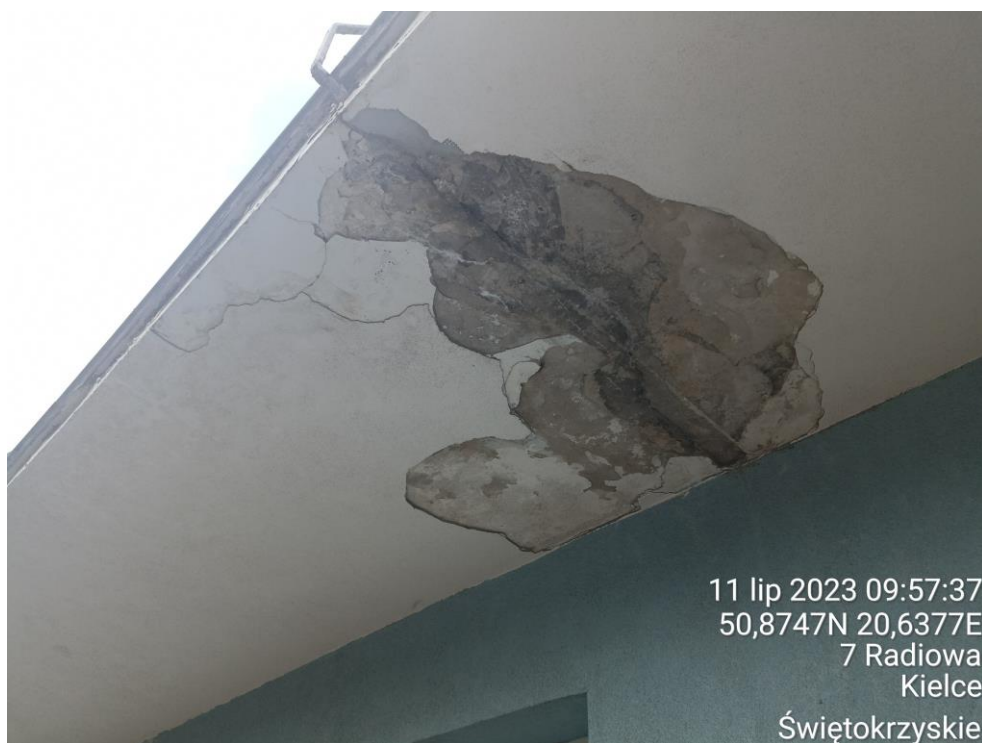
Fot. 35. Destrukcja konstrukcji płyty balkonu spowodowana nieszczelnością hydroizolacji balkonu.
