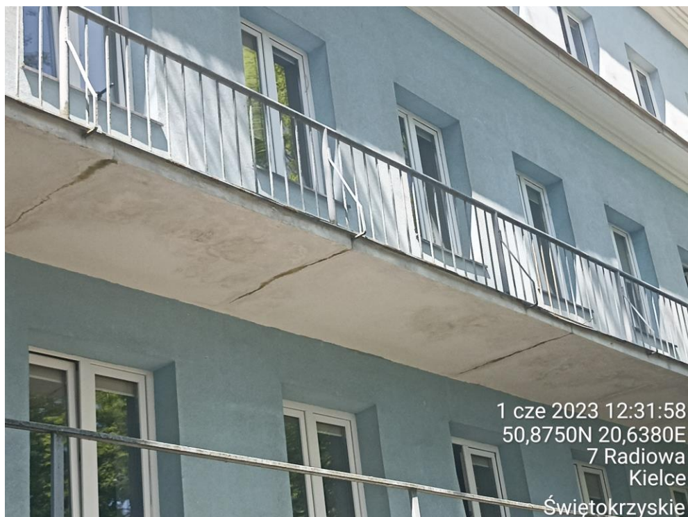
Fot. 37. Pęknięcia termiczne płyty balkonu spowodowane brakiem stosownej dylatacji.
