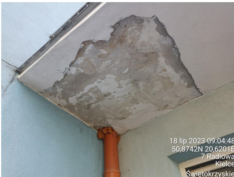
Fot. 36. Odpadnięcie tynku od spodu balkonu w wyniku nieszczelności rury odprowadzającej wodę z dachu.
