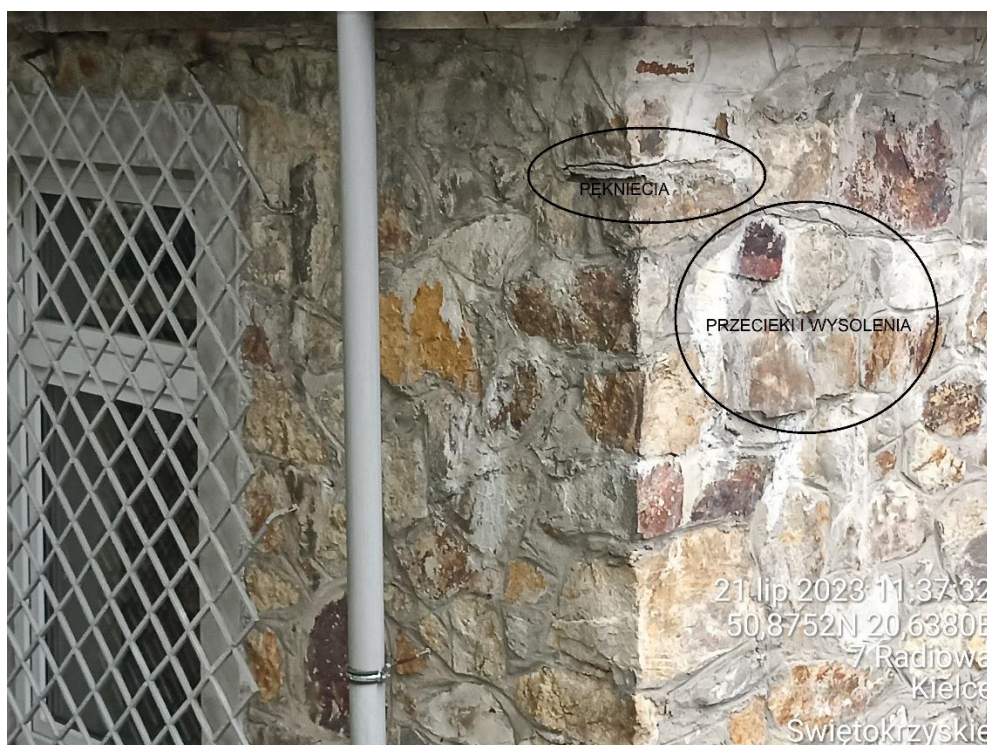
Fot. 28. Narożnik ściany piwnic od strony północno – wschodniej – widoczne zacieki, wysolenia i pęknięcia.
