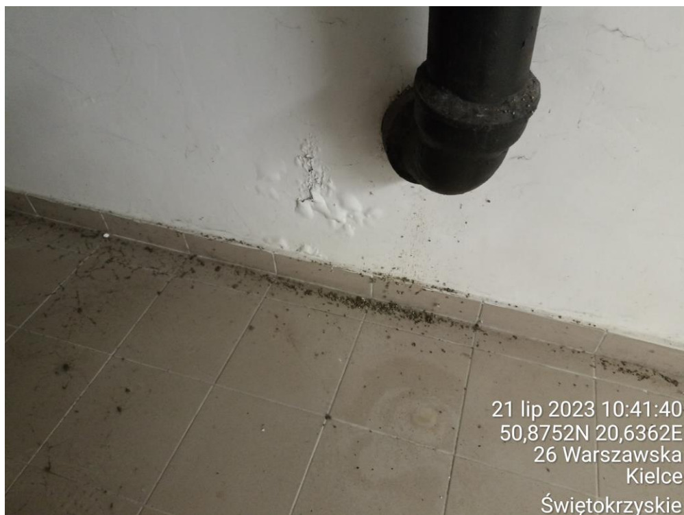
Fot. 17. Oparzenia tynków i przecieki z instalacji w pomieszczeniu Warsztat mech. – pomiar nr. 6.
