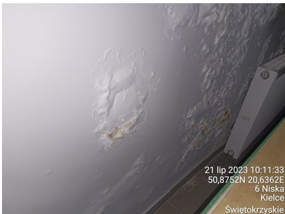
Fot. 25. Zacieki i oparzenia tynków w Schronie. – pomiar nr. 19.
