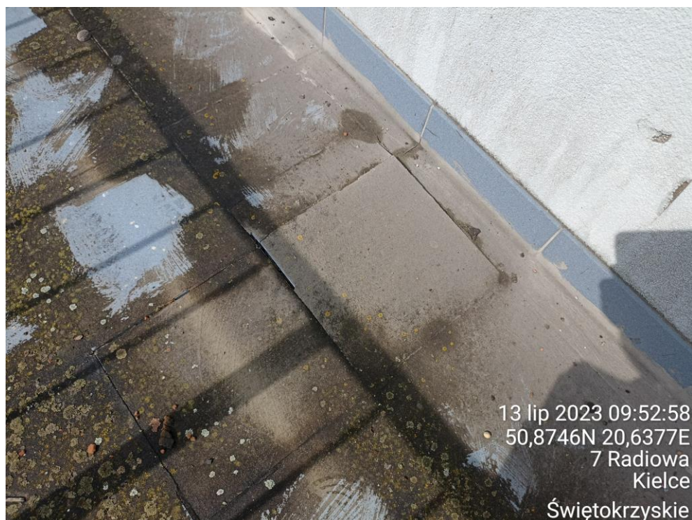
Fot. 40. Odspojone płytki warstwy wykończeniowej tarasu.
