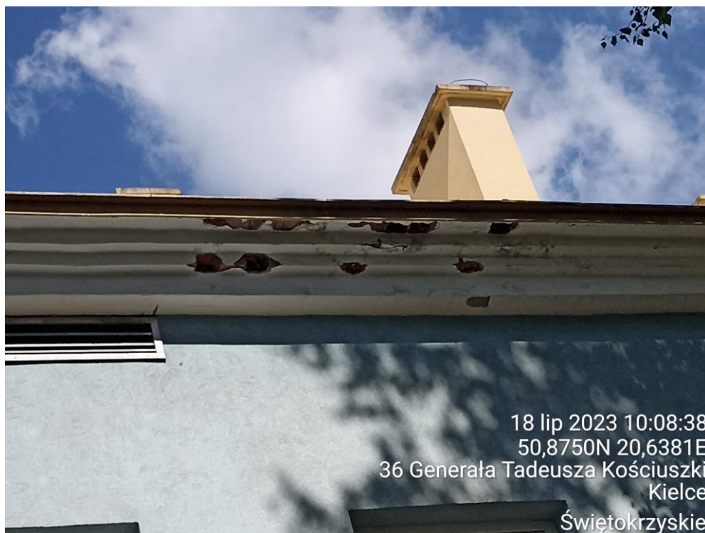
Fot. 42. Odpadające elementy gzymsu w wyniku uszkodzenia obróbek i poszycia dachu.
