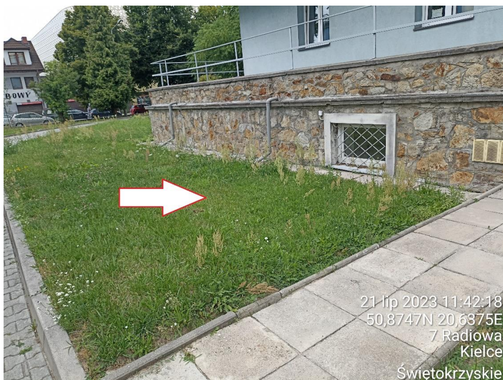
Fot. 27. Spadek terenu w kierunku budynku od strony południowej.
