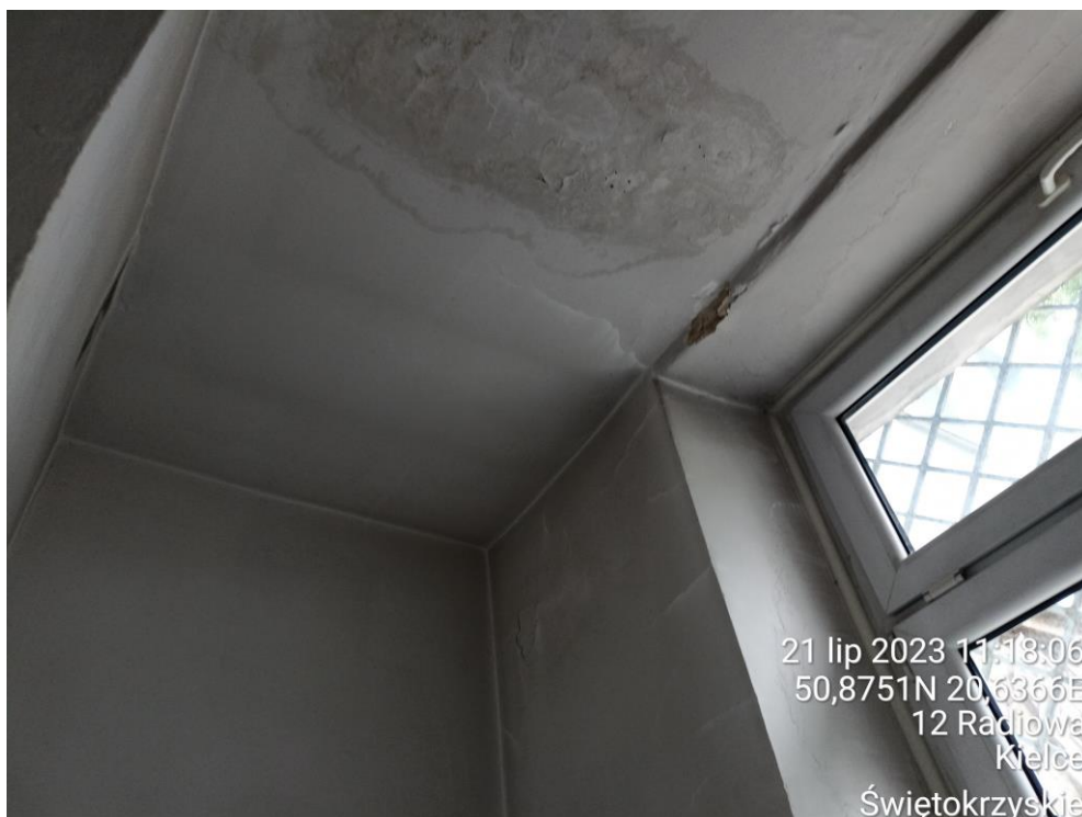
Fot. 13. Widok zacieków w pomieszczeniu Kotłowni – pomiar nr. 4.
