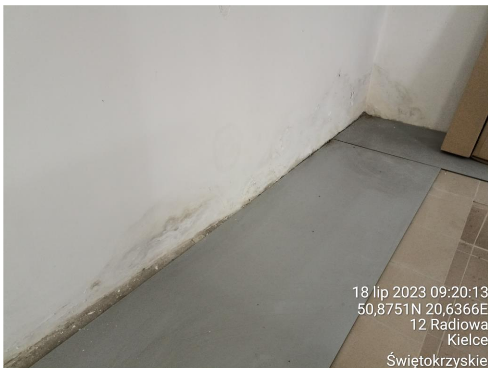
Fot. 23. Oparzenia tynków w pomieszczeniu Rozdzielni elektrycznej. – pomiar nr. 11. i 12.
