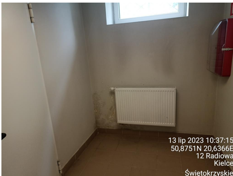
Fot. 19. Widok zacieków w Korytarzu piwnic – pomiar nr. 10.
