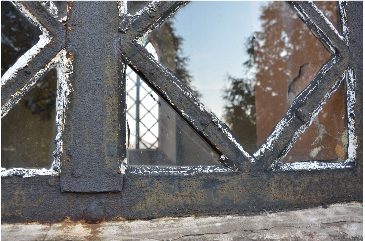
Fot. nr 4. Kaplica grobowa rodziny Drohojowskich z 1861 r. Widoczne na fotografii fragment stalowej ramy okiennej, silna korozja stalowych elementów, ubytki uszczelnień, nieprecyzyjne wtórne wypełnienia uszczelniające, przemalowania.
