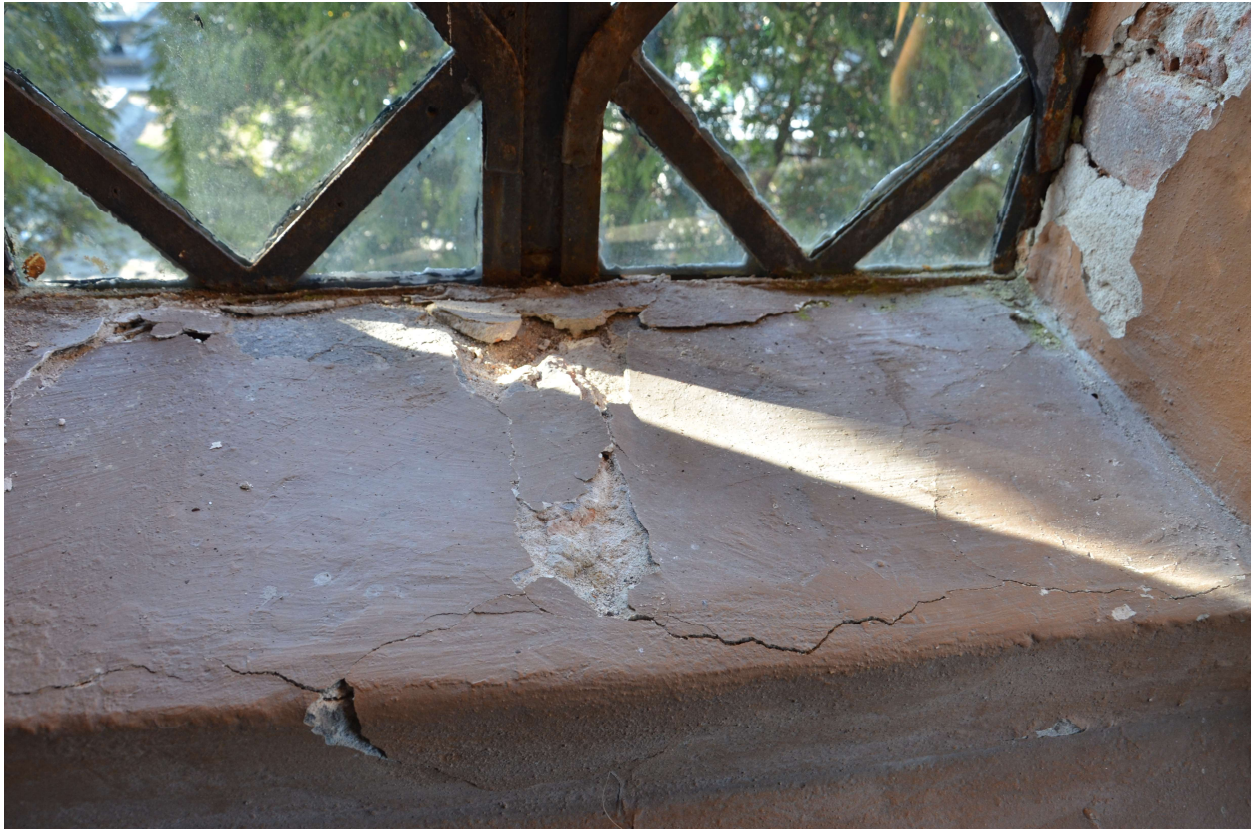
Fot. nr 9. Kaplica grobowa rodziny Drohojowskich z 1861 r. Widoczne na fotografii ubytki, spękania, odspojenia, przemalowania warstw tynku.
