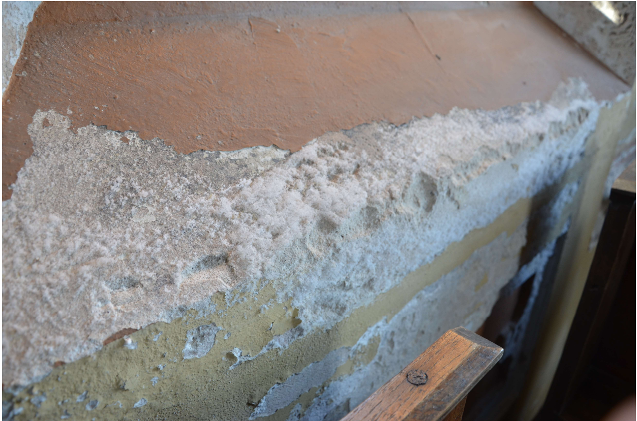
Fot. nr 8. Kaplica grobowa rodziny Drohojowskich z 1861 r. Widoczne na fotografii silna krystalizacja soli na powierzchni tynku w obrębie wnęki okiennej, dezintegracja strukturalna, ubytki, przemalowania tynku. Fot. Mariusz Wrona marzec 2018 r.
