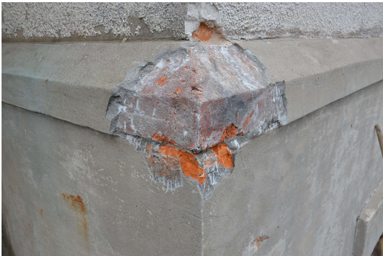
Fot. nr 14. Kaplica grobowa rodziny Drohojowskich z 1861 r. Widoczne na fotografii odkrywka wykonana w części nad cokółowej elewacji, ujawniająca kształtkę ceglana stanowiącą pierwotną formę dekoracji.
