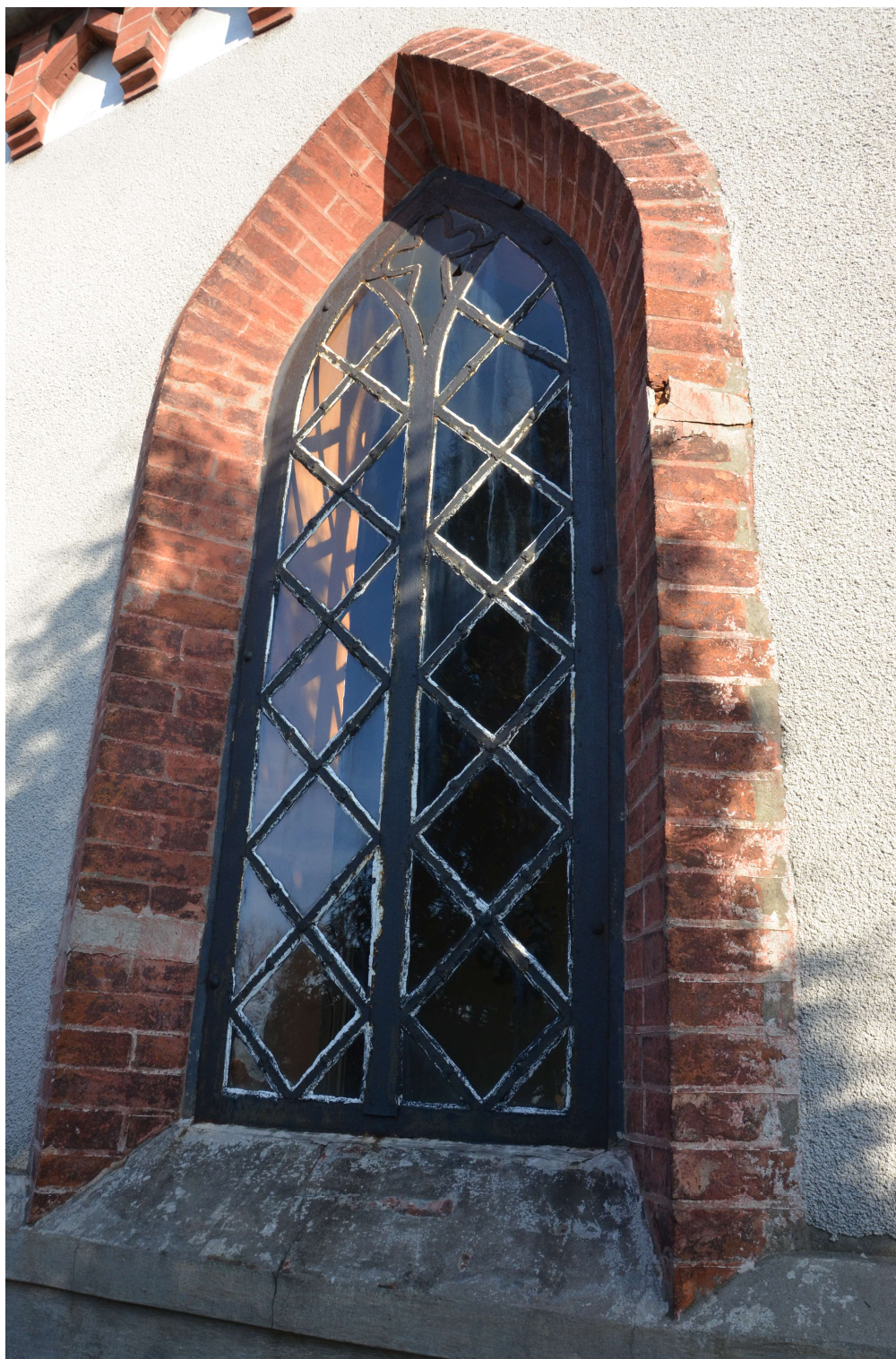
Fot. nr 5. Kaplica grobowa rodziny Drohojowskich z 1861 r. Widoczne na fotografii jedno z okien wraz ceglany obramieniem, silna korozja stalowej ramy okiennej, degradacja uszczelnień szklenia, zabrudzenia i ubytki w obrębie wstęgu ceglano i spoinowania, wtórna obrzutka tynkarska (cementowa) w parapetowej części wnętrza okiennej.
