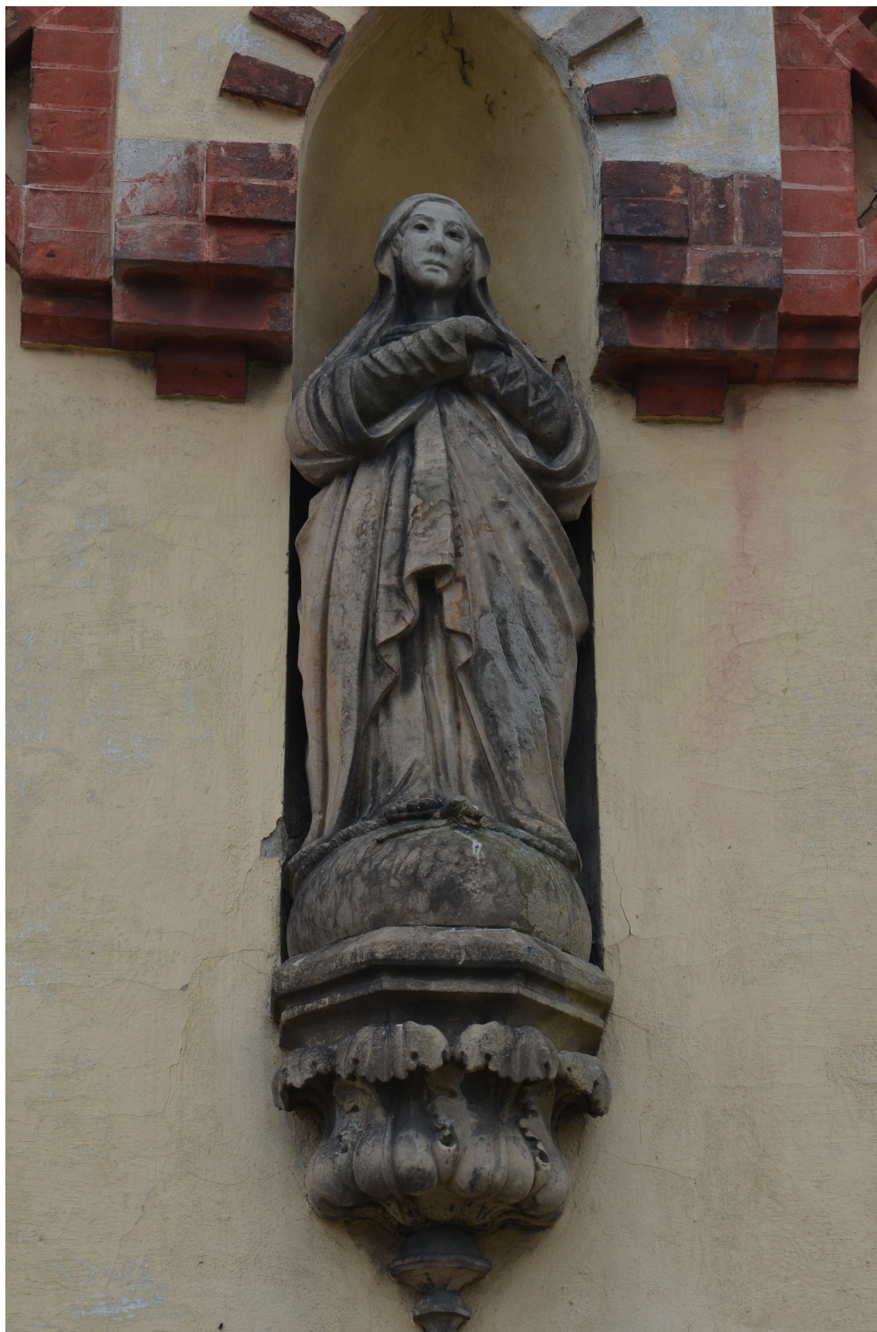
Fot. nr 15. Kaplica grobowa rodziny Drohojowskich z 1861 r. Widoczne na fotografii pełnoplastyczna rzeźba Matki Boskiej, zabrudzenia, patyna atmosferyczna, ubytki formy rzeźbiarskiej, uzupełnienia ubytków kamienia zaprawą cementową (część portretowa, draperia).
