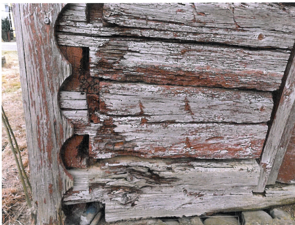
Fot. 10. Zniszczenia korozyjne zrębu przy narożniku północno-zachodnim
