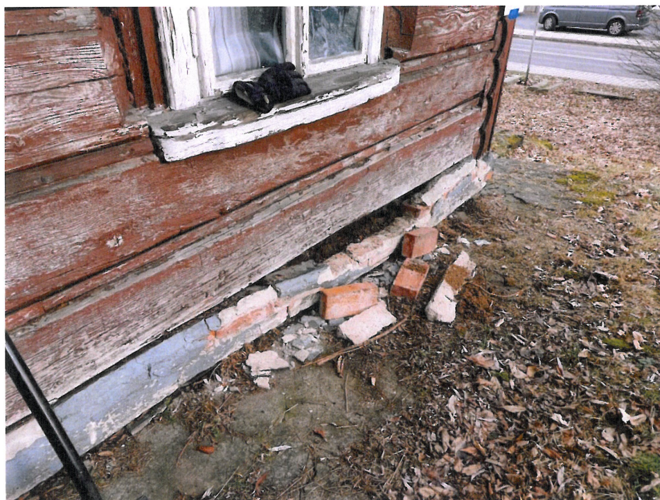
Fot. 5. Odkrywka murowanej opaski na ścianie południowej
