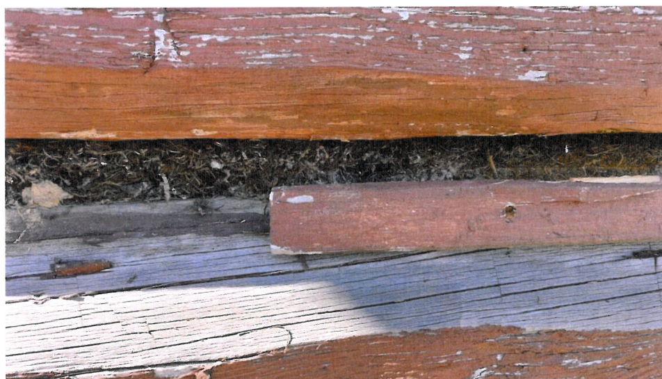
Fot. 11. Uszczelnienie styków bali wełną drzewną (mszenie styków) za maskującymi listwami na elewacjach wschodniej, południowej i północnej – odkrywka listwy
