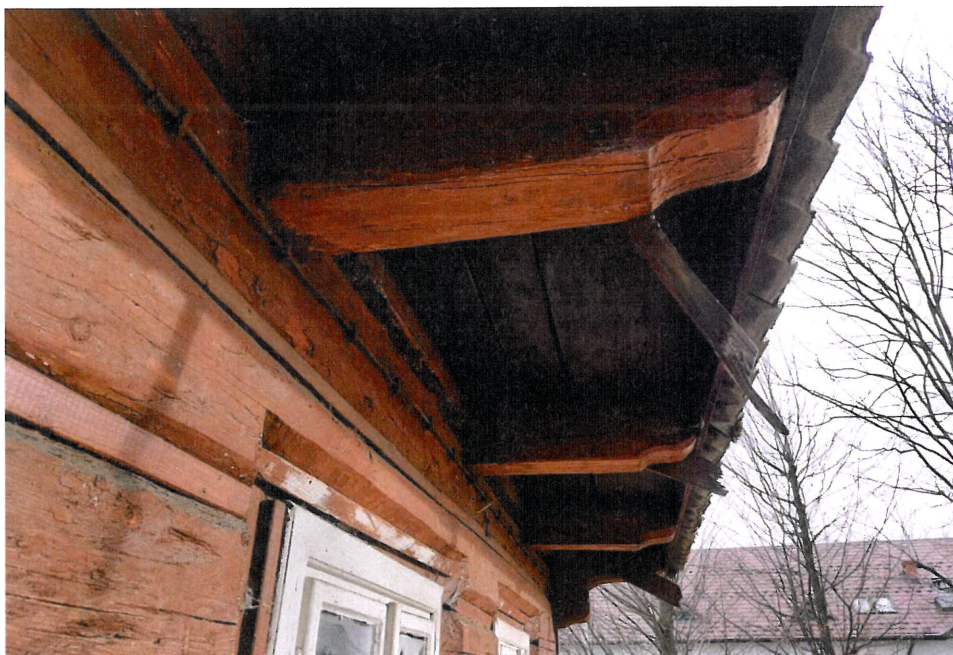
Fot. 14. Pozostałości wsporników pod rynnę – ściana południowa
