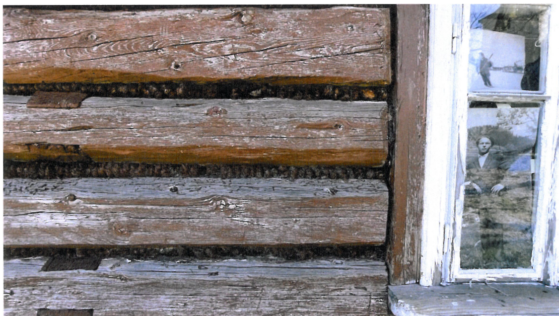
Fot. 13. Uszczelnienie styków bali warkoczami ze słomy na fragmencie elewacji zachodniej
