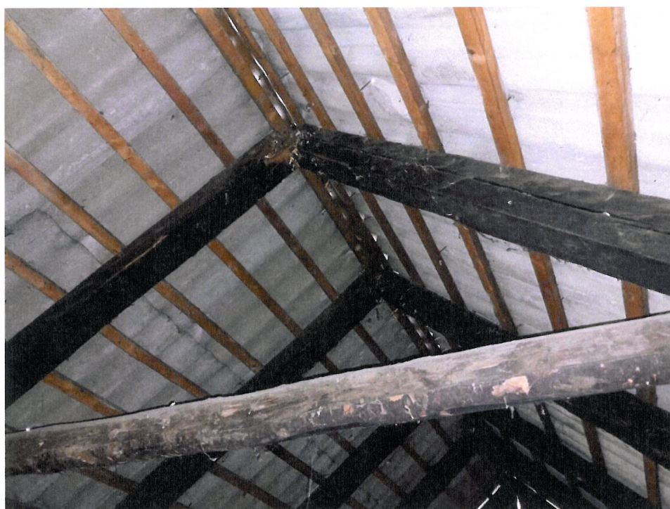
Fot. 24. Uszkodzenia korozyjne elementów więźby
