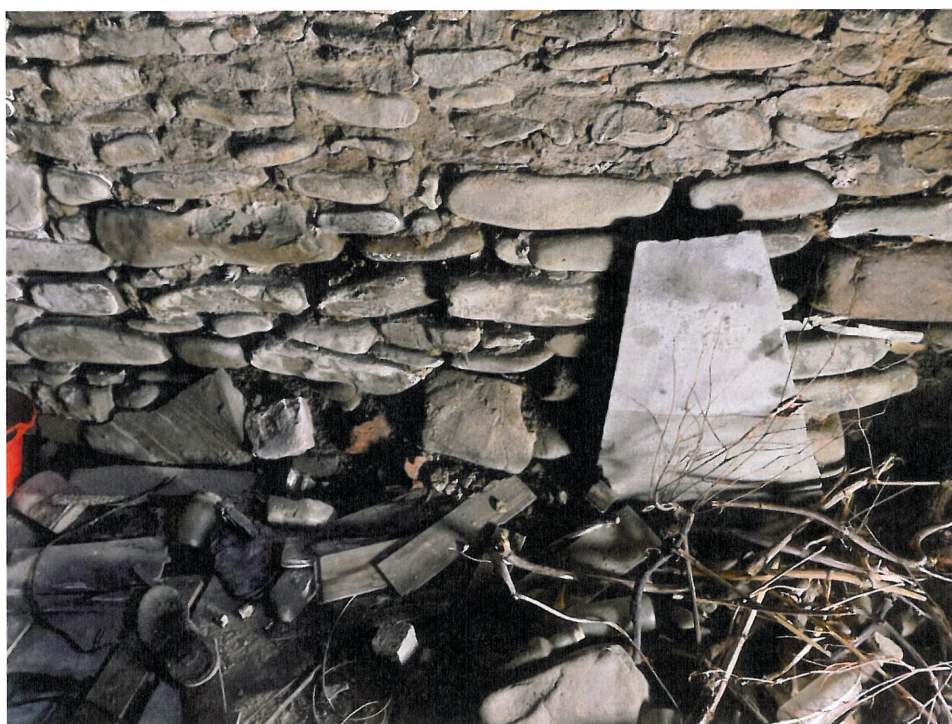
Fot. 20. Uszkodzenia murów piwniczki przy posadzce
