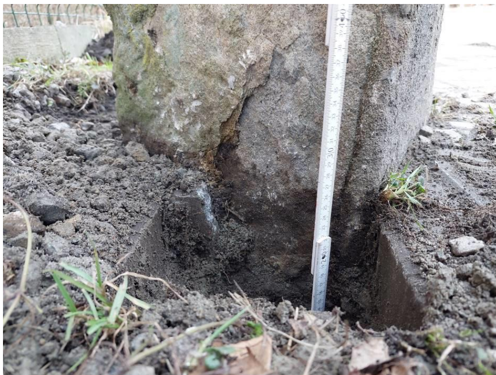
Rys. 6. Odspojenia powierzchniowych warstw kamienia przy podstawie słupa
