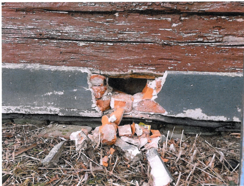
Fot. 6. Odkrywka murowanej opaski na ścianie zachodniej
