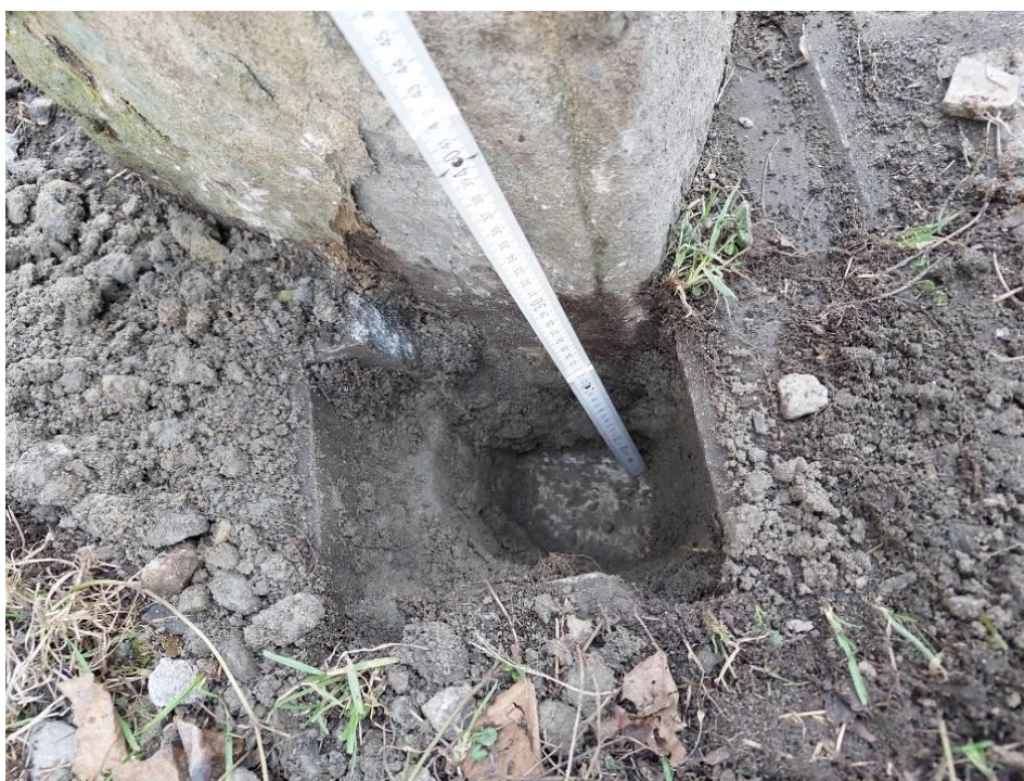
Rys. 4. Odkrywka nawierzchni chodnika przy słupie; na głębokości 25 cm pod nawierzchnią chodnika widoczna górna powierzchnia kamiennej podstawy
