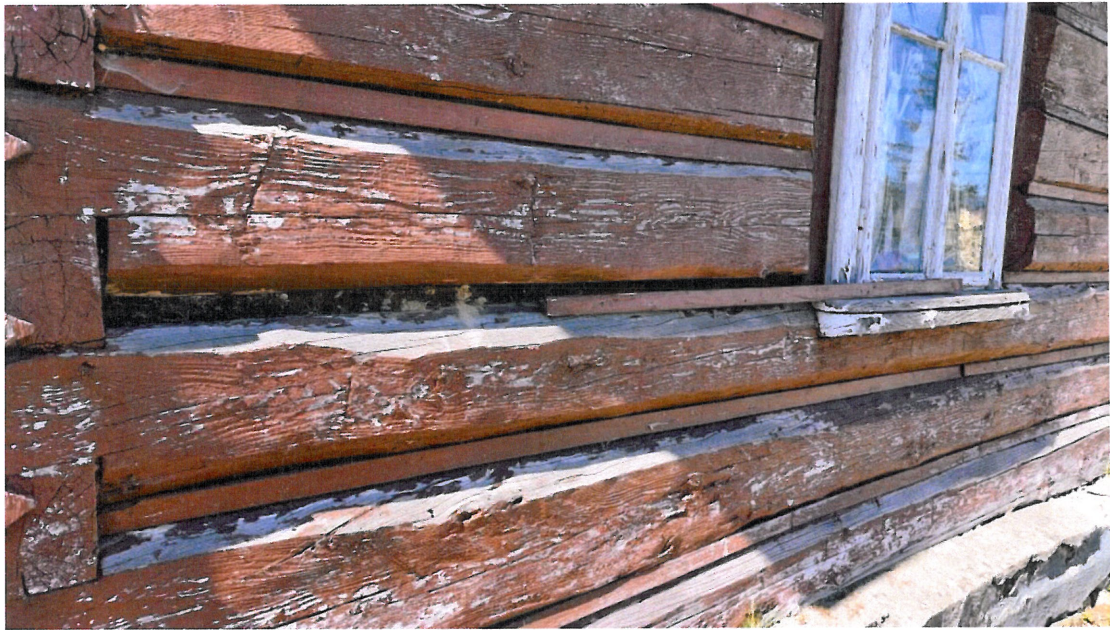
Fot. 12. Uszczelnienie styków bali wełną drzewną (mszenie styków) za maskującymi listwami na elewacjach wschodniej, południowej i północnej – odkrywka listwy na elewacji wschodniej
