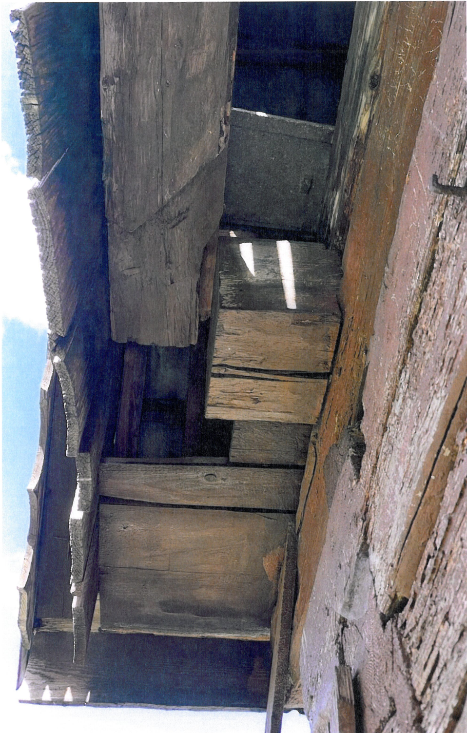
Fot. 26. Osunięta z oczepu belka skrajna szczytu przy elewacji zachodniej
