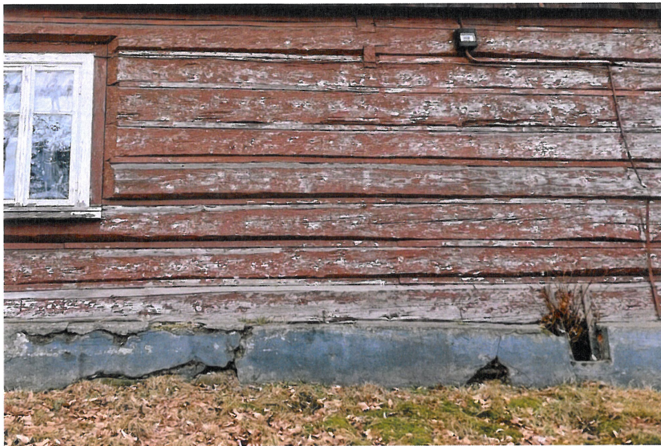
Fot. 8. Stan opaski z otynkowanego kamienia polnego – strona wschodnia
