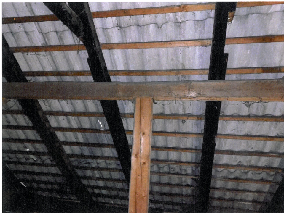
Fot. 25. Osłabienie krokwi głębokimi wcięciami, spękania i uszkodzenia korozyjne
