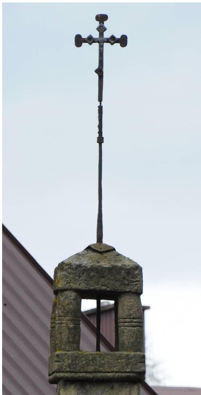
Rys. 8. Metalowy krzyż kapliczki, widoczne ubytki materiału
