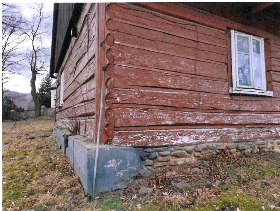
Fot. 9. Stan opaski z otynkowanego kamienia polnego – strona wschodnia i fragment północnej
