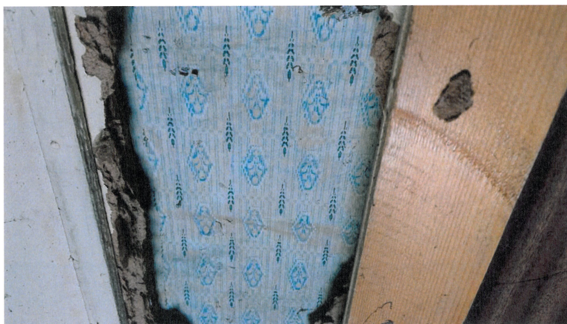
Fot. 16. Odkrywka okładziny na zewnętrznych ścianach zrębu
