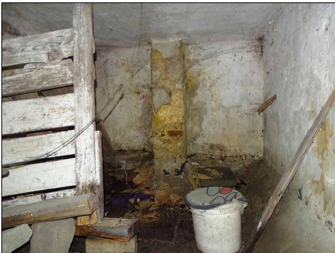
Fot.[19] Destrukcje tynków ścian piwnicy. Fot. autor.
