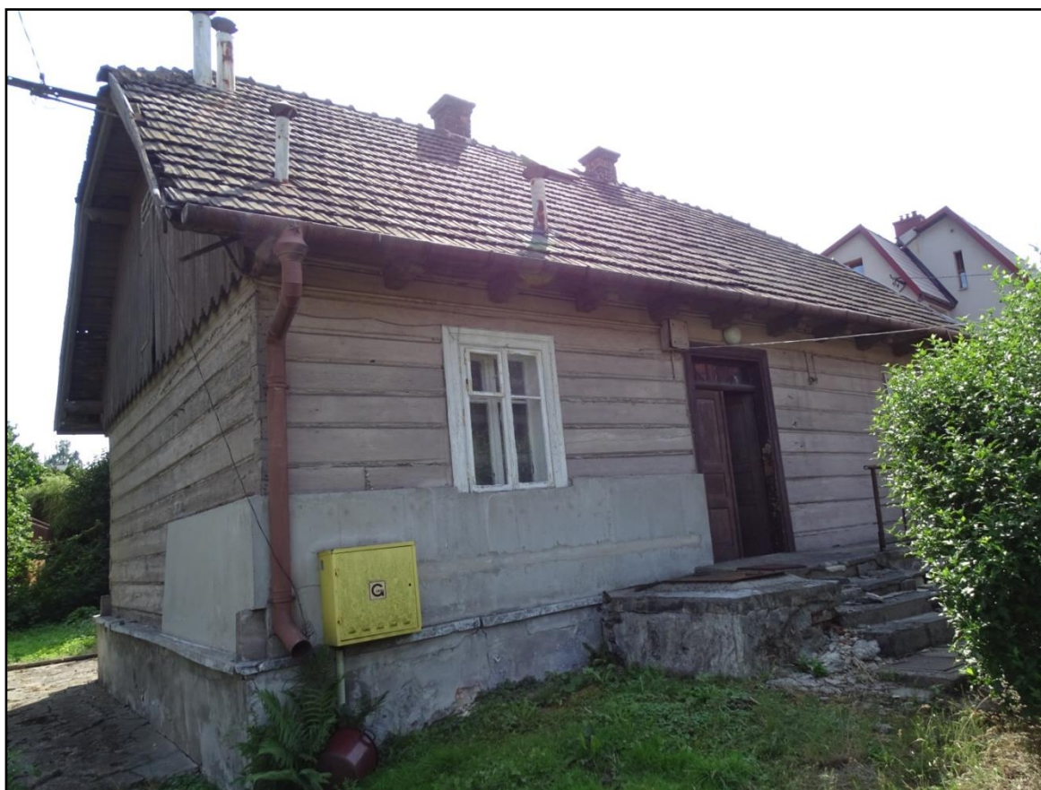
Fot.[5] Wygląd elewacji północnej budynku. Widoczna rozległa destrukcja schodów wejściowych, widoczne uzupełnienia ścianą murowaną z ociepleniem ze styropianu. Fot. autor.
