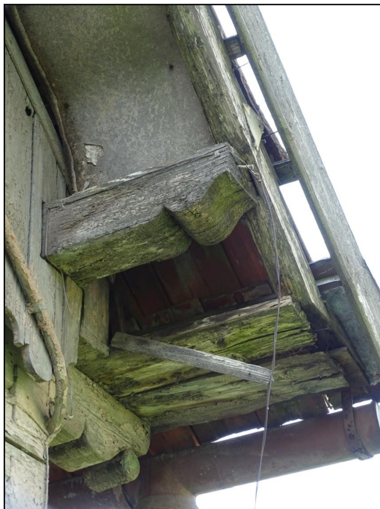
Fot.[9] Wygląd narożnika okapu elewacji północno - wschodniej budynku. Ubytki pokrycia dachu w obrębie okapu, widoczna obecność grzybów domowych z IV grupy szkodliwości. Fot. autor.
