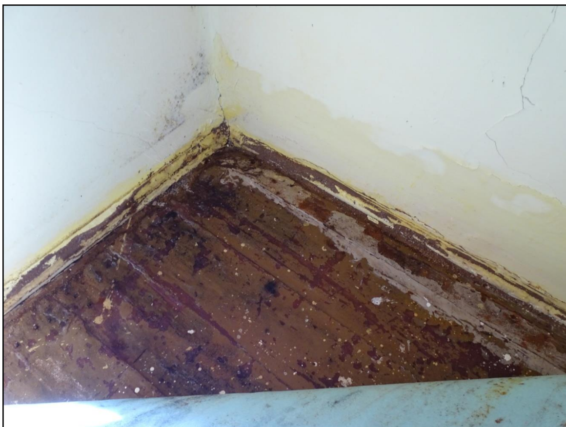
Fot.[24] Pomieszczenie południowo – wschodnie, narożnik ścian zewnętrznych. Widoczny rozwój grzyba domowego właściwego ( Serpula lacrymans ) . Fot. autor.
