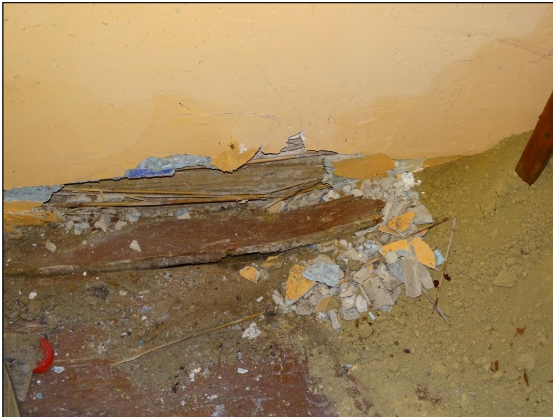
Fot.[17] Zapadnięcie podłogi oraz widoczna zgnilizna brunatna podwaliny ściany i deski podłogowej. Fot. autor.
