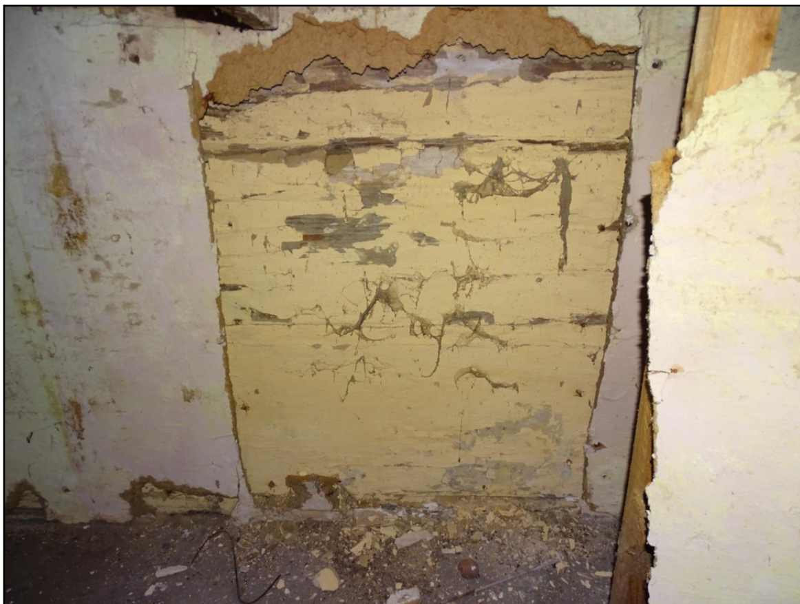
Fot.[18] Pomieszczenie gospodarcze – odkrywka ściany zachodniej - widoczna zgnilizna brunatna podwaliny ściany. Fot. autor.
