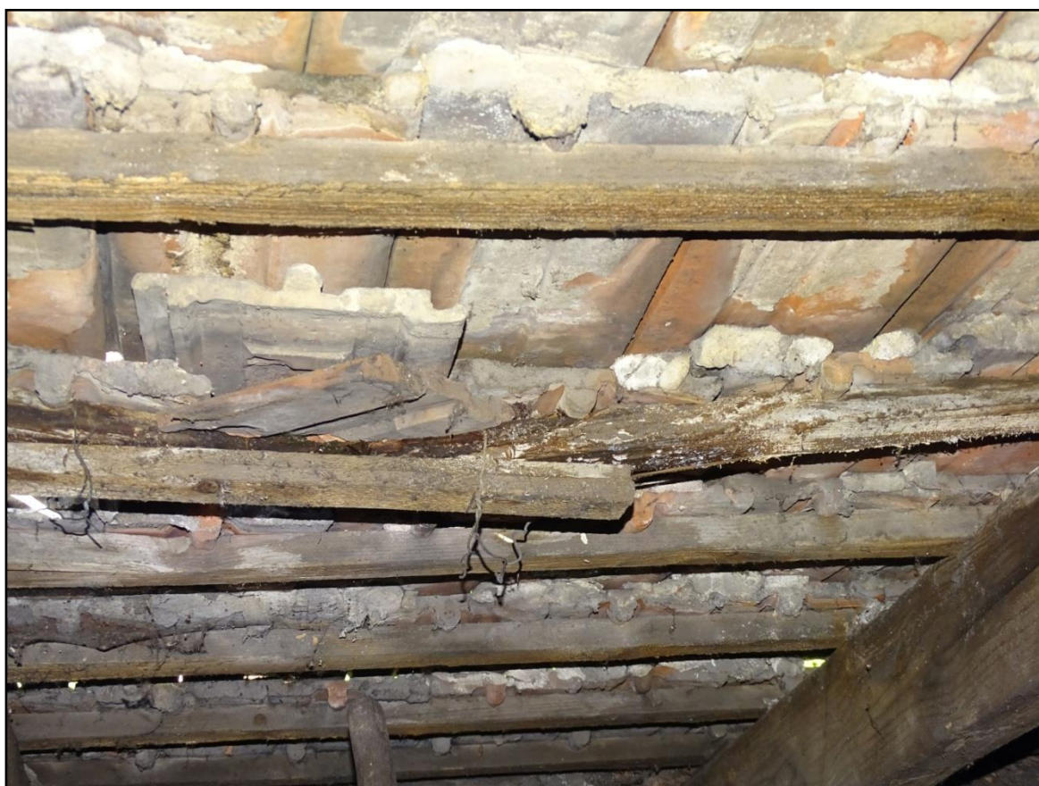
Fot.[23] Destrukcyjne działanie grzybów domowych systematycznie zawilgacanej przez wody opadowe. Fot. autor.
