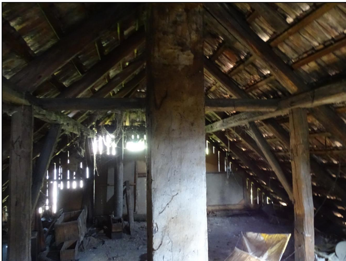
Fot.[22] Wygląd przestrzeni strychowej. Widoczne prześwity w pokryciu dachu. Fot. autor.
