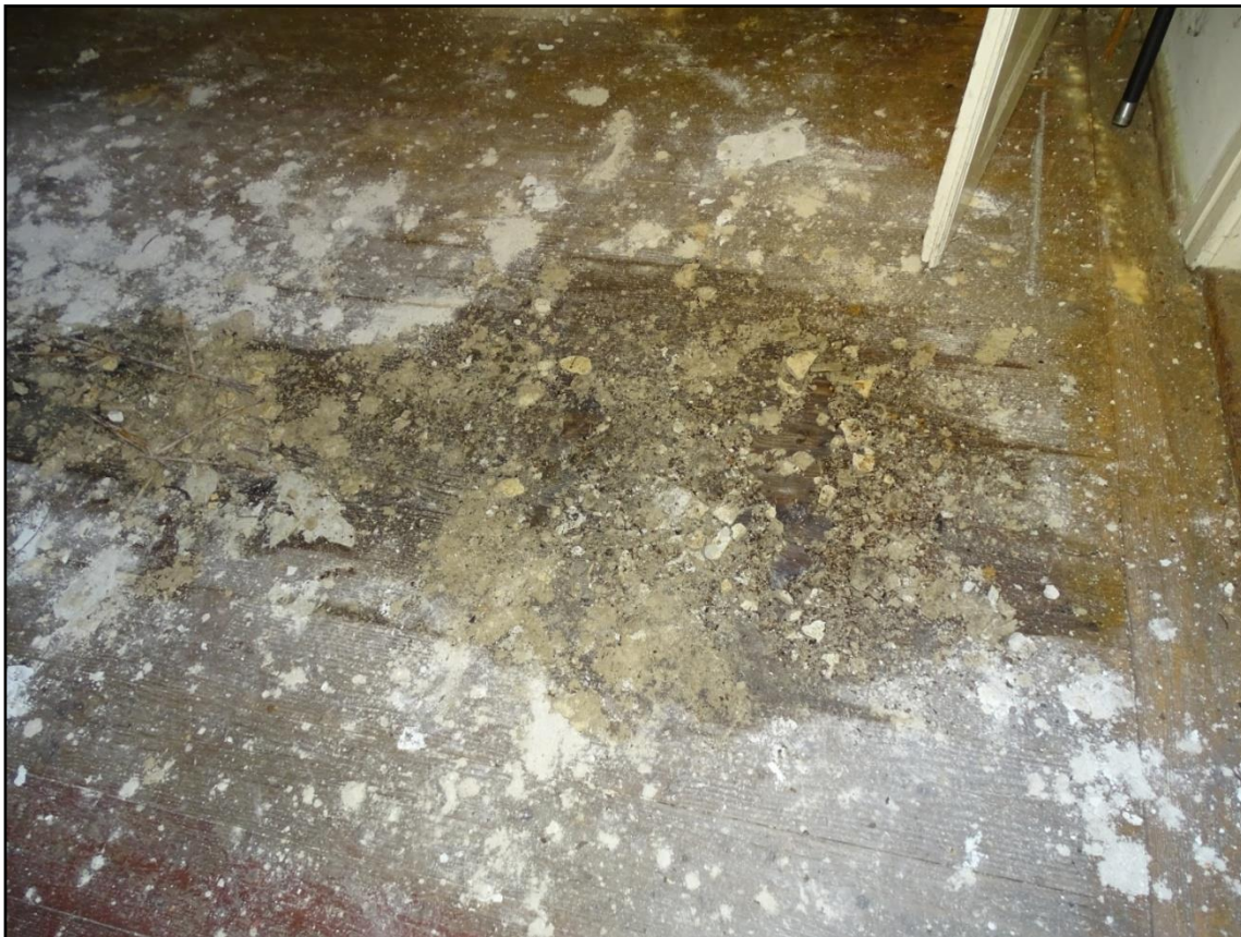
Fot.[15] Wygląd korytarza budynku. Widoczna rozległa destrukcja drewnianej podłogi wywołana atakiem grzyba domowego. Fot. autor.
