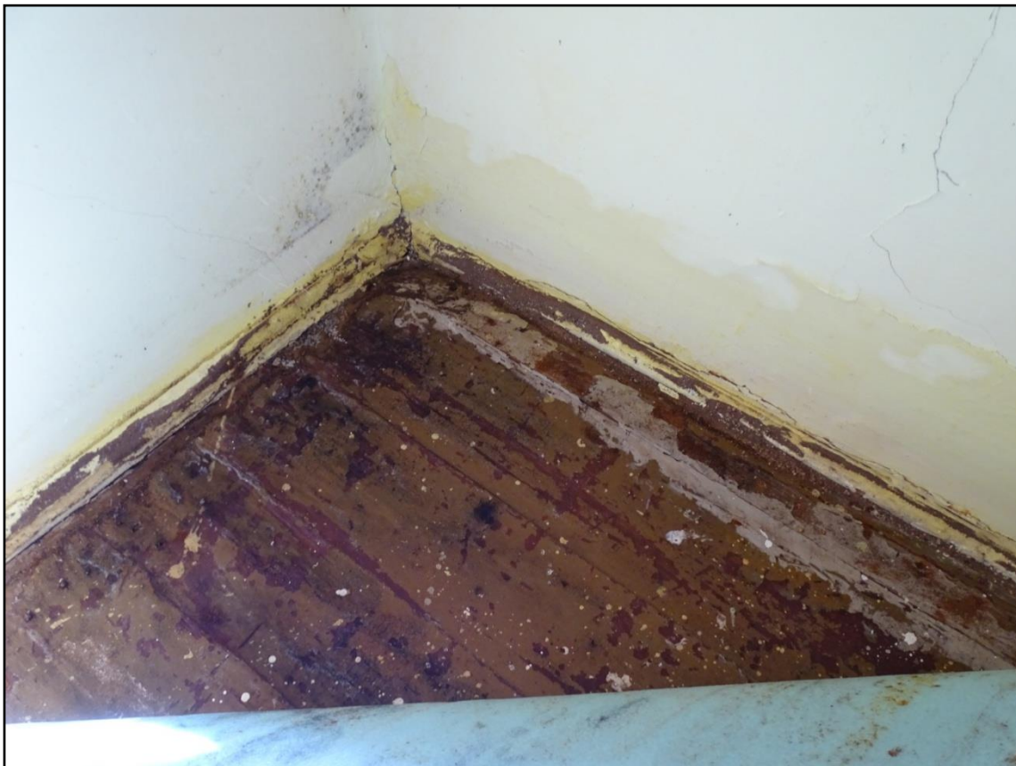
Fot.[14] Wygląd narożnika południowo – wschodniego w pomieszczeniu w budynku. Widoczna rozległa destrukcja podłóg drewnianych zakrytych wykładziną winylową z aktywnym atakiem grzyba domowego. Widoczny zakres zawilgocenia ścian. Fot. autor.
