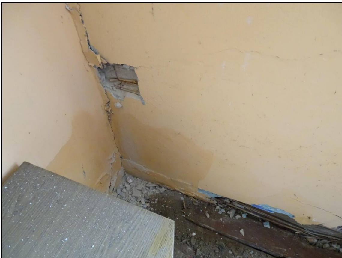
Fot.[16] Wygląd narożnika pokoju południowo- zachodniego i ganku budynku. Widoczna rozległa destrukcja podwaliny wywołana atakiem grzyba domowego. Widoczne pęknięcie ściany, zawilgocenie i osiadanie podłogi. Fot. autor.
