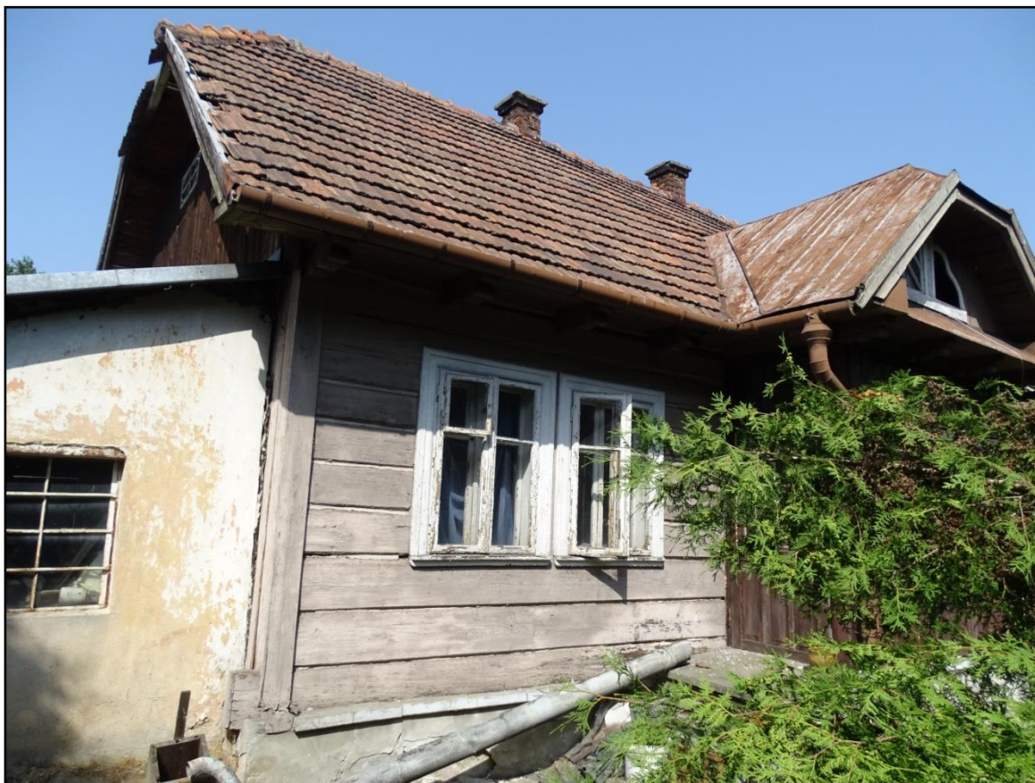
Fot.[6] Wygląd elewacji południowej budynku. Ubytki pokrycia dachu w obrębie okapu. Fot. autor.
