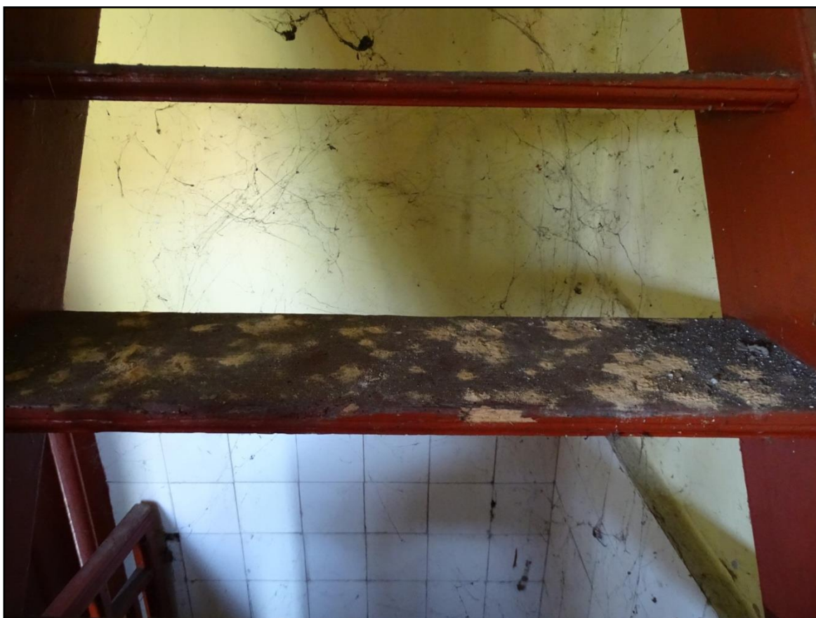
Fot.[21] Znaczne uszkodzenia stopni schodowych prowadzących na strych. Osypująca się mączka drzewna świadczy o aktywności owadów. Fot. autor.
