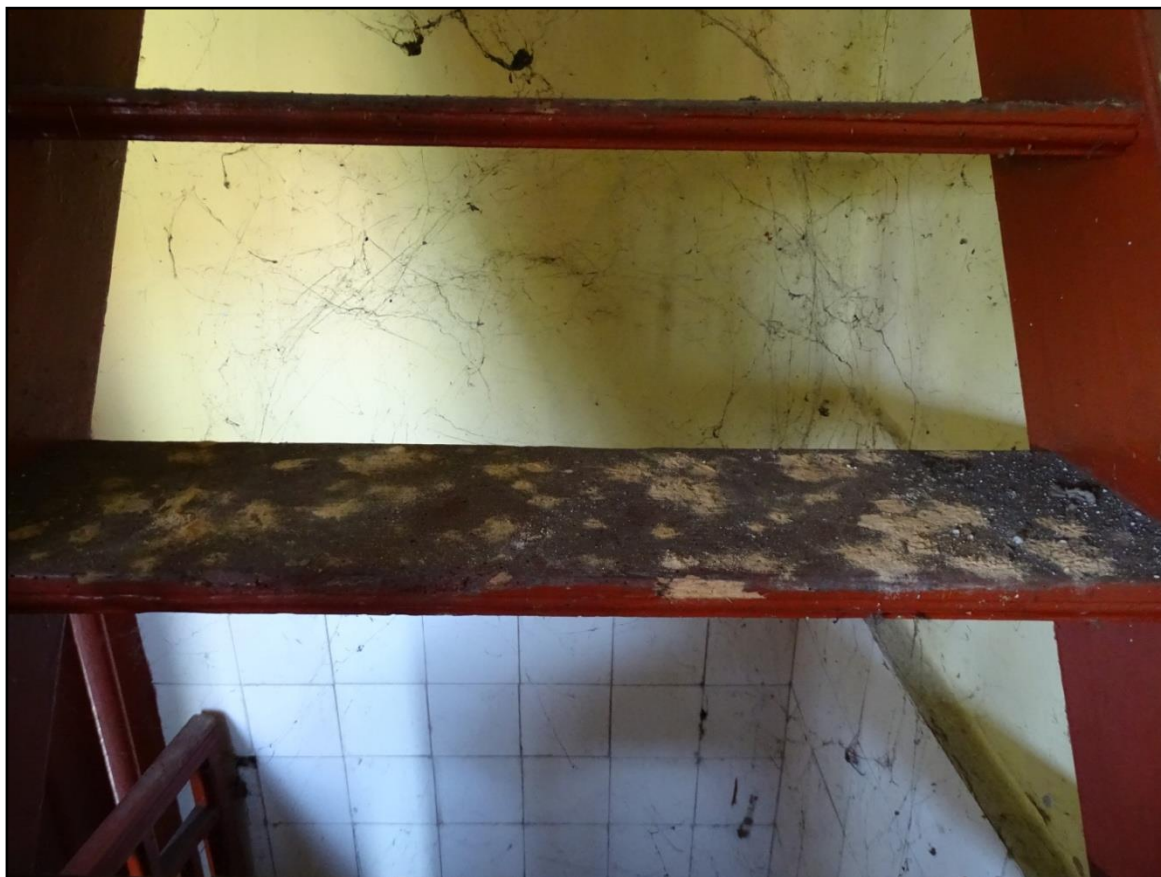
Fot.[27] Kołatek domowy ( Anobium punctatum ) - zaatakowane stopnie schodowe na strychu. Widoczne otwory z osypem mączki drzewnej świadczą o aktywnej obecności owadów, które spowodowały znaczne osłabienie struktury drewna. Fot. autor.
