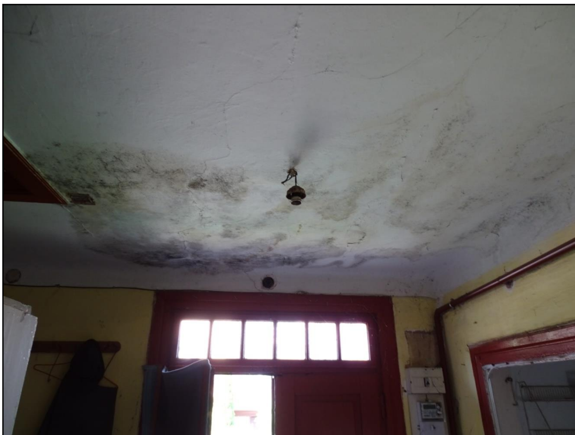
Fot.[13] Wygląd przedsionka budynku. Widoczna rozległe zawilgocenie stropu drewnianego skutkiem nieszczelności dachu. Fot. autor.
