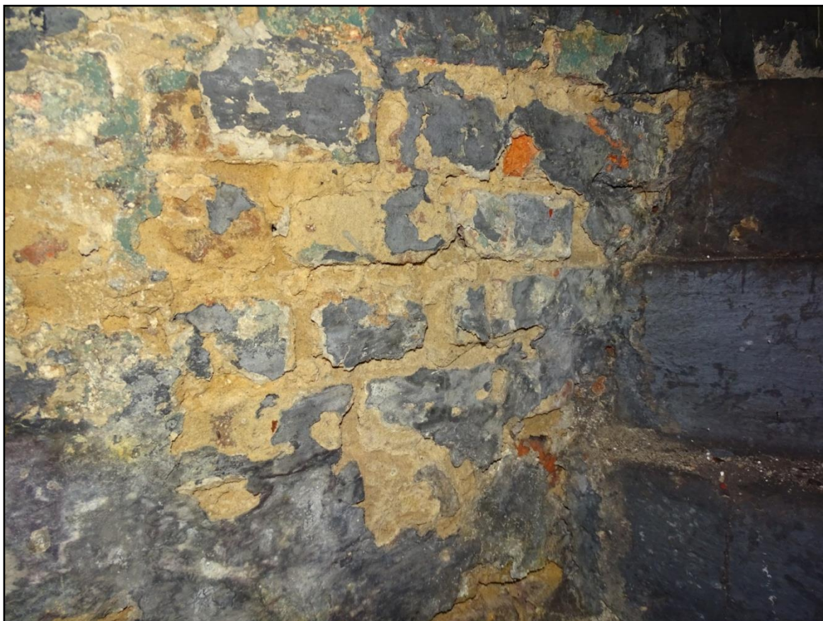
Fot.[20] Destrukcje tynków i cegieł ścian piwnicy. Fot. autor.
