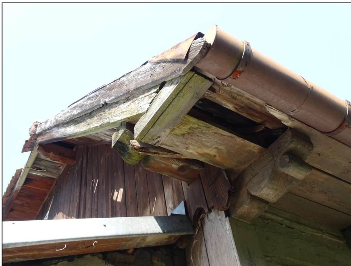
Fot.[25] Narożnik okapu południowo - zachodniego. Widoczny rozwój grzyba składowego ( Peniophoragigantea , Fr.). Fot. autor.
