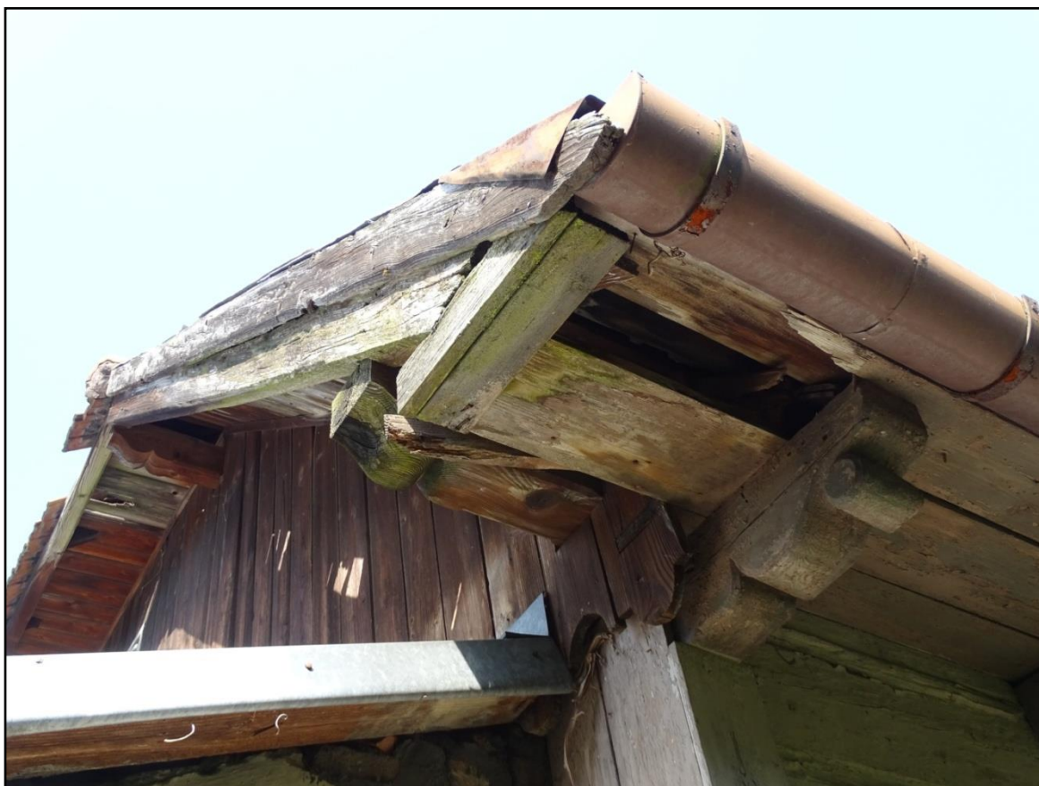
Fot.[7] Wygląd narożnika okapu elewacji południowo zachodniej budynku. Ubytki pokrycia dachu w obrębie okapu, widoczna obecność grzybów domowych z IV grupy szkodliwości. Fot. autor.
