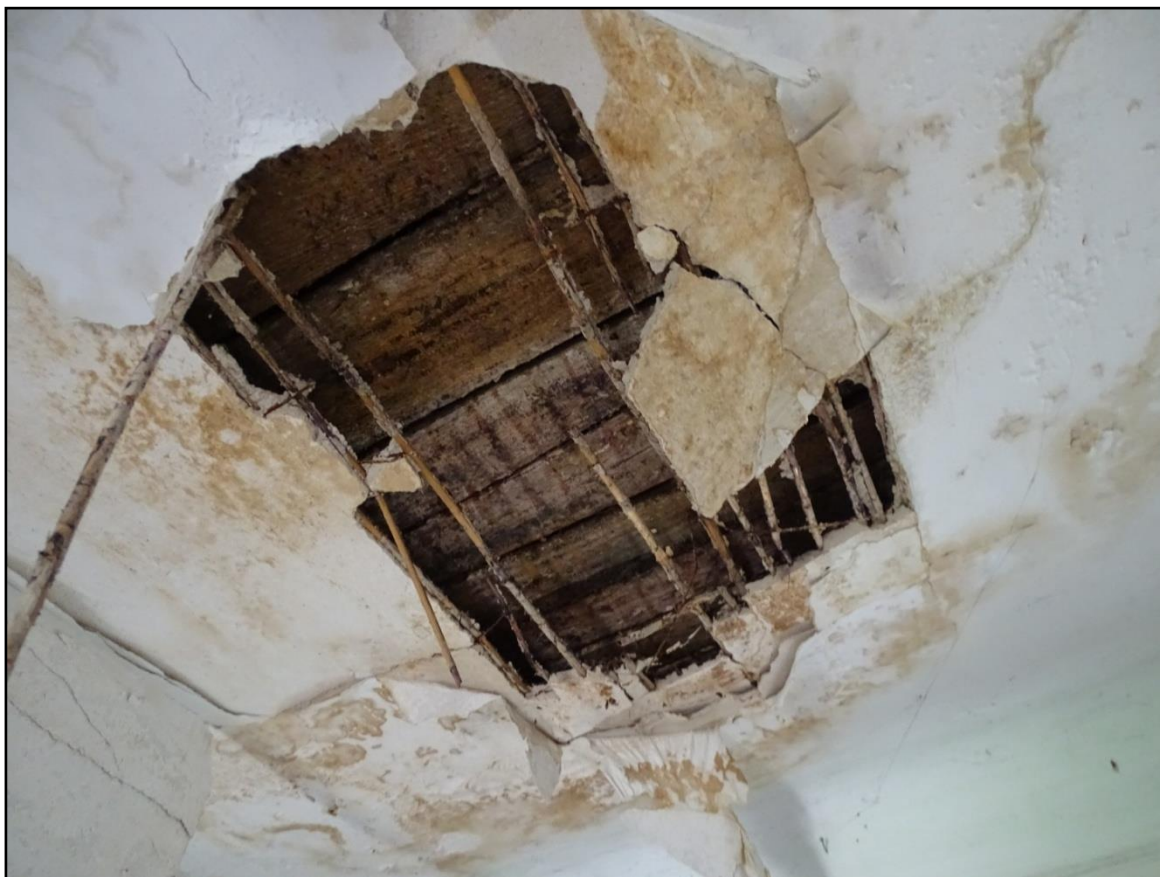
Fot.[12] Wygląd korytarza budynku. Widoczna rozległa destrukcja stropu drewnianego wywołana atakiem grzyba domowego – powiększenie szczegółu. Fot. autor.
