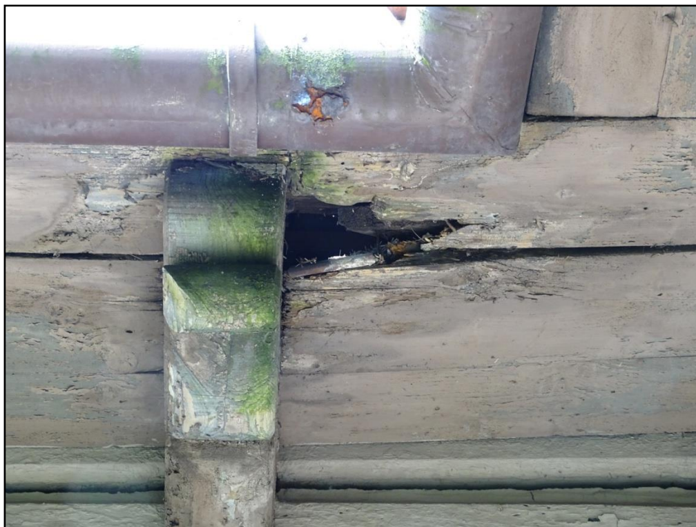
Fot.[8] Wygląd okapu dachu elewacji południowej budynku. Destrukcja deski podokapowej wywołana obecnością grzybów domowych. Fot. autor.
