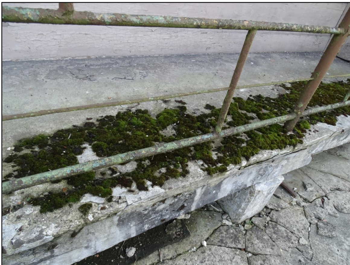
Fot.[10] Betonowy spocznik przed wejściem głównym porośnięty mchami. Fot. autor.
