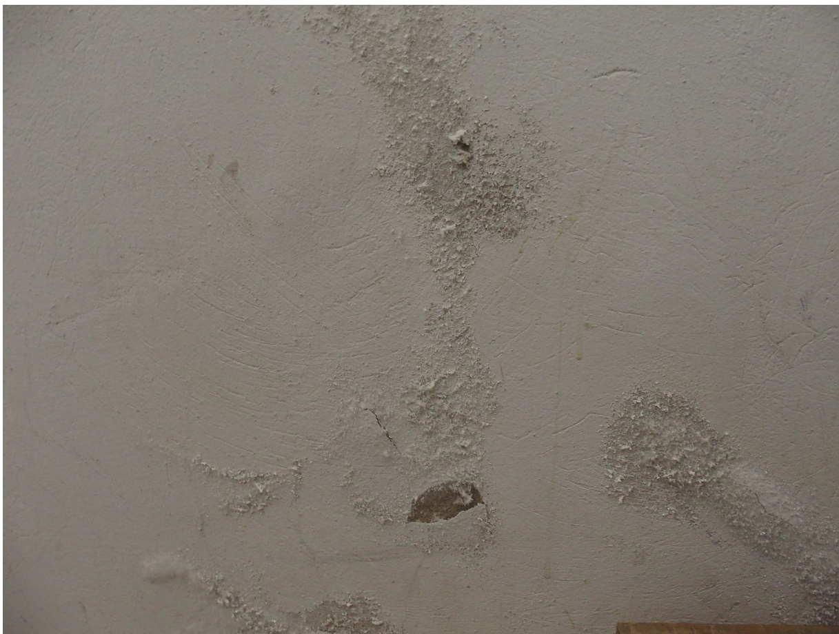
Zawilgocone tynki w piwnicy
