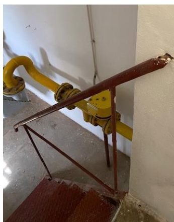
Zawór gazu MAG, usytuowany w pomieszczeniu sądu – zostanie przeniesiony na zewnątrz do skrzynki przyłączeniowej na ścianie zewnętrznej
