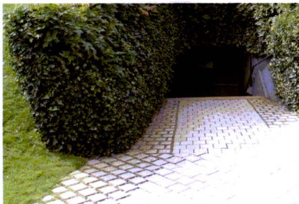
Ryc. 19. Zwiększanie odstępów pomiędzy kostkami w strefach skrajni ciągów komunikacyjnych jest sposobem na zwiększanie przepuszczalności nawierzchni. Fot. Ł. Dworniczak.
