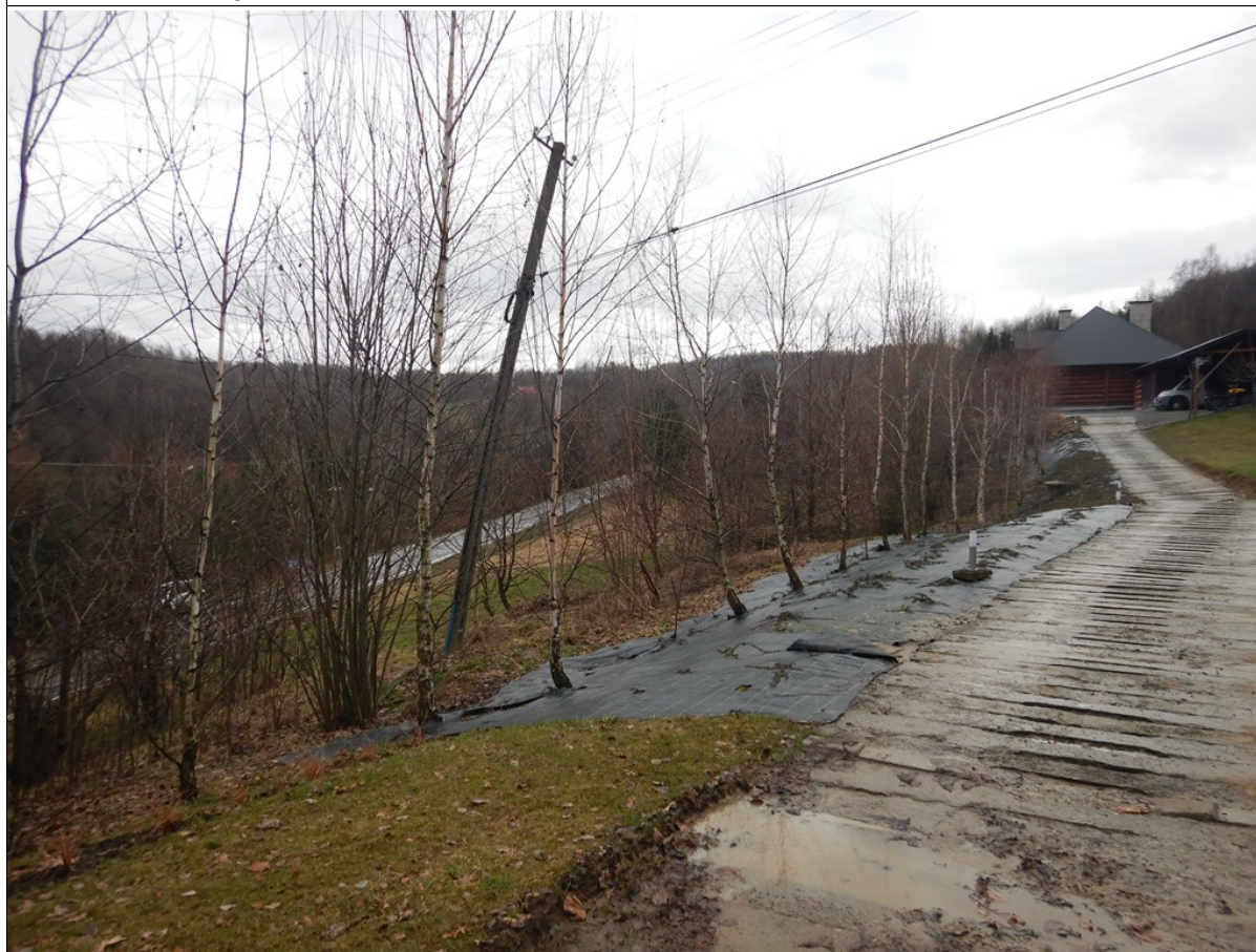
Uszkodzona linia elektryczna w środkowej części osuwiska
