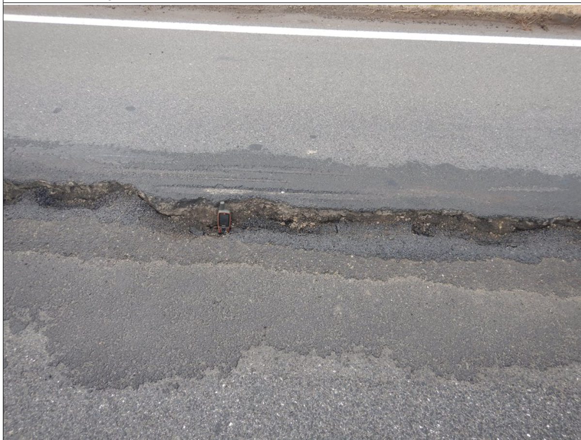
Uskok na drodze, widoczne kilkuetapowe wypełnieni szczelin
