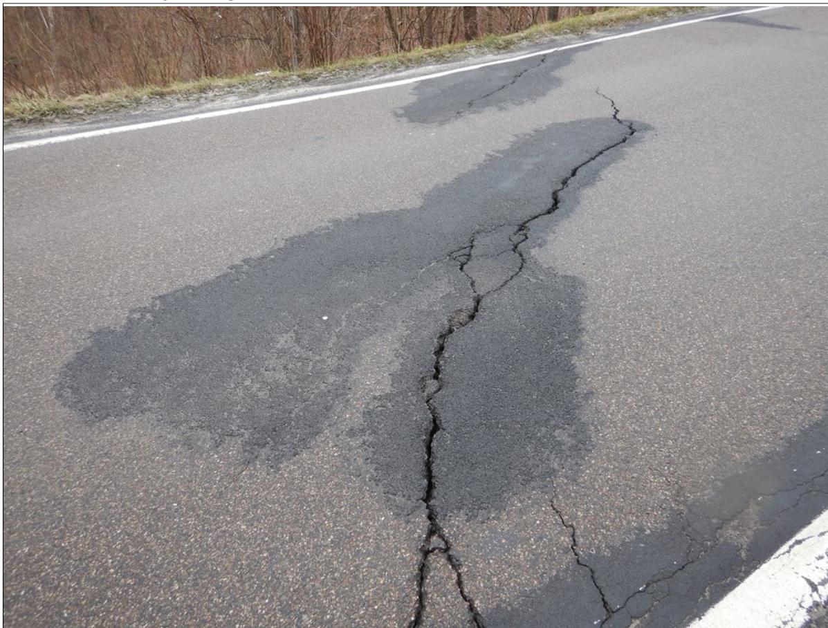
Pęknięcia w nawierzchni w południowej części osuwiska
