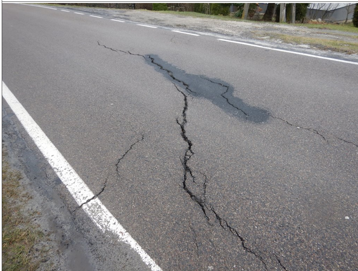
Pęknięcia w nawierzchni w północnej części osuwiska
