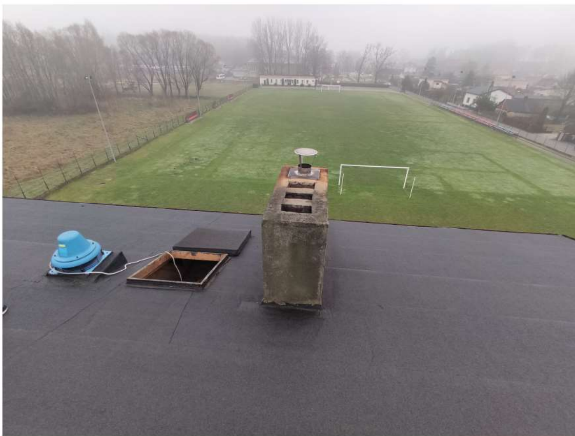
Fot. 7 Komin, wyłaz i wentylator wywiewny (na połaci południowej)
