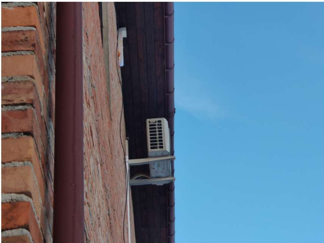
Fot. 18 jednostka zewnętrzna klimatyzacji kuchni – elewacja południowa
