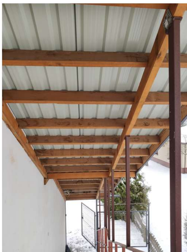
Fot. 16 Konstrukcja zadaszenia nad schodami zewnętrznymi
