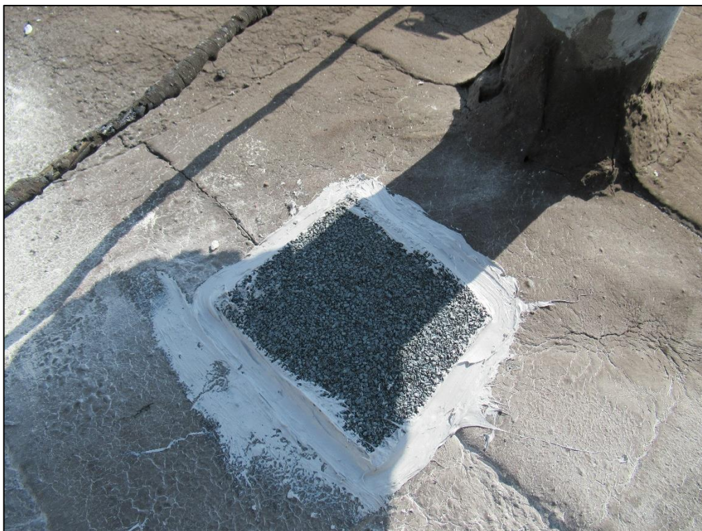
Zdjęcie nr 12. Zabezpieczona odkrywka warstwy wyrównawczej na dachu z papy bitumicznej.
