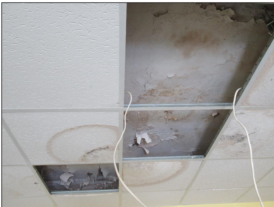
Zdjęcie nr 8. Otynkowany prefabrykowany strop gęstożebrowy belkowo-pustakowy typu DZ-3. Wysuszone zacieki na tynku stropu w przestrzeni nad okładziną z płyt kasetonowych gk
