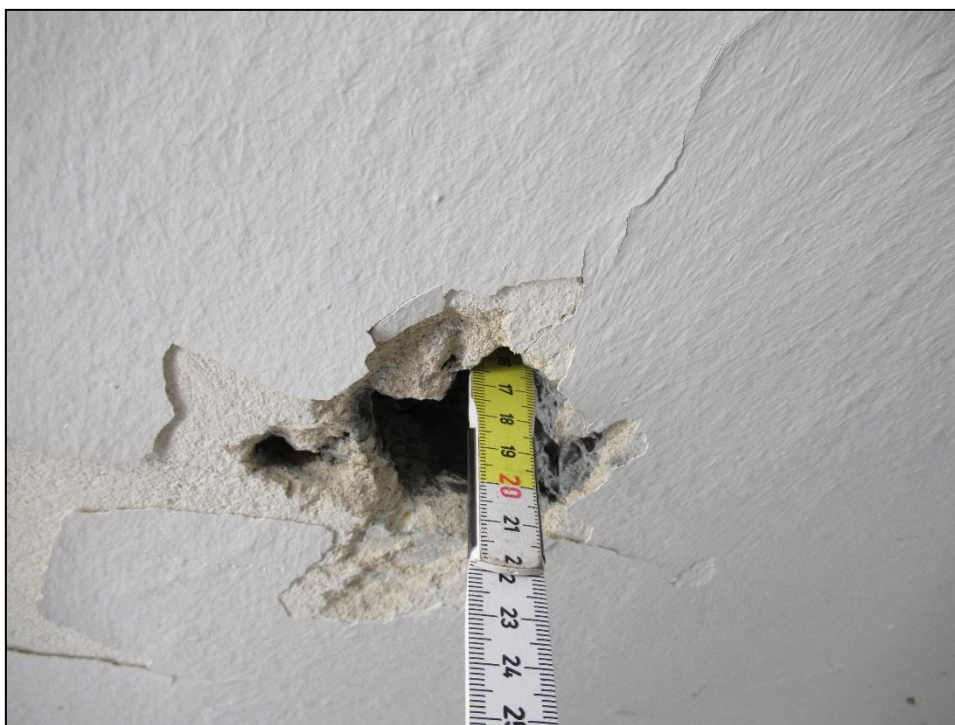
Zdjęcie nr 7. Otynkowany prefabrykowany strop gęstożebrowy belkowo-pustakowy typu DZ-3. Odkrywka w miejscu pustaka, wysokość pustaka z tynkiem 20 cm.
