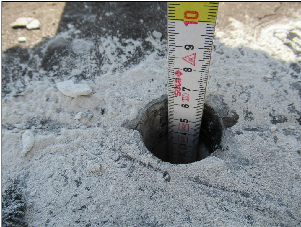
Zdjęcie nr 10. Odkrywka warstwy wyrównawczej na dachu z papy bitumicznej.
