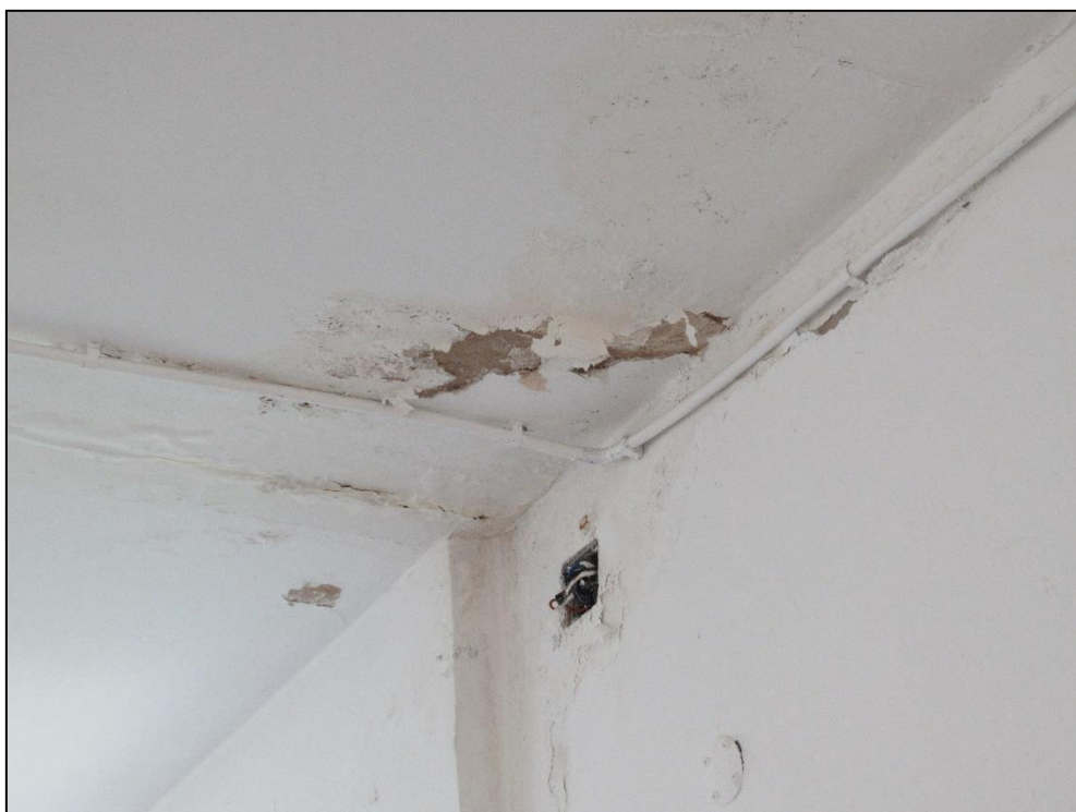
Zdjęcie nr 9. Otynkowany prefabrykowany strop gęstożebrowy belkowo-pustakowy typu DZ-3. Wysuszone zacieki na tynku stropu, złuszczone malatura.
