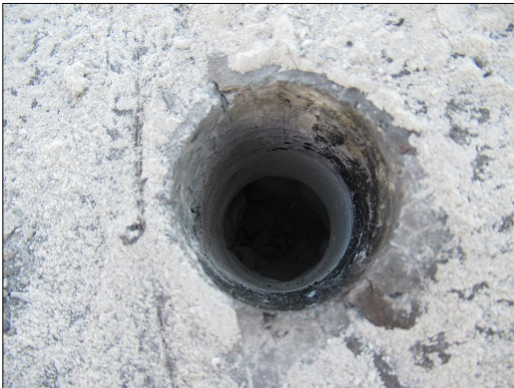
Zdjęcie nr 11. Odkrywka warstwy wyrównawczej na dachu z papy bitumicznej. W odkrywce nie występuje izolacja termiczna, suche zwierciny z płyty betonowej.
