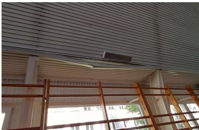
Rys. 3 – narożniki ościeży okiennej do wymiany.
