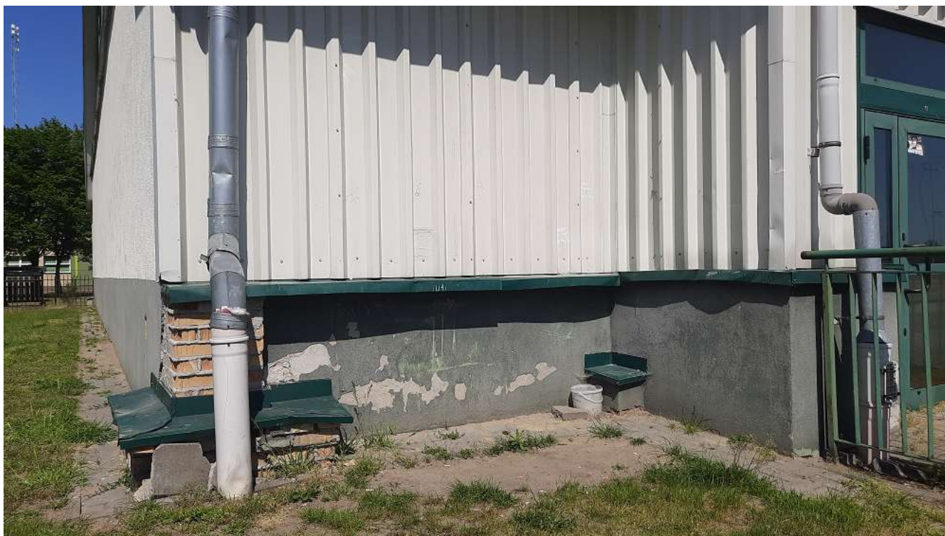
Rys. 6 Widoczna na zdjęciu blacharka do wymiany.
