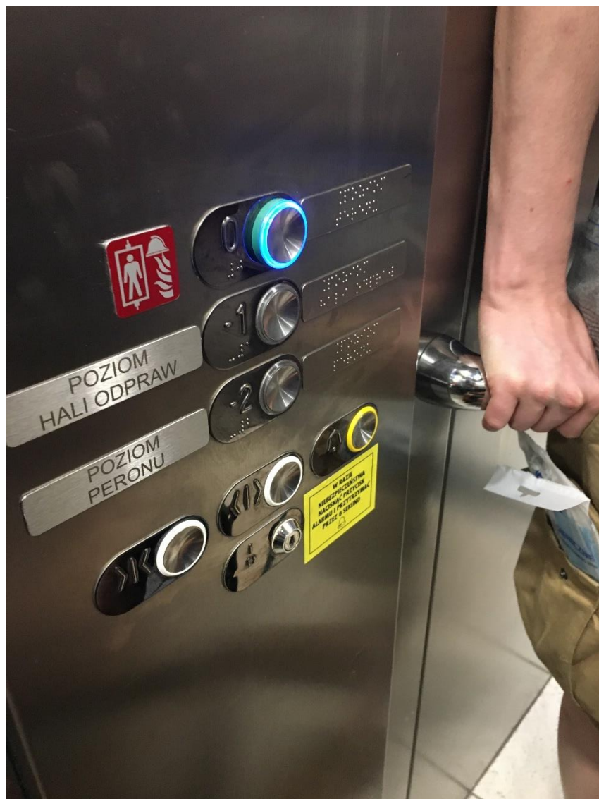
Rysunek 21. Winda na stacji - oznaczenia wypukłe i w alfabecie Braille'a
