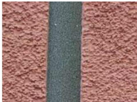
Widok szczeliny dylatacyjnej wypełnionej taśmą rozprężną
