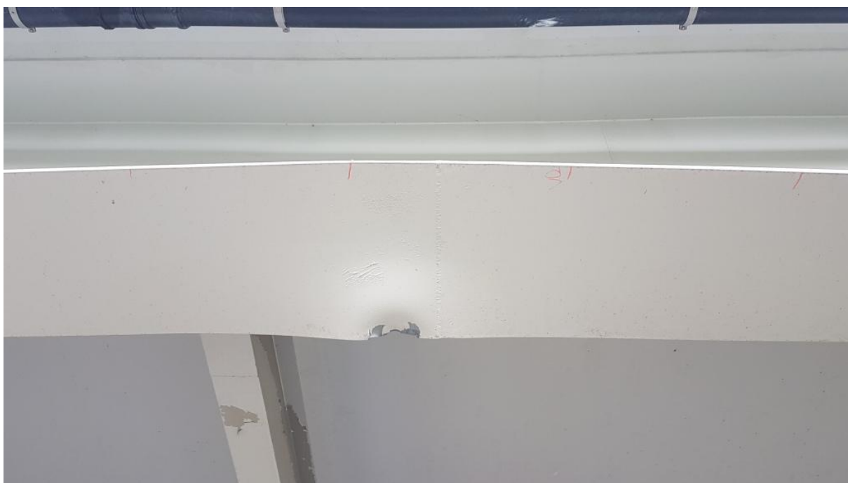
Fot. 3. Widok znacznych odkształceń geometrycznych (deplanacja, przemieszczenia pionowe) pasa dolnego dźwigara prawostronnego.
