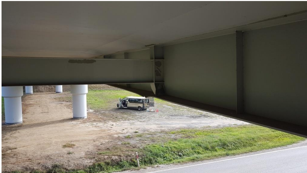
Fot. 6. Widok na spód żelbetowej płyty pomostu. Widoczne drobne odpryski betonu płyty na styku z pasem górnym blachownicy prawostronnej w strefie poprzecznicy pośredniej.
