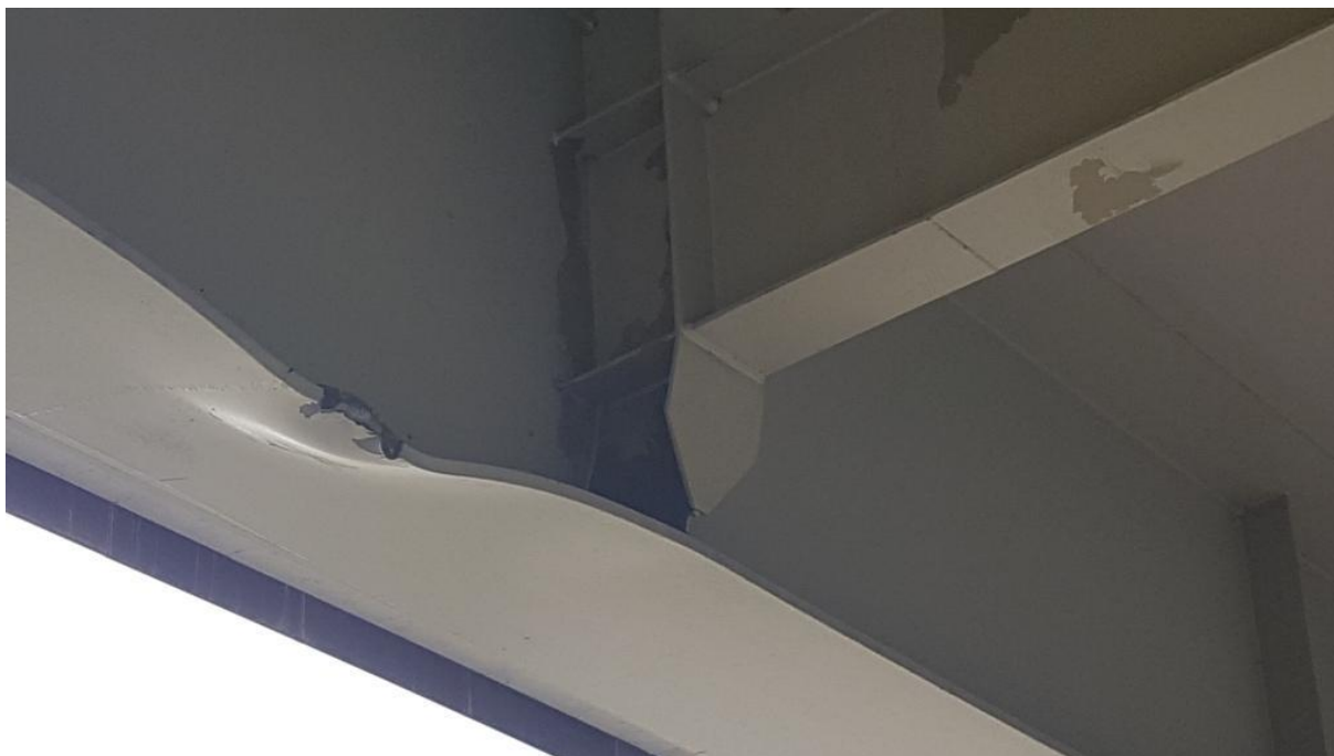
Fot. 4. Widok na uszkodzenie pasa prawostronnego dźwigara od strony środka przęsła – Jaślan (Baranowa Sandomierskiego). Widoczna deformacja żebra poprzecznicę pośredniej (w strefie poniżej poprzecznic), niewidoczna, (za blachą policzkową) – odspojona spoina czołowa żebra na odcinku ok. 8 cm.
