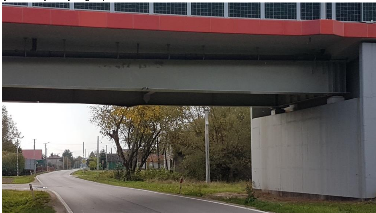
Fot. 1. Widok dźwigara lewostronnego od str. m. Jaślany (Baranów Sandomierski) 1 – szego przęsła mostu – nieznaczne uszkodzenie pasa dolnego lewostronnej blachownicy (kierunek uderzenia). Widoczne oparcie przęsła na ciosach i łożyskach przyczółka (podpora nr 1) – bez jakichkolwiek przemieszczeń i zmiany położenia pomostu.
