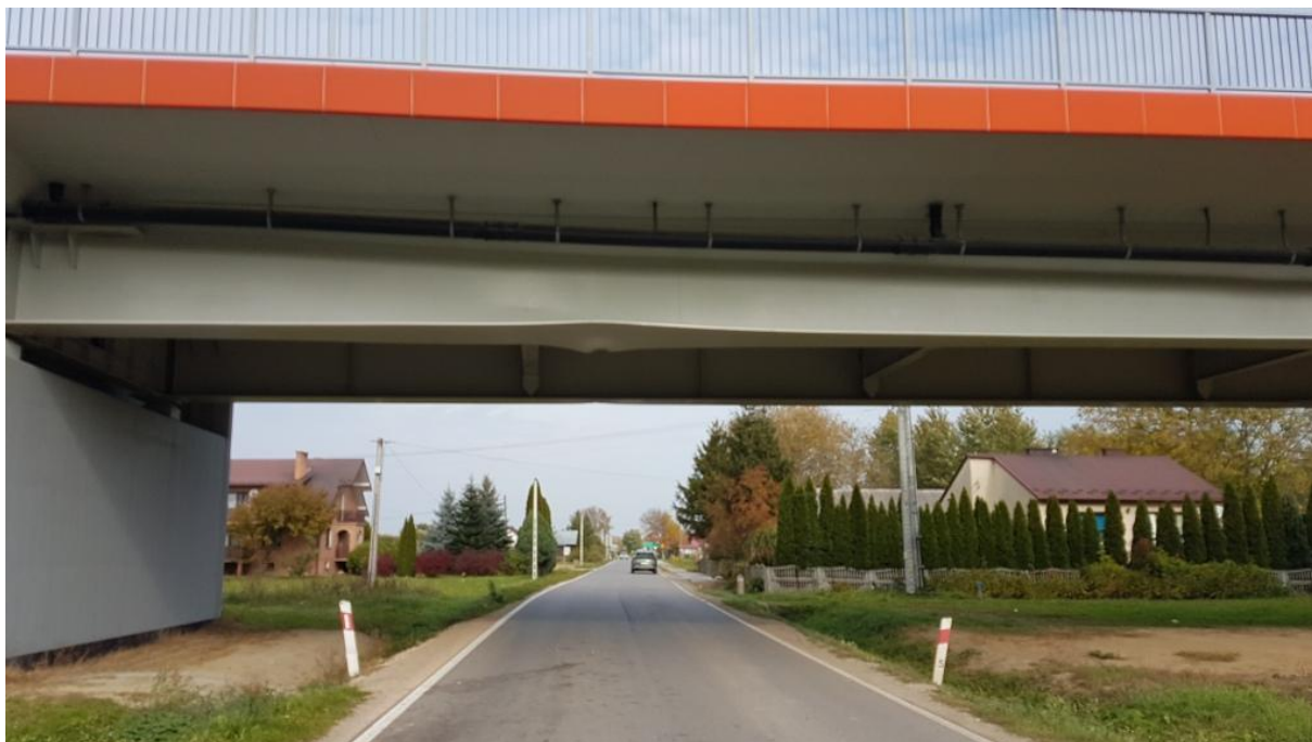
Fot. 2. Widok dźwigara prawostronnego od str. m. Szczucin – dość znaczne odkształcenia pasa dolnego i środka prawostronnej blachownicy (widok przeciwny do kierunku uderzenia).
