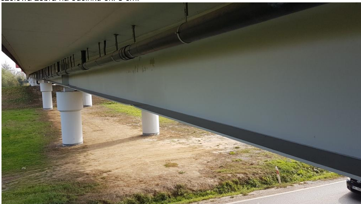
Fot. 5. Widok niewielkich odkształceń geometrycznych (wybrzuszenie – przemieszczenie pionowe) pasa dolnego dźwigara lewostronnego od str. m. Jaślany.
