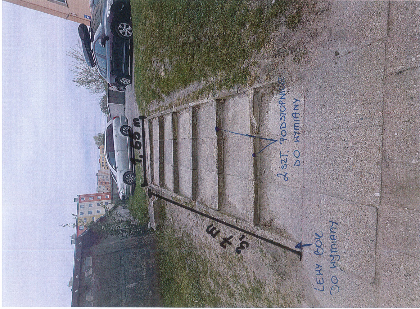
WODNIEŚĆ KAFLE NA STOPNIACACH - ZAPADNIĘCIE
