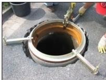
po 20 minutach zakładamy pierścień pokrywy
