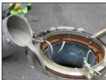
... zalewamy zewnętrzne pęknięcia
