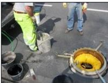
po 30 minutach zalewamy specjalną zaprawą
