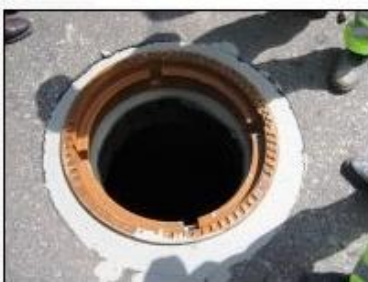
po 35 minutach usuwamy szalunek rurowy
