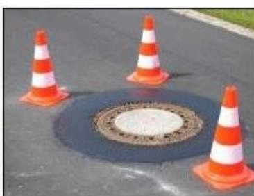
po 45 minutach wyrównujemy zaprawą do naprawy asfaltu
