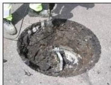
... naprawiamy powierzchnię nośną
