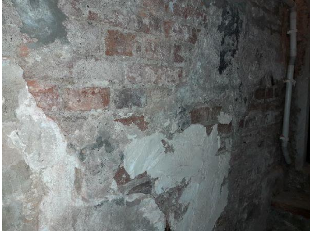
Degradacja wypraw tynkarskich i widoczne zasolenia na ścianach wewnętrznych
