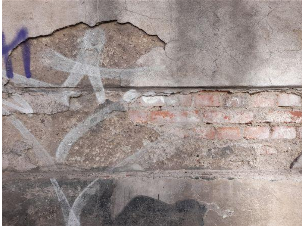
Degradacja wypraw tynkarskich i widoczne zasolenia na ścianach wewnętrznych
