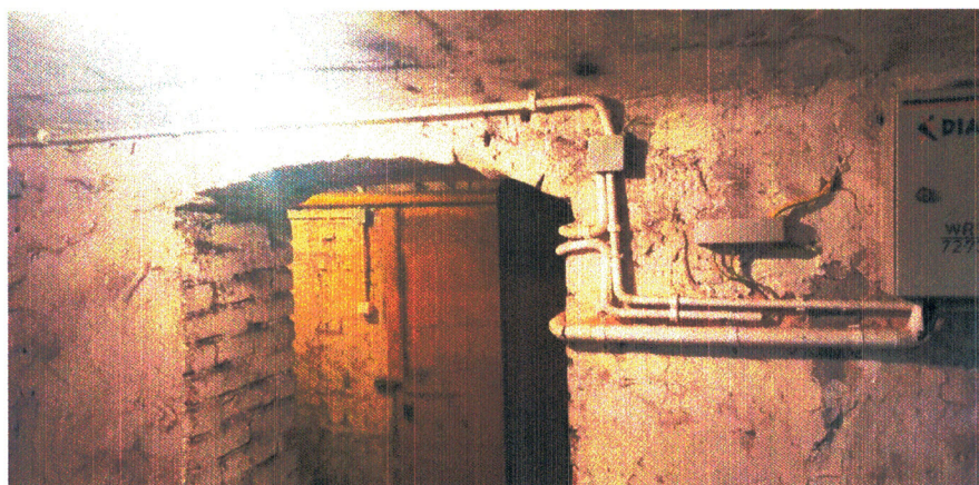
Fot. 8: Nadproże łukowe w ścianie piwnicznej
