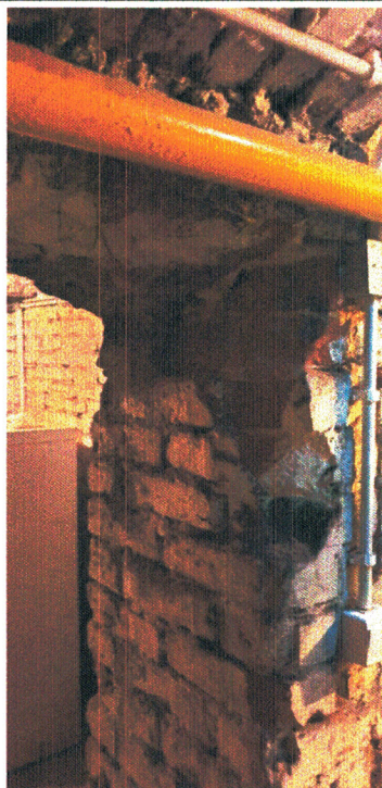
Fot. 19: Nadproże piwniczne – widoczne ubytki
