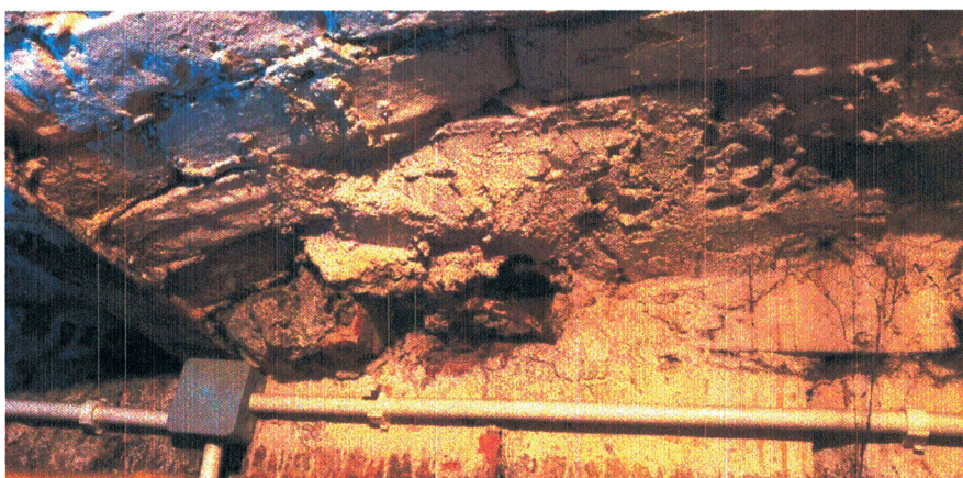
Fot. 10: Sklepienie odcinkowe
