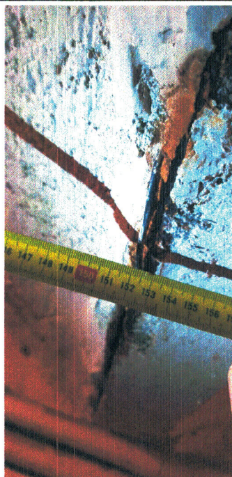
Fot. 13: Rozstaw belek stropowych 1200 - 152cm
