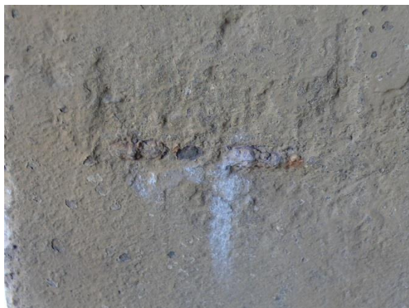
Fot. 12 Odkryte zbrojenie słupa 2B
