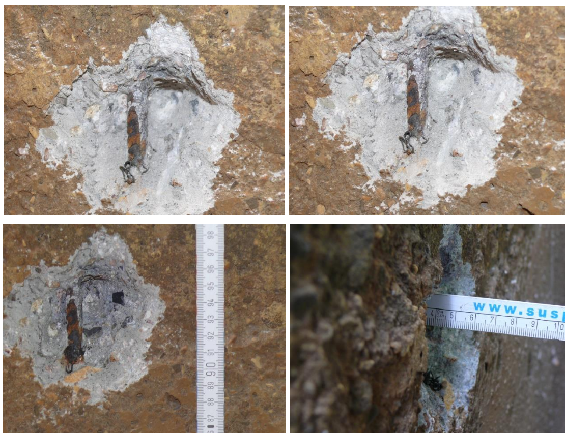
Fot. 23 Zbrojenie konstrukcyjne ścian
