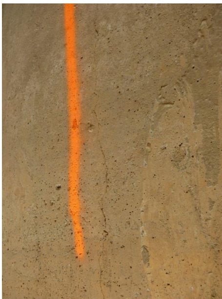
Fot. 8 Rysy na ścianie 5 misy
