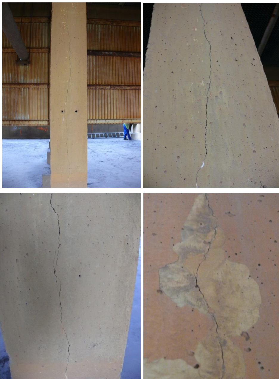
Fot. 15 Rysy na konstrukcji słupa 2E
