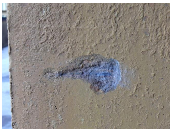
Fot. 13 Odkryte zbrojenie słupa 4B
