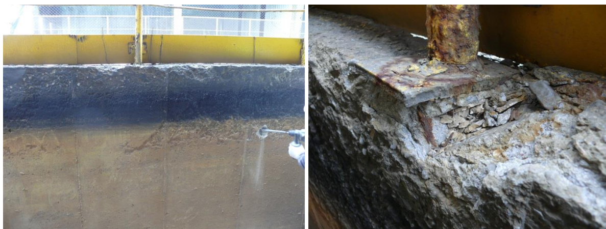
Fot. 3 Wżery i wykruszenia w górnej części ściany spowodowane korozją mrozową
