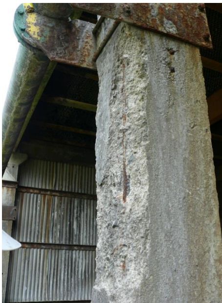
Fot. 11 Wżery korozyjne oraz odkryte zbrojenie słupa 2A
