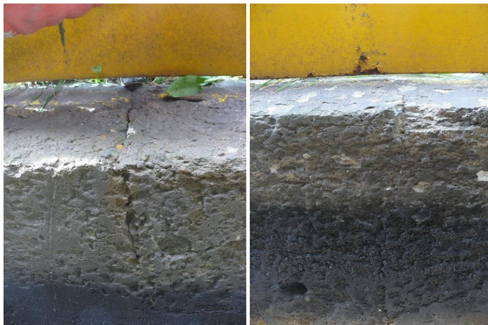
Fot. 2 Rysy na ścianie A misy
