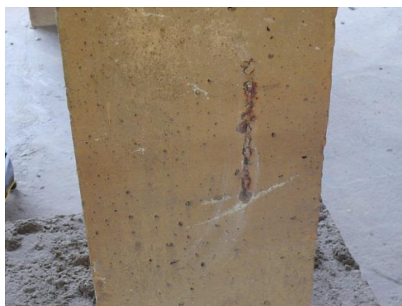
Fot. 14 Odkryte zbrojenie słupa 3D
