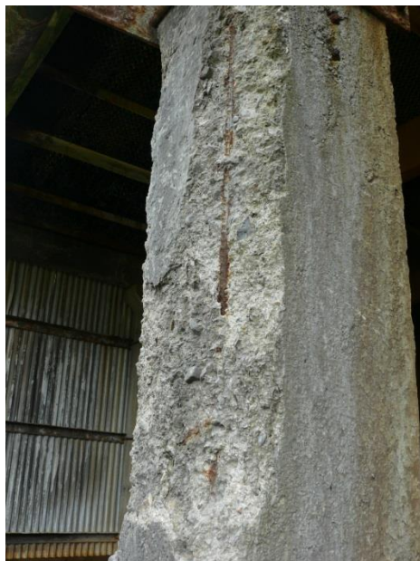
Fot. 11 Wżery korozyjne oraz odkryte zbrojenie słupa 2A
