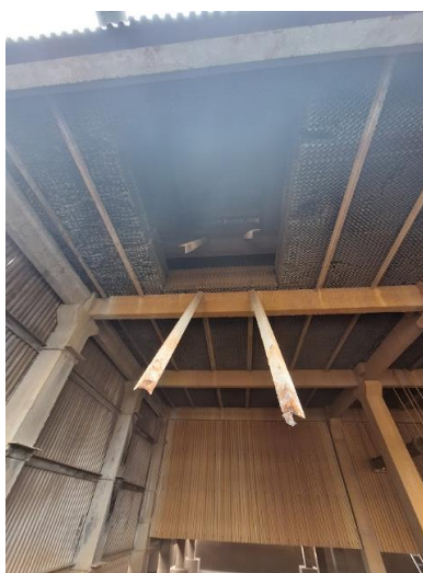
Rysunek 8. Odspojenia konstrukcji wsporczej wraz z ubytkiem segmentów zraszalnika celki WPR3 na obu poziomach.
