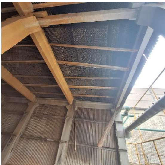
Rysunek 9. Odspojenia konstrukcji wsporczej zraszalnika celki WPR3.
