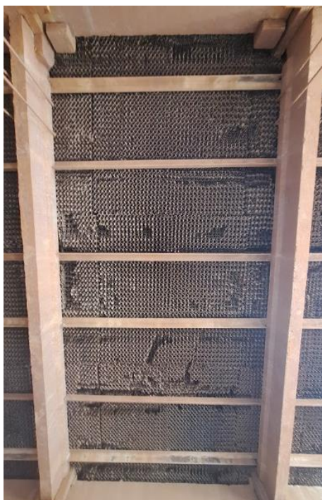
Rysunek 6. Fragmentaryczne ubytki segmentów zraszalnika celki WPR4.
