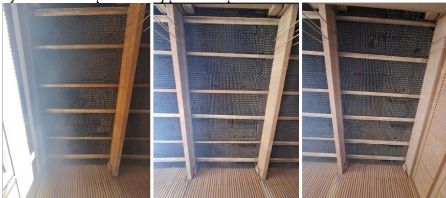
Rysunek 5. Widok z poziomu basenu chłodni na dolną warstwę zraszalnika.
