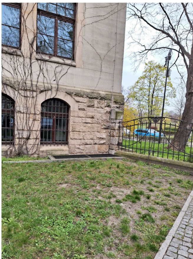
zdj. nr 8 - zabytkowe ogrodzenie przy budynku E1, planowana trasa przechodzi przez fundament ogrodzenia wykonany z cegły pełnej
