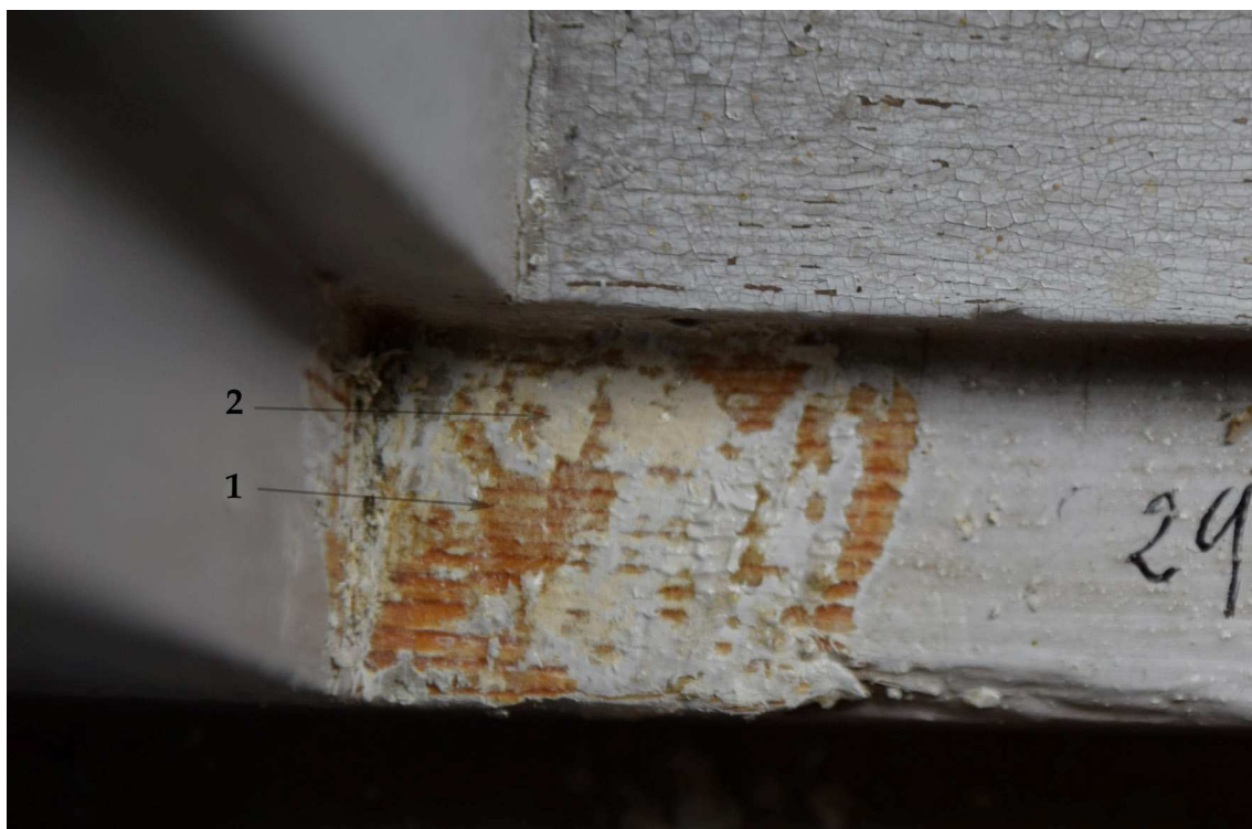
13. Punkt 29. Rama okna nr VIII. Widoczne warstwy pierwszej fazy chronologicznej: 1 – drewno, 2. Warstwa malarska kremowa.
