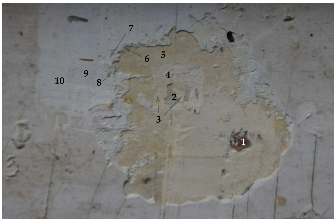
15. Punkt 37. Parapet okna nr X. Widoczna stratygrafia warstw: 1- drewno, 2 - warstwa kremowa pierwotna, 3 – warstwa jasnougrowa, 4-10 – warstwy białe.
