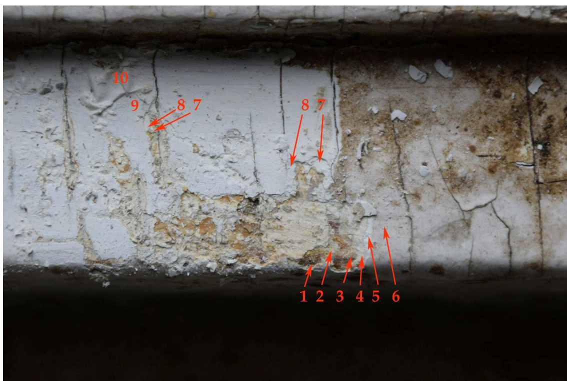
14. Punkt 36. Ościeżnica okna nr X. Widoczna stratygrafia warstw: 1- drewno, 2 - warstwa kremowa pierwotna, 3 – warstwa jasnougrowa, 4-10 – warstwy białe.
