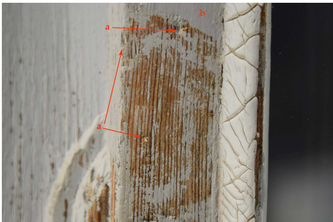
2. Punkt 1 - rama okna I (lewa, górna, zewnętrzna, przy listwie przytykowej). Widoczny stan zachowania: a – reliktu pierwotnej (pierwszej warstwy malarskiej), b – warstwa ostatniego przemalowania - jasnoszara.
