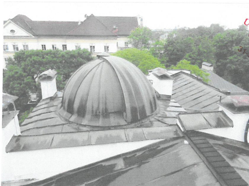
Fot. 5 - Dach - widok ogólny – ruchoma kopuła pokrycie z blachy miedzianej
