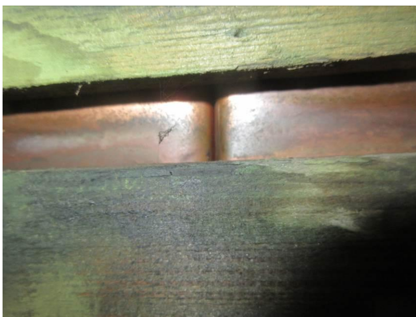
Fot. 6 - Dach - deskowanie i pokrycie z blachy miedzianej
