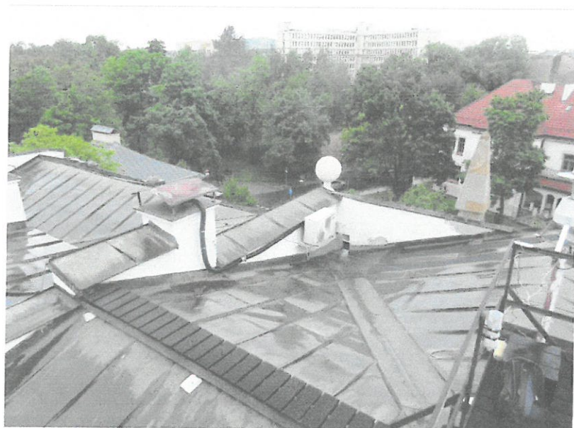
Fot. 4 - Dach - widok ogólny – pokrycie z blachy miedzianej
