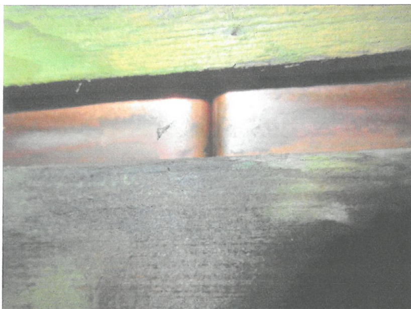
Fot. 6 - Dach - deskowanie i pokrycie z blachy miedzianej
