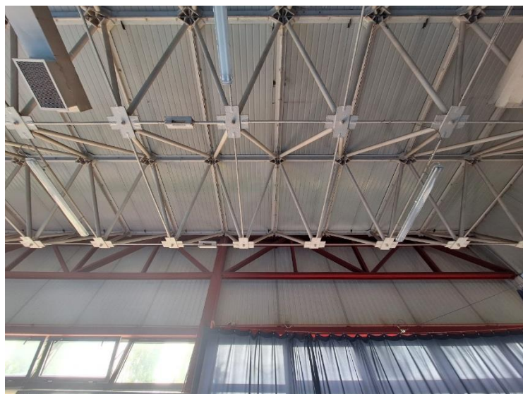
Rys. 6 Widok przekrycia strukturą prętową w hali 2
