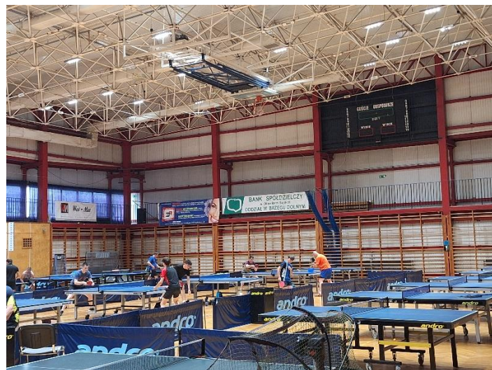
Rys. 12 Podparcie obwodowe kratownic na stalowych słupach.
