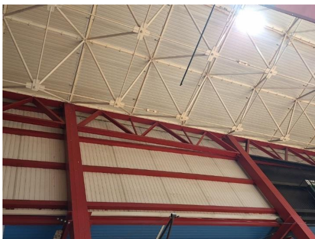
Rys. 12 Podparcie dachowej struktury prętowej na kratownicach wspartych na stalowych słupach.
