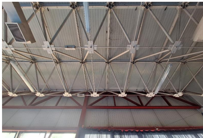
Rys. 22 Podparcie obwodowe kratownic na stalowych słupach.
