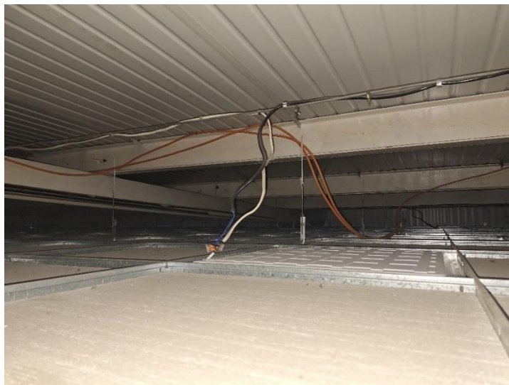
Rys. 34 Układ belek nośnych w stropie nad pomieszczeniami socjalnymi.
