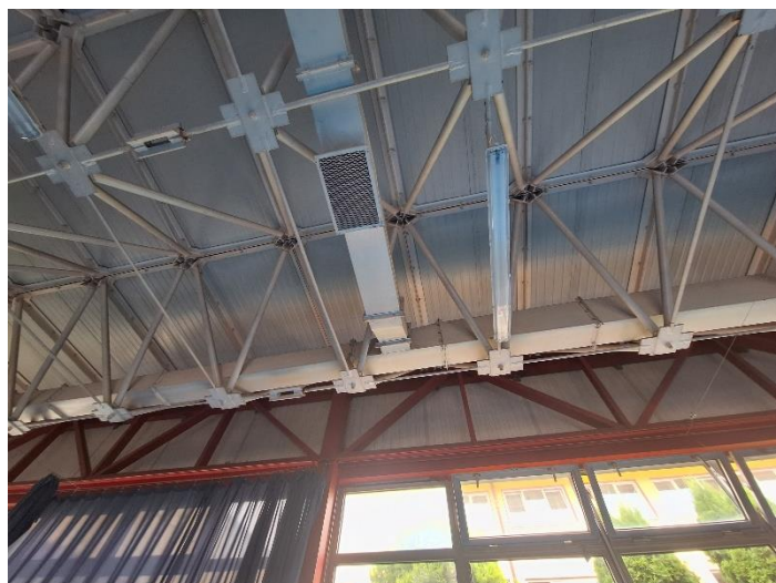
Rys. 19 Podparcie kratownicy na stalowych słupach
