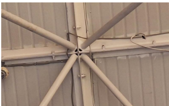
Rys. 10 Węzeł górny połączenie krzyżulców i prętów pasa górnego przestrzennej kratownicy.
