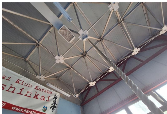
Rys. 23 Podparcie obwodowe stalowej struktury przestrzennej na kratownicach i na ścianach murowanych.
