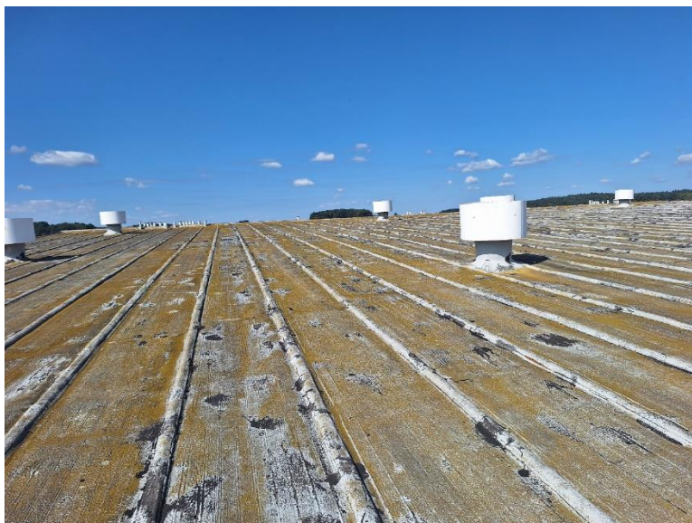
Rys. 9 Pokrycie płyt dachowych, nad halę sportową nr 1, pianką poliuretanową z cienką wierzchnią warstwą przeciwwodną bitumiczną.
