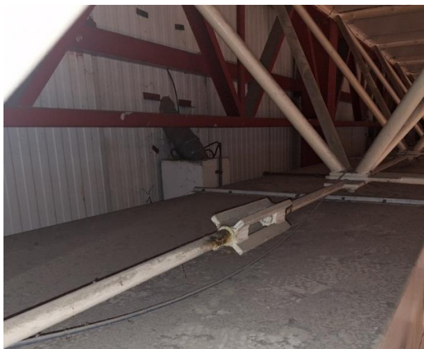
Rys. 17 Śruba rzymska łącząca węzły dolne pręty struktury przestrzennej.
