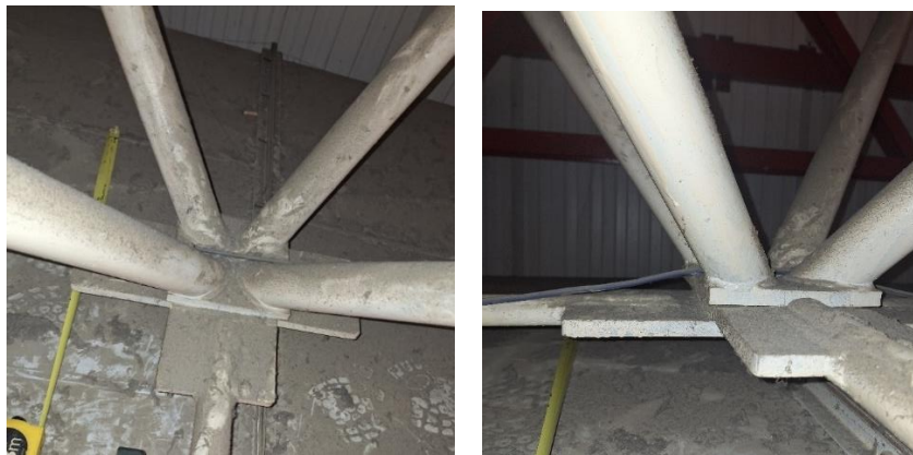
Rys. 16 Węzeł dolny w przestrzennej strukturze zadaszenia hali 1
