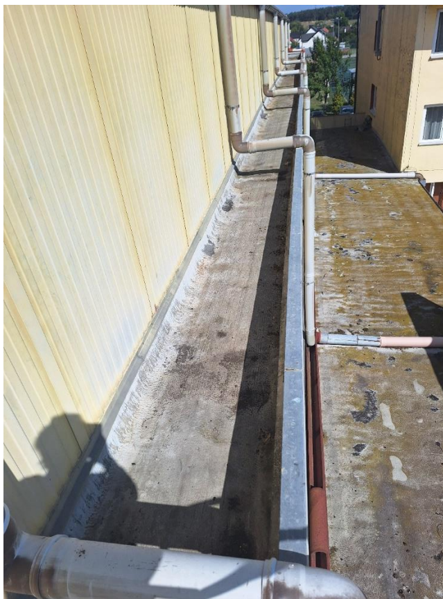
Rys. 8 Pokrycie płyt dachowych z wierzchnią warstwą przeciwwodną bitumiczną nad korytarzem w hali sportowej nr 1 od strony elewacji południowej.
