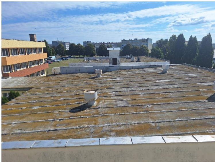
Rys. 7 Pokrycie płyt dachowych, nad halę sportową nr 2, pianką poliuretanową z cienką wierzchnią warstwą przeciwwodną bitumiczną. Widok część hotelową obiektu przy ul. Wilczej 8
