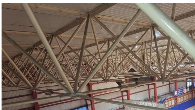
Rys. 13 „Piramidki” prętowe tworzące przestrzenną strukturę zadaszenia hali 1
