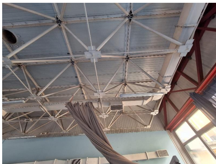
Rys. 24 Podparcie obwodowe stalowej struktury przestrzennej na kratownicach
