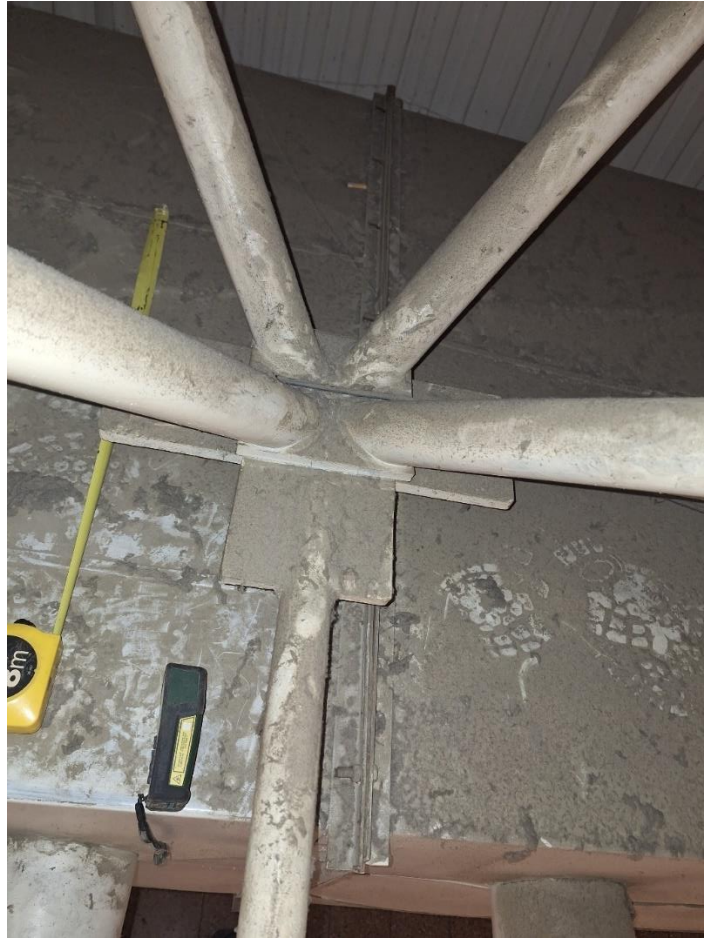
Rys. 11 Węzeł dolny połączenie krzyżulców i prętów pasa dolnego przestrzennej kratownicy.
