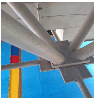
Rys. 25 Węzeł dolny w przestrzennej strukturze zadaszenia hali 2
