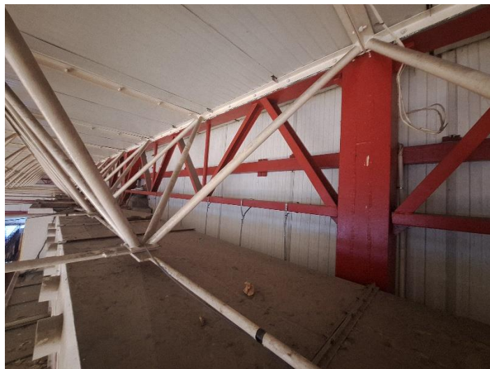
Hala 2 Rys. 16 Podparcie obwodowe stalowej struktury przestrzennej na kratownicach
