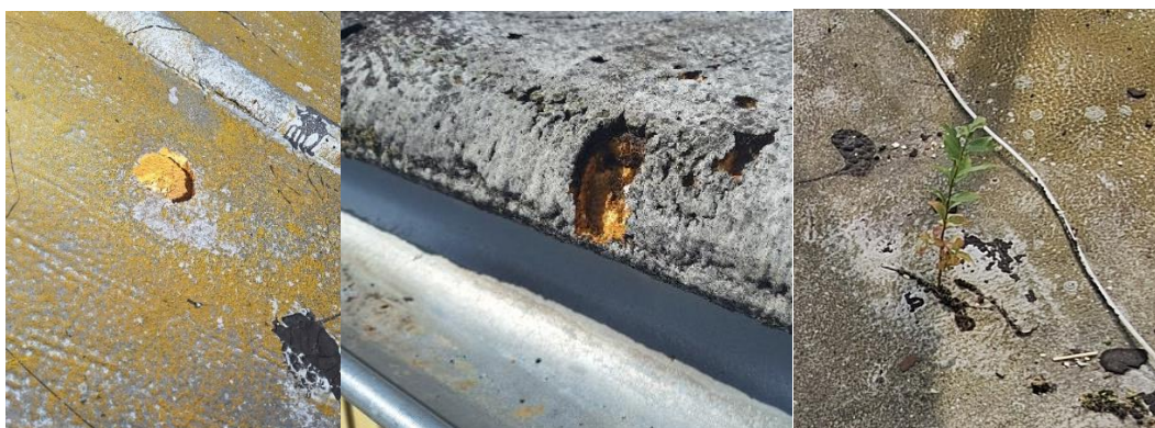
Rys. 11 Typowe ubytki w piance poliuretanowej na powierzchni zadaszenia nad salą spustową nr 1. Dach pokryty mchami, pleśniami i małymi krzaczkami.
