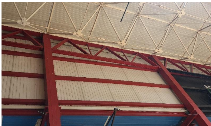
Rys.13 Podparcie obwodowe kratownic na stalowych słupach.
