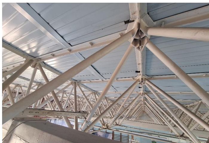
Rys. 20 Węzeł górny połączenie krzyżulców i prętów pasa górnego przestrzennej kratownicy.
