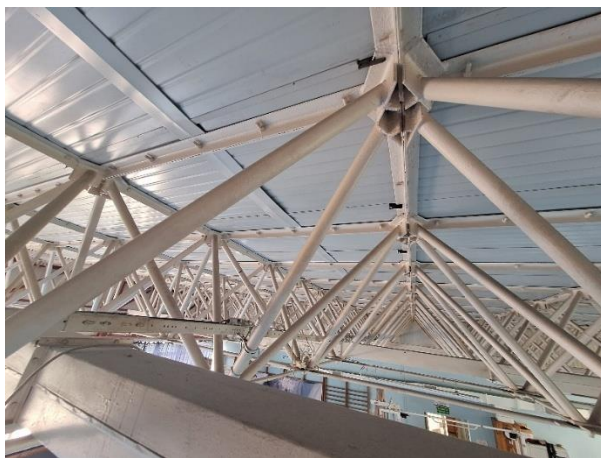
Rys. 24 Węzeł górny w przestrzennej strukturze zadaszenia hali 2
