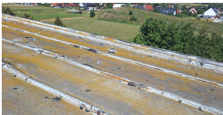
Rys. 10 Typowe ubytki w piance poliuretanowej na powierzchni zadaszenia nad salą spustową nr 1.
