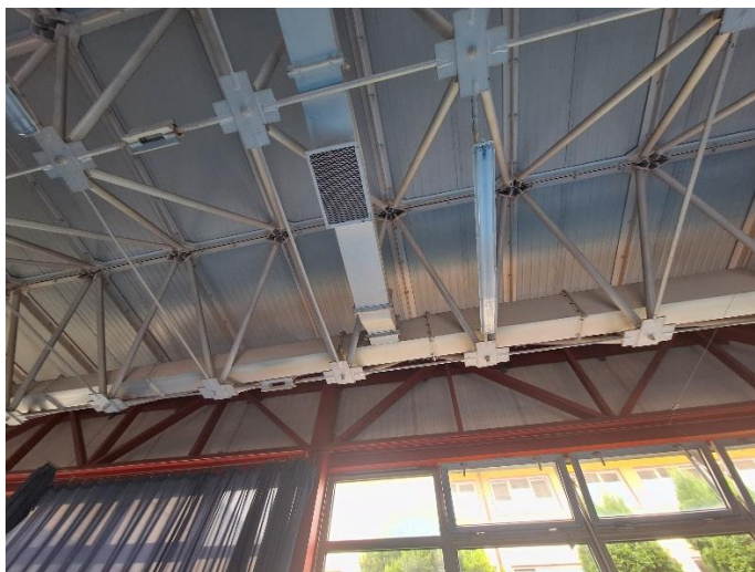
Rys. 26 Oparcie struktury przestrzennej prętowej na stalowej kratownicy i stalowych słupach.
