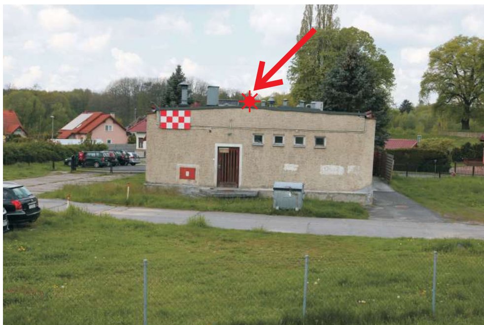
Fotografia nr 6 - Oznakowanie przeszkodowe budynku Zakładu Pogrzebowego oznakowanie nocne - lampa przeszkodowa typu A
