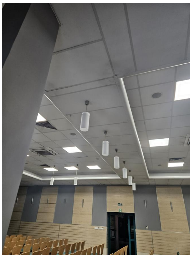
Fot.18. Sala konferencyjna- panele sufitowe do wymiany
