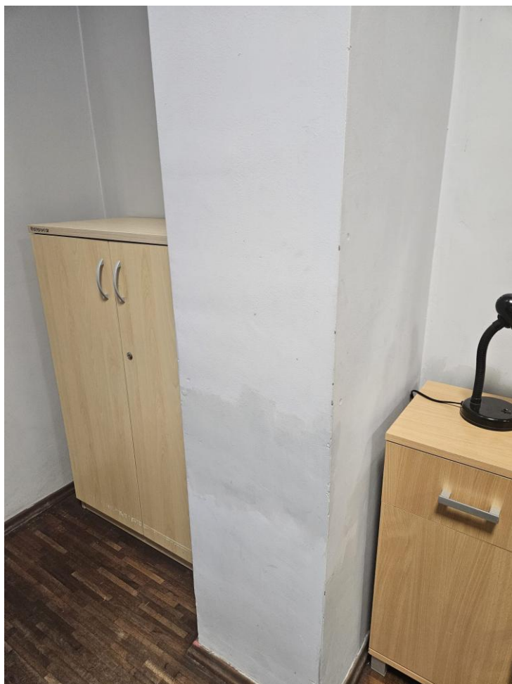
Fot.7. Sala 35 (zaplecze Sali konferencyjnej)- uszkodzenia ścian
