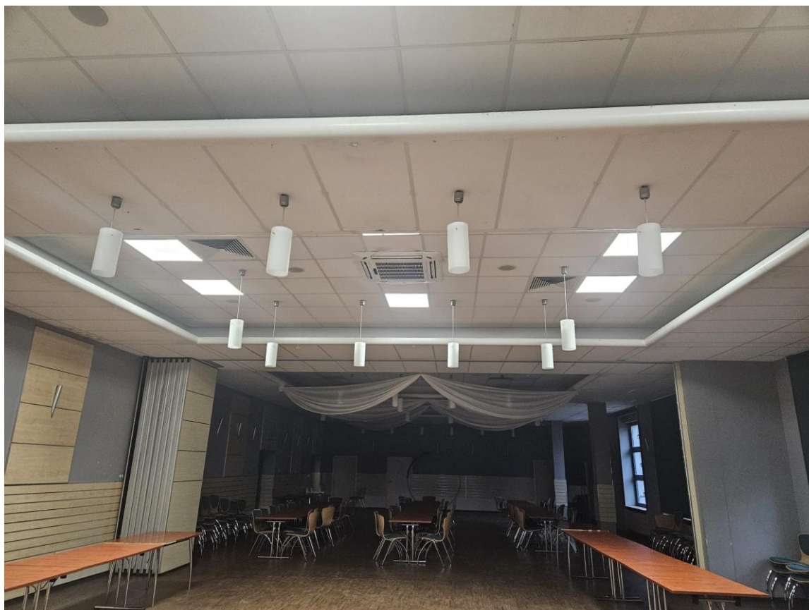
Fot.17. Sala konferencyjna- panele sufitowe do wymiany
