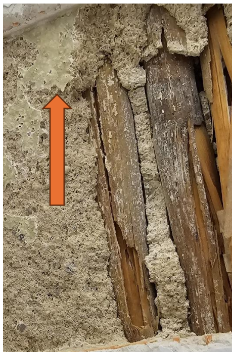
Sufit, pod warstwą wtórnego wytynkowania widoczna jasna warstwa malarska.
