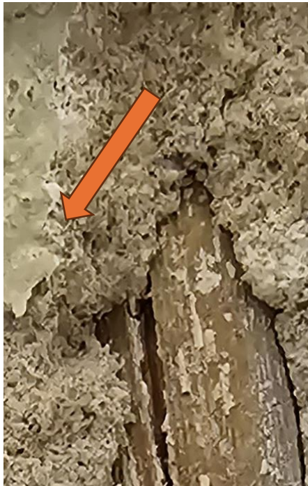
Sufit, pod warstwą wtórnego wytynkowania widoczna jasna warstwa malarska.
