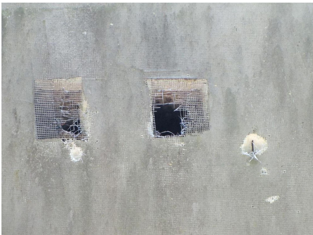
Fot. 3. Zbliżenie na niezabezpieczone otwory wentylacyjne w zachodniej elewacji sali gimnastycznej (fot. B. Pacuk).
