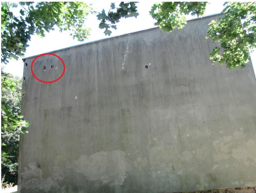
Fot. 2. Budynek sali gimnastycznej – widok od strony zachodniej. W kółku zaznaczono niezabezpieczone otwory wentylacyjne (fot. B. Pacuk).
