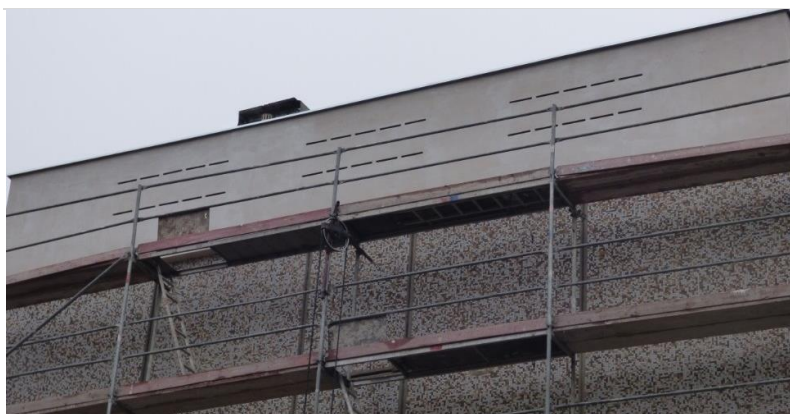
Ryc. 11. Budki podtynkowe dla nietoperzy – przykład ściany bloku z 30 dużymi budkami dla nietoperzy.
