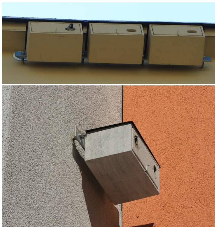
Ryc. 10. Przykładowy sposób zamocowania budek trocinobetonowych do budynku – za pomocą płaskownika i prętów gwintowanych.
