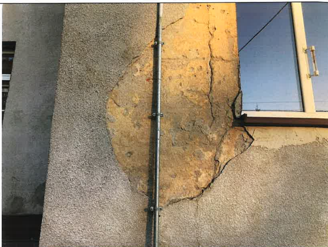
6. Boże; dawny dwór, ob. szkoła podstawowa; elewacja zachodnia (tylna); ryzalit, kondygnacja I. Współczesne wykończenia lica dwiema wyprawami cementowymi; warstwa spodnia z ugrowo-żółtymi powłokami malarskimi; warstwa wierzchnia z „baran-kiem” i jasno-beżową powłoką malarską; spękania, odspojenia, ubytki zapraw.
