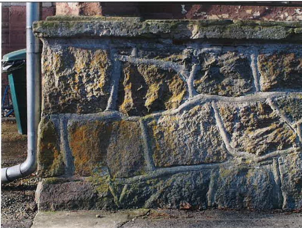
15. Boże; dawny dwór, ob. szkoła podstawowa; elewacja wschodnia (frontowa), przyziemie, ganek. Współczesne uzupełnienia spoinowań cokołu ganka zaprawą cementową; skupiska mikroorganizmów roślinnych; ubytki na krawędziach płyt tarasowych.
