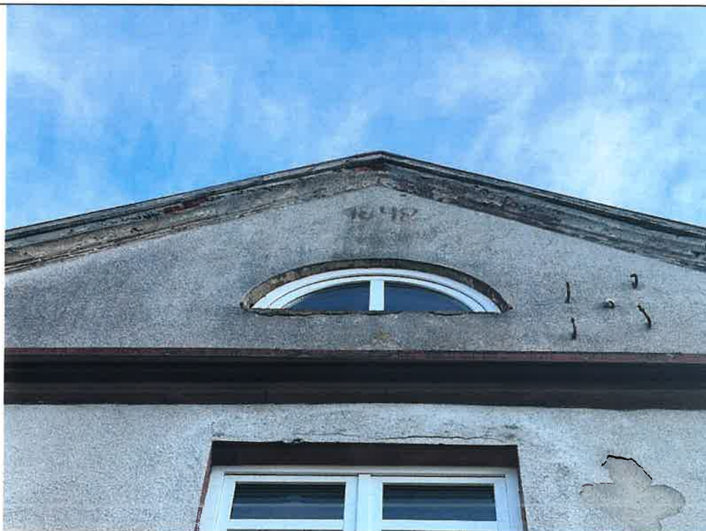
22. Boże; dawny dwór, ob. szkoła podstawowa; elewacja zachodnia (tylna), ryzalit, zwieńczenie. Uszkodzenia wypraw i detalu na skutek zamakania wodą opadową; ciemne zacieki i przebarwienia, ubytki zapraw i powłok malarskich.
