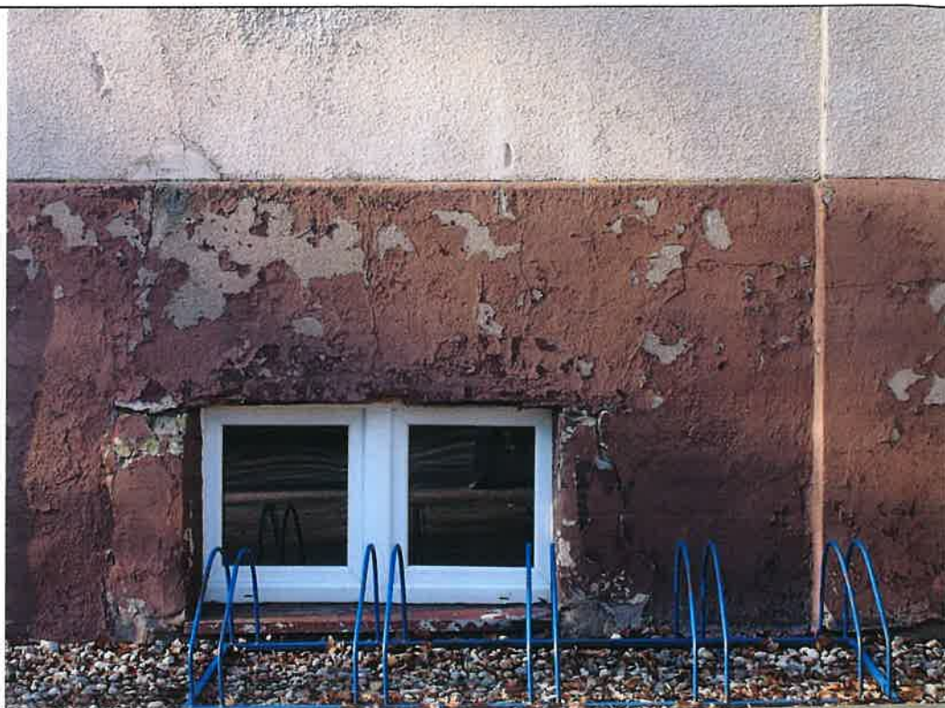
8. Boże; dawny dwór, ob. szkoła podstawowa; elewacja wschodnia (frontowa), segment południowy, przyziemie. Współczesne wykończenie cokołu grubą warstwą zaprawy cementowej z warstwami malarskimi; głębokie spękania i odspojenia, złuszczenia powłok malarskich; stolarka PCV.
