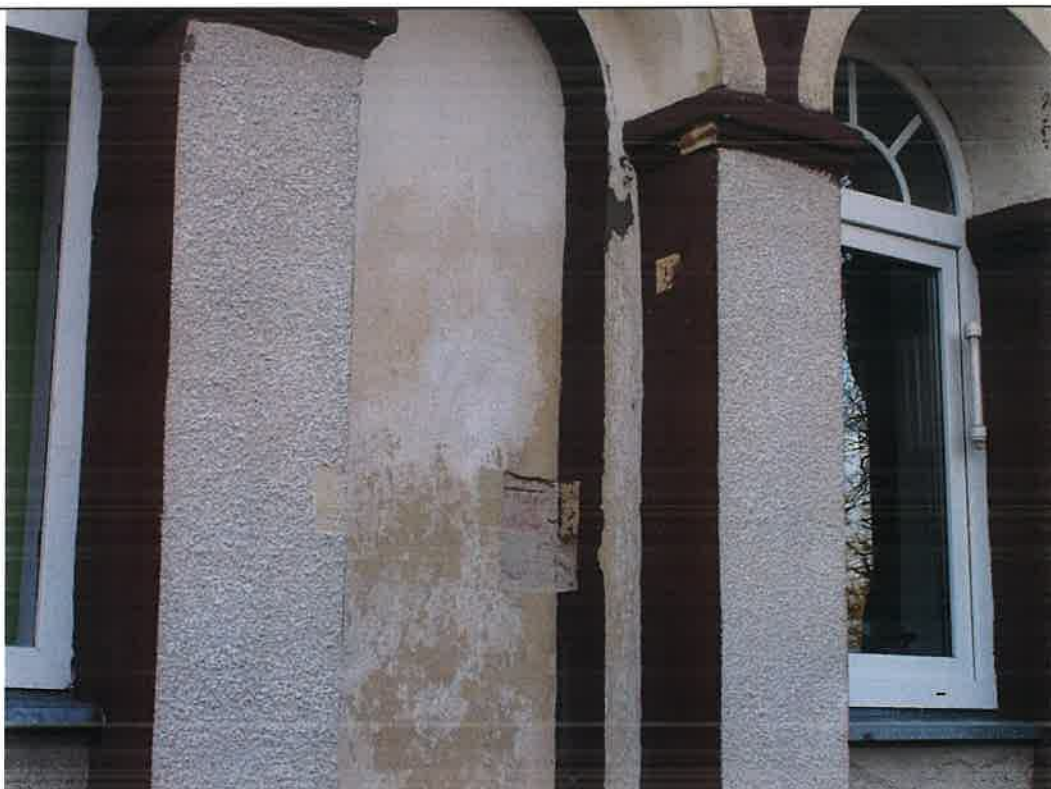
13. Boże; dawny dwór, ob. szkoła podstawowa; elewacja wschodnia (frontowa), pseudoryzalit, kondygnacja II. Oryginalne wyprawy wapienne pokryte współczesnymi warstwami malarskimi, cementową szlichtą i „barankiem”.
