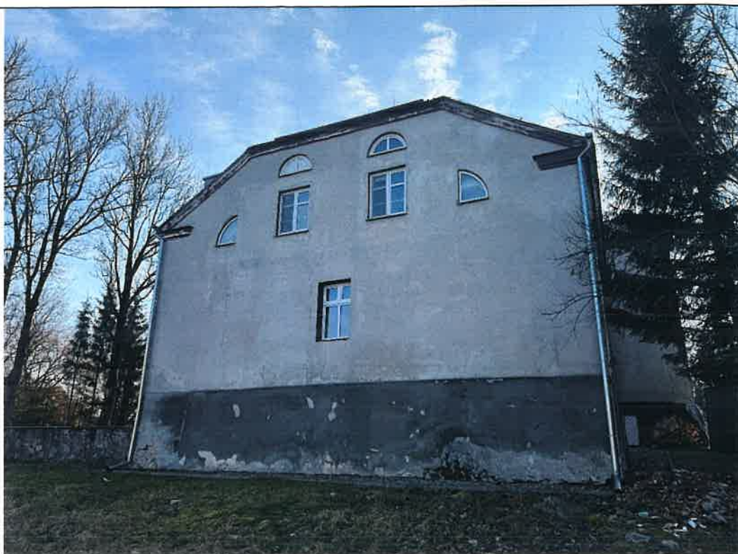
4. Boże; dawny dwór, ob. szkoła podstawowa; elewacja północna (boczna); widok ogólny od strony północno-zachodniej. Wykończenie lica i detali współczesnym tynkiem cementowym; ubytki detalu architektonicznego (opasek okiennych); wtórny otwór okienny kondygnacji I, w miejscu rozebranego łącznika oficyny.
