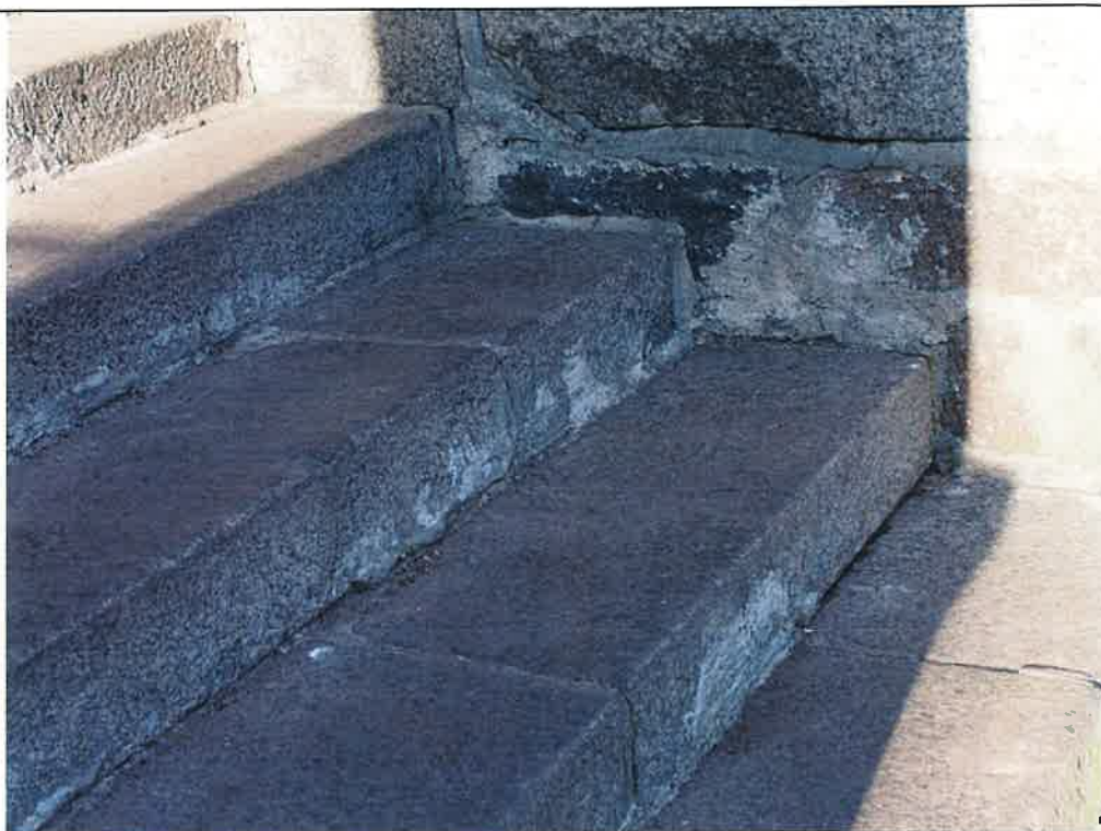
14. Boże; dawny dwór, ob. szkoła podstawowa; elewacja wschodnia (frontowa), przyziemie, ganek. Silne zabrudzenia na elementach schodów; ubytki i prowizoryczne uzupełnienia zaprawą cementową.
