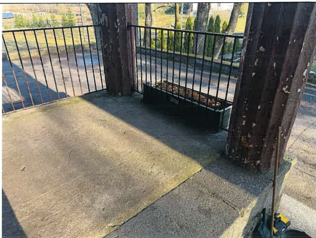
16. Boże; dawny dwór, ob. szkoła podstawowa; elewacja wschodnia (frontowa), przyziemie, ganek. Wylewka betonowa na posadzce tarasu ganka; współczesna balustrada z prętów i profili metalowych.
