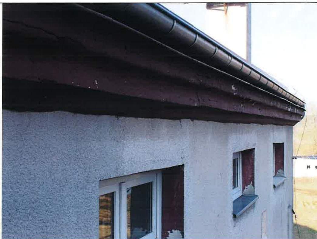
10. Boże; dawny dwór, ob. szkoła podstawowa; elewacja wschodnia (frontowa), segment północny, kondygnacja 1,5 i zwieńczenie. Współczesne wykończenia malarskie ościeży okiennych i gzymsu wieńczącego; głębokie, całościowe uzupełnienia gzymsu zaprawą cementową, zniekształcenia profili, spękania, odspojenia; stolarka PCV.
