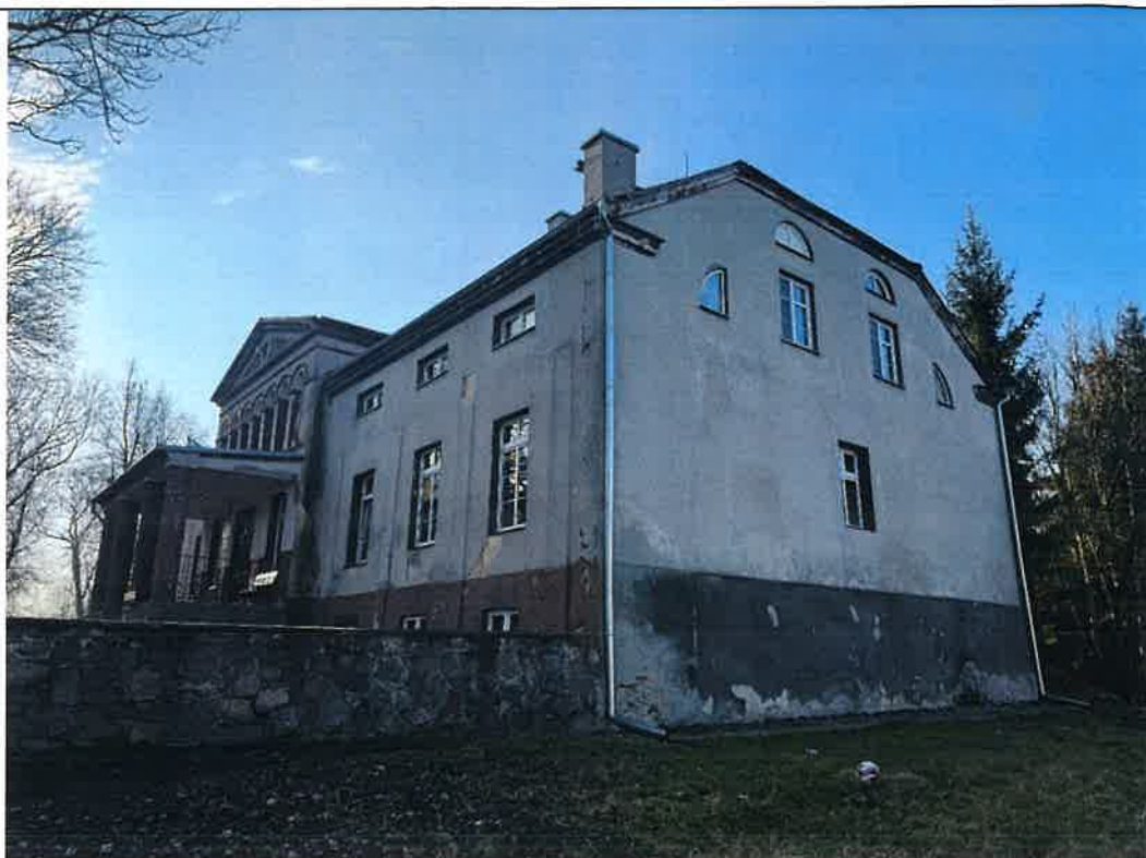
2. Boże; dawny dwór, ob. szkoła podstawowa; elewacja wschodnia (frontowa); widok ogólny od strony południowo-wschodniej. Wykończenie lica i detali współczesnym tynkiem cementowym; ubytki detalu architektonicznego (opasek okiennych, głowic pilastrów, gzymsu kordonowego).
