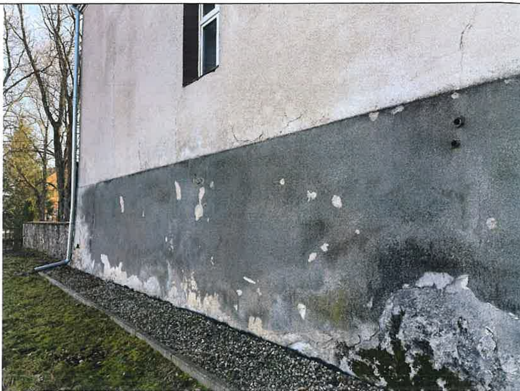
19. Boże; dawny dwór, ob. szkoła podstawowa; elewacja północna (boczna); przyziemie. Uszkodzenia i ubytki wypraw na skutek silnego zawilgocenia strefy fundamentowo-cokołowej; ciemne przebarwienia, skupiska mikroorganizmów roślinnych.
