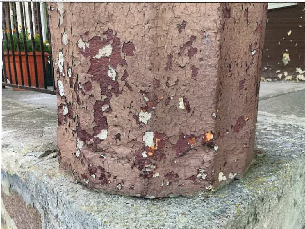
9. Boże; dawny dwór, ob. szkoła podstawowa; elewacja wschodnia (frontowa), przyziemie, ganek. Współczesne wykończenia malarskie kolumn; złuszczenia powłok malarskich, dezintegracja i ubytki podłoża.
