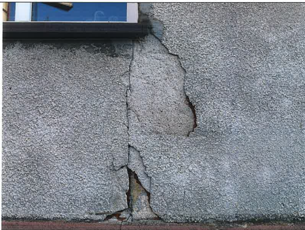
20. Boże; dawny dwór, ob. szkoła podstawowa; elewacja zachodnia (tylna), segment południowy, przyziemie. Uszkodzenia wypraw poniżej otworu okiennego na skutek osłabienia struktury podłoża; głębokie spękania, odspojenia, ubytki zapraw.
