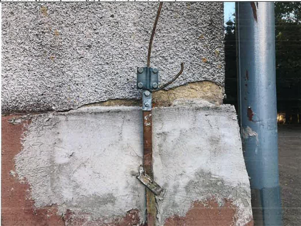
7. Boże; dawny dwór, ob. szkoła podstawowa; elewacja południowa (boczna); przyziemie. Współczesne wykończenie cokołu grubą warstwą zaprawy cementowej z brązową warstwą malarską i późniejsze prowizoryczne uzupełnienia; powyżej cokołu współczesne wykończenia lica dwiema wyprawami cementowymi.
