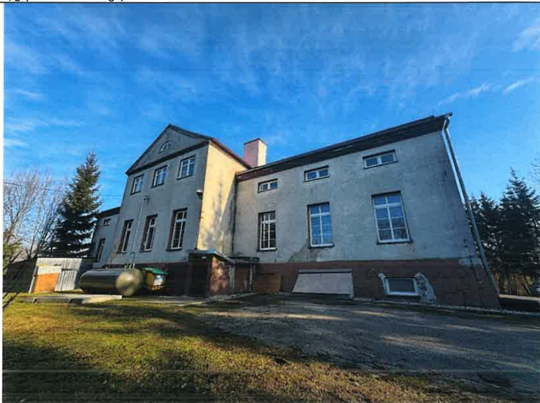
3. Boże; dawny dwór, ob. szkoła podstawowa; elewacja zachodnia (tylna); widok ogólny od strony południowo-zachodniej. Wykończenie lica i detali współczesnym tynkiem cementowym; ubytki detalu architektonicznego (opasek okiennych, gzymsu kordonowego); zaślepiiony podcień i wtórne otwory okienne kondygnacji I ryzalitu; dobudowana szyja piwniczna.
