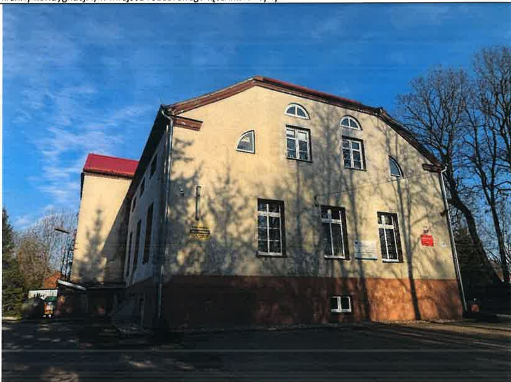
5. Boże; dawny dwór, ob. szkoła podstawowa; elewacja południowa (boczna); widok ogólny od strony południowo-zachodniej. Wykończenie lica i detali współczesnym tynkiem cementowym; ubytki detalu architektonicznego (opasek okiennych); wtórne otwory okienne kondygnacji I na osiach środkowej i zachodniej, w miejscu rozebranego pawilonu oranżerii.
