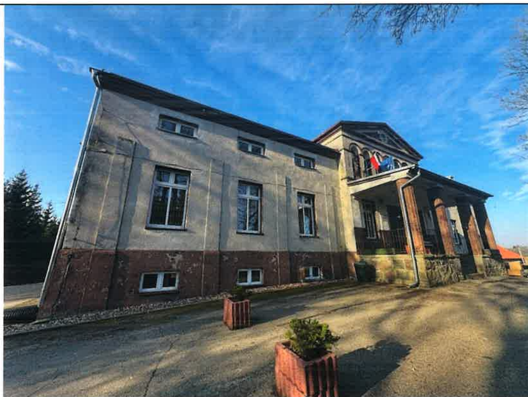
1. Boże; dawny dwór, ob. szkoła podstawowa; elewacja wschodnia – frontowa; widok ogólny od strony południowo-zachodniej. Wykończenie lica i detali współczesnym tynkiem cementowym; ubytki detalu architektonicznego (opasek okiennych, głowic pilastrów, gzymsu kordonowego).
