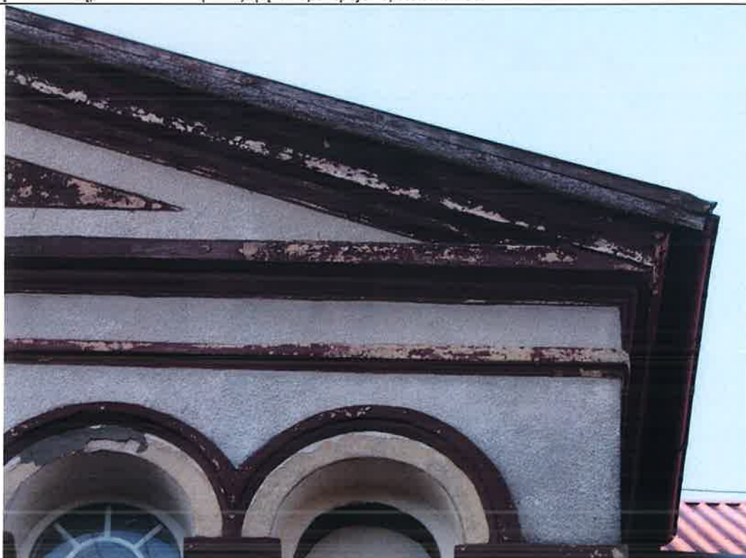
11. Boże; dawny dwór, ob. szkoła podstawowa; elewacja wschodnia (frontowa), pseudoryzalit, kondygnacja II i zwieńczenie. Współczesne opracowania lica i detalu architektonicznego; ubytki wypraw i złuszczenia powłok malarskich.
