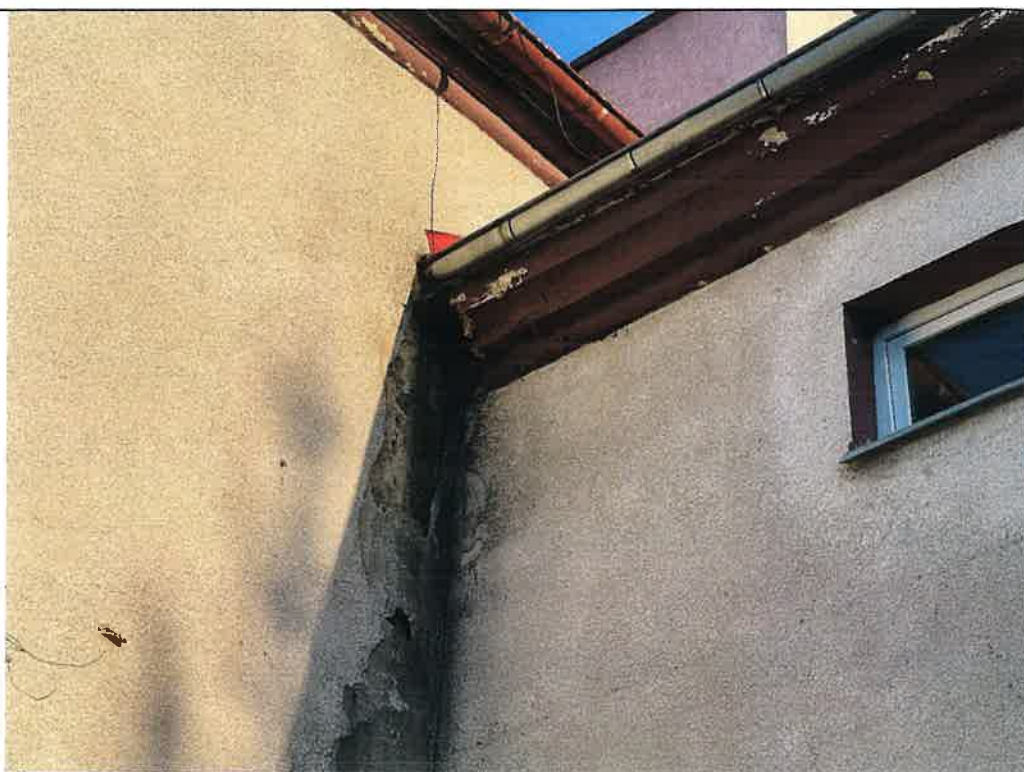
21. Boże; dawny dwór, ob. szkoła podstawowa; elewacja zachodnia (tylna), ryzalit i segment południowy, zwieńczenie. Uszkodzenia wypraw na skutek wadliwego odwodnienia dachu; ciemne zacieki, odspojenia, ubytki zapraw.
