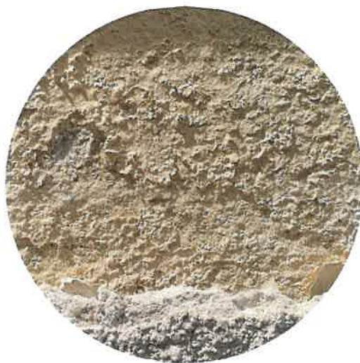
Zbliżenie powierzchni historycznego tynku z zachowaną warstwą farby
