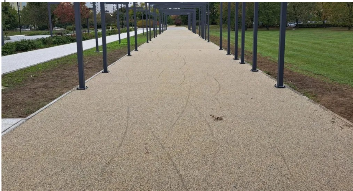
Rys. 3. Przykładowa stylistyka nawierzchni mineralnej z lepiszczem żywicznym, kolor żwir beżowy kwarcowy.
